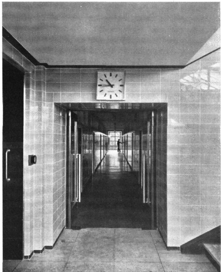
ABB. 33 UND 34 / DAS GEWERKSCHAFTSHAUS IN FRANKFURT AM MAIN / ARCHITEKTEN: MAX TAUT UND FRANZ HOFFMANN, BERLIN / OBEN DIE EINGANGSHALLE MIT DER HAUPTTREPPE UND DER GLASPRISMENWAND GEGEN DIE BÜRGERSTRASSE. UNTEN BLICK IN DEN ZWEIBÜNDIGEN FLUR MIT KOPFLICHT
