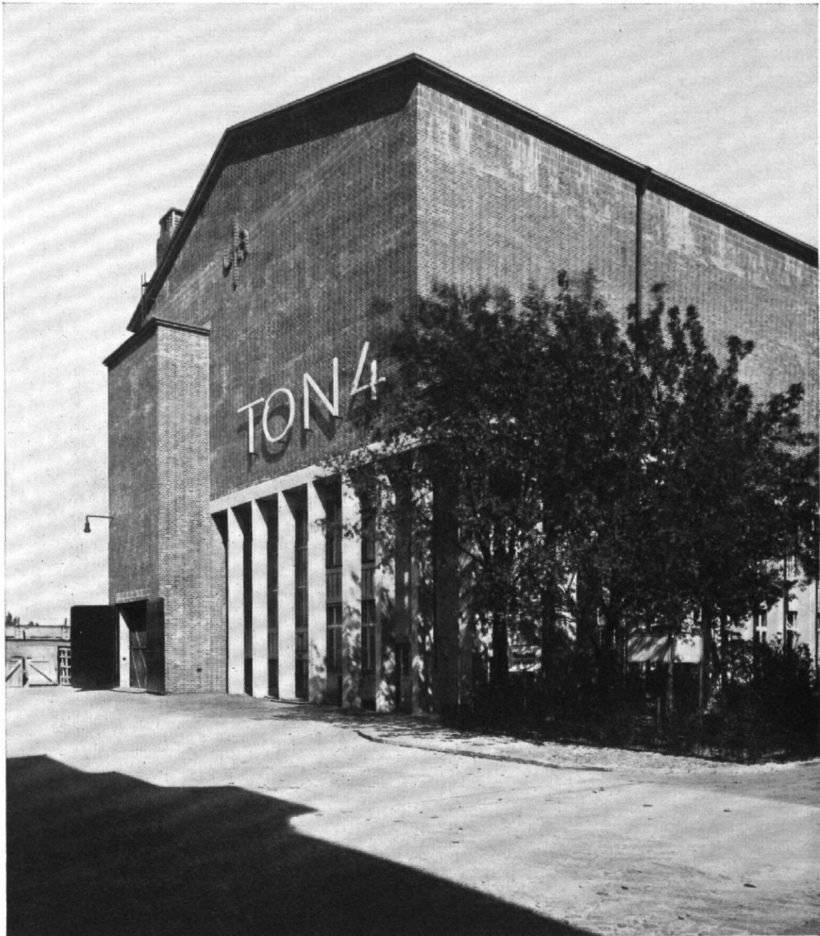
ABB. 1 / TONFILM-ATELIERS IN BERLIN-TEMPELHOF / ARCHITEKT: OTTO KOHTZ, BERLIN / ANSICHT VON WESTEN
