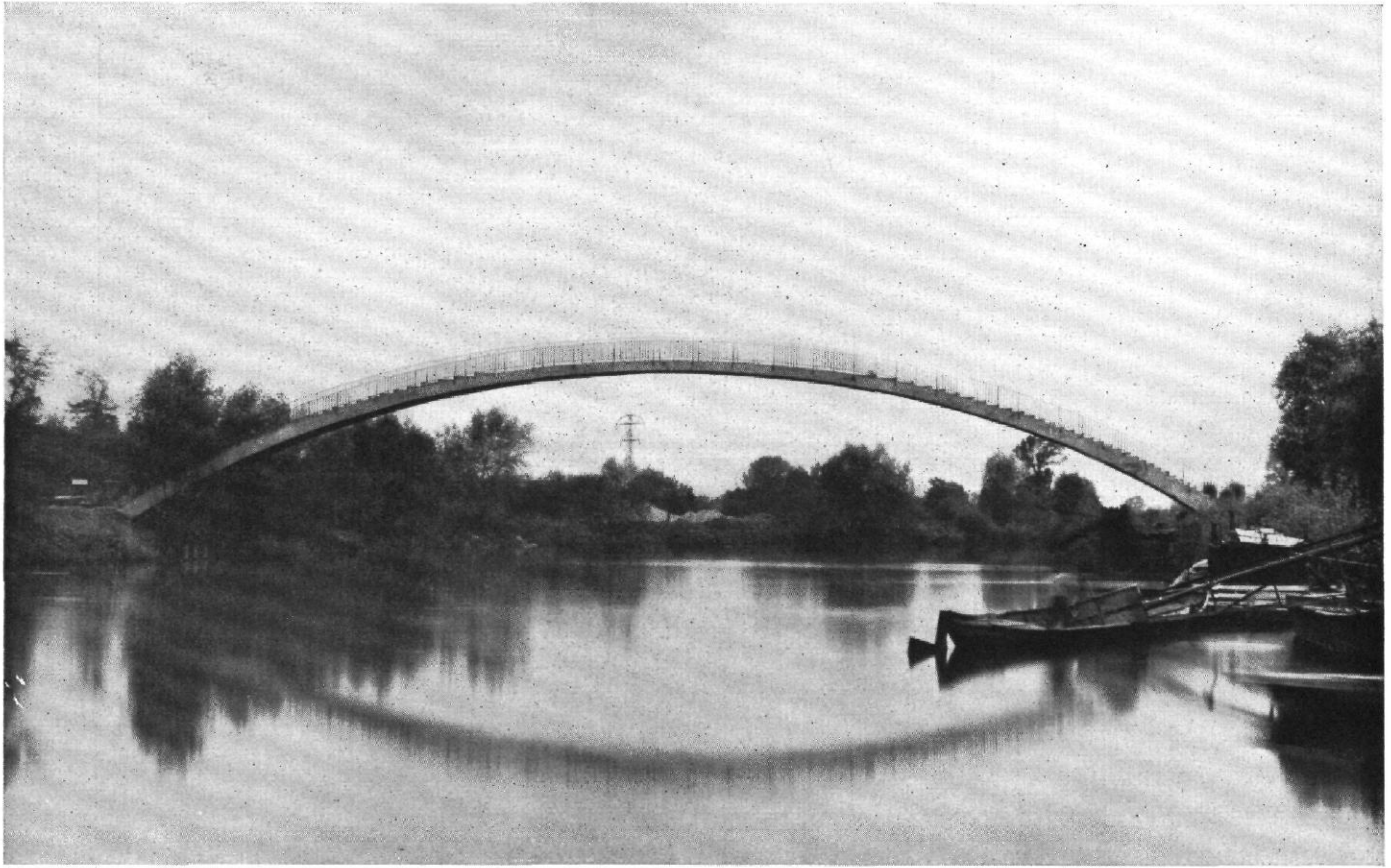
ABB. 12 / DIE ZUM WALDBAD ÜBER DIE SAALE FÜHRENDE FUSSGÄNGERBRÜCKE AUS EISENBETON / ARCHITEKT: KURT JAHN, LEUNA, MITARBEITER BUSSE / DIE BRÜCKE HAT ÜBER 55 m SPANNWEITE, AN DEN STEILEN WIDERLAGERN SIND BEQUEME STUFEN ANGEBRACHT
