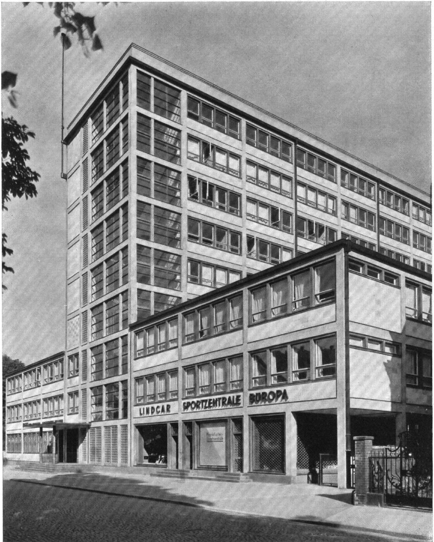
ABB. 3 / DAS GEWERKSCHAFTSHAUS IN FRANKFURT AM MAIN / ARCHITEKTEN: MAX TAUT UND FRANZ HOFFMANN, BERLIN ANSICHT VON DER BÜRGERSTRASSE
