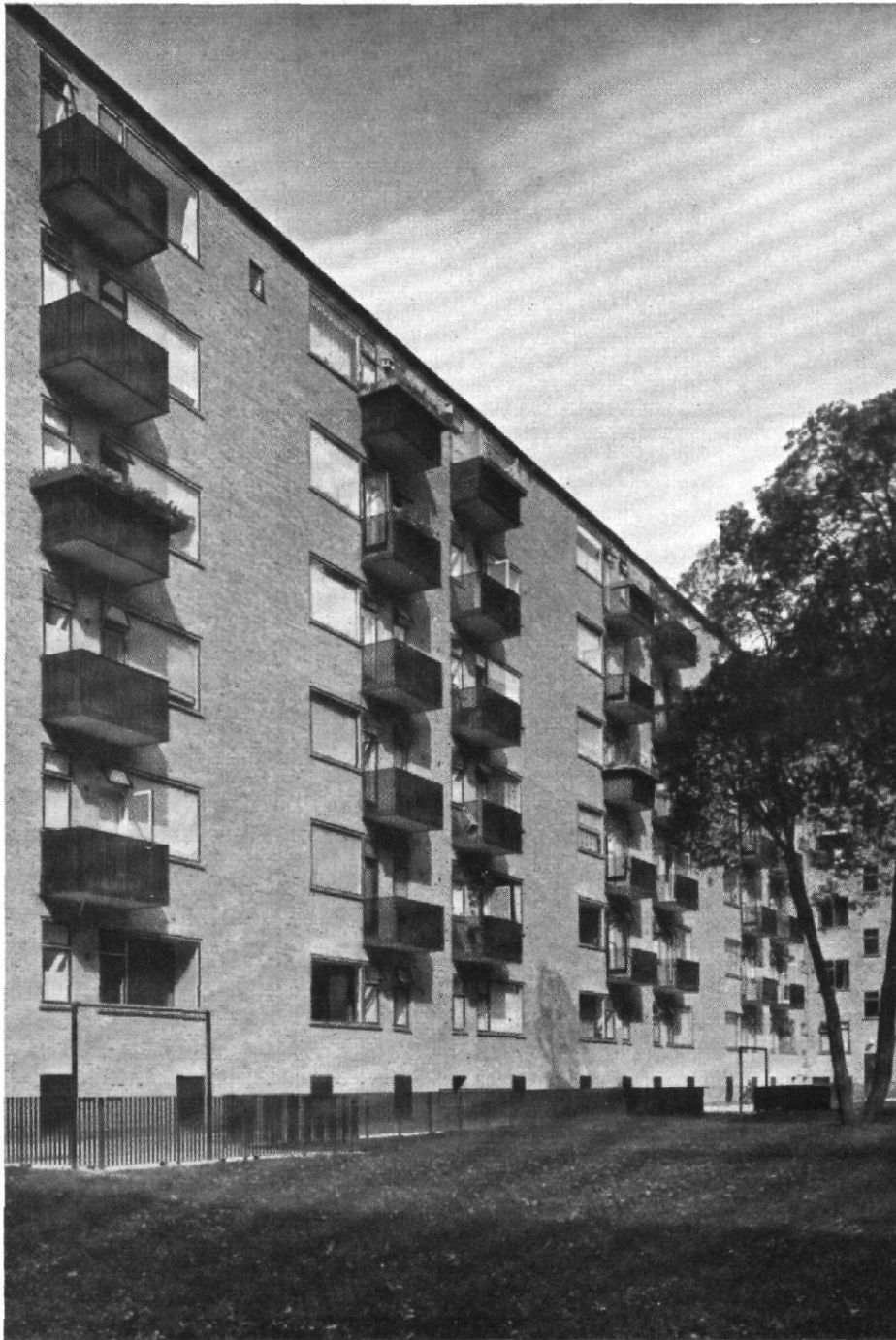
ABB. 8 / WOHNHÄUSER AM HERMAN TRIERS- PLATZ IN KOPENHAGEN / ARCHITEKTEN: K. FISKER UND C. F. MÖLLER, KOPENHAGEN
