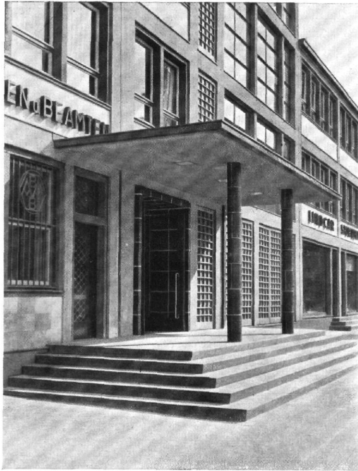
ABB. 4 / DAS GEWERKSCHAFTS- HAUS IN FRANKFURT AM MAIN ARCHITEKTEN: MAX TAUT UND FRANZ HOFFMANN, BERLIN DER EINGANG ZUM BÜROHAUS
