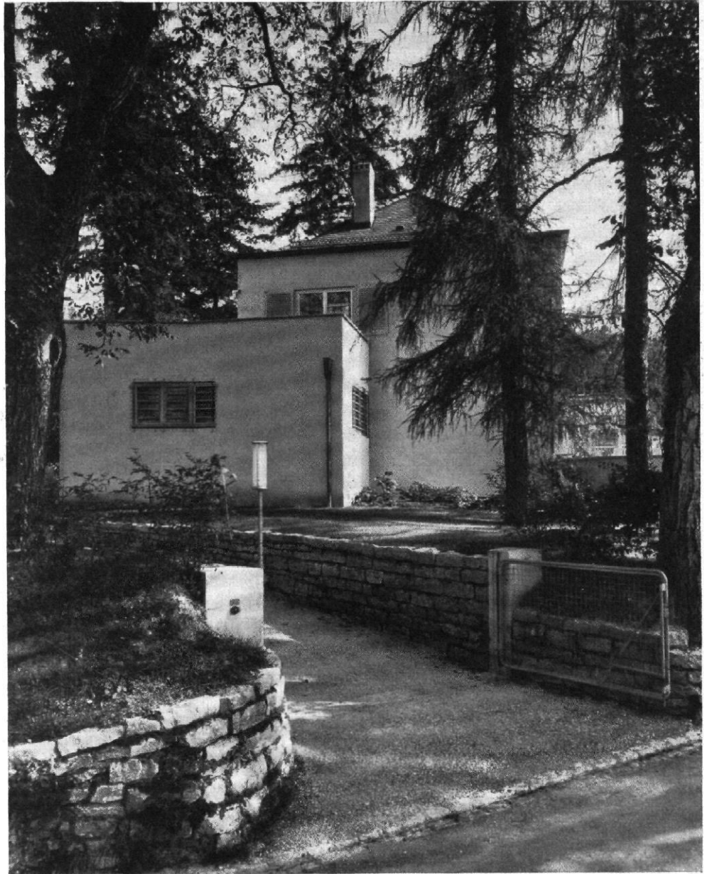
ABB. 4 / LANDHAUS BEI BASEL ARCHITEKTEN: EISENLOHR UND PFENNIG, STUTTGART / BLICK AUF DAS HAUS VON DER ZU- FAHRT. VORN DER KÜCHENFLÜGEL
