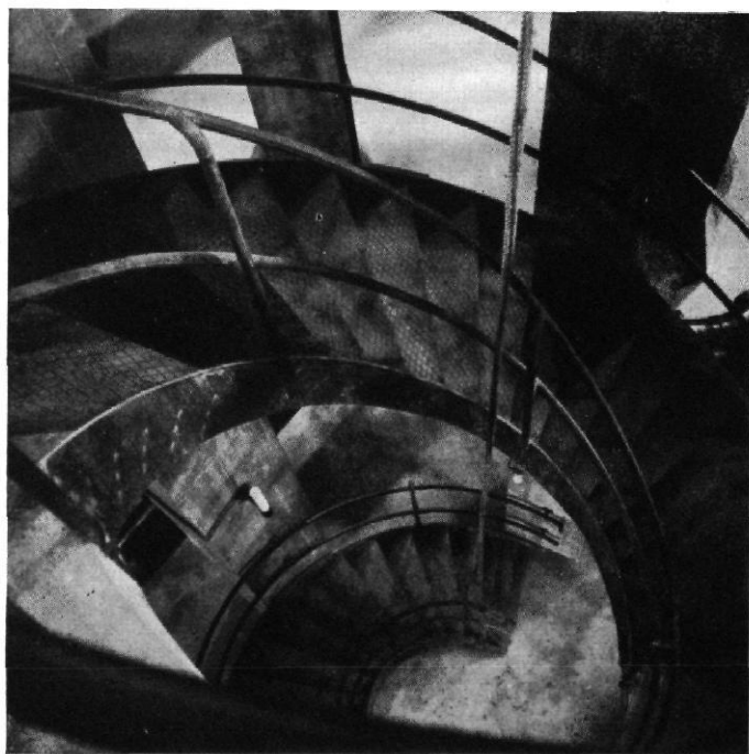
ABB. 5 / WASSERTURM IN BRONSHOJ, DÄNEMARK / ARCHITEKT: POUL HOLSÖE, KOPENHAGEN DIE WENDELTREPPE IM INNEREN
