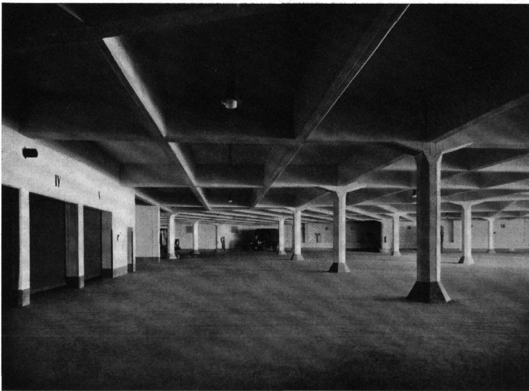
ABB. 4 (OBEN) / GROSS- GARAGE DES DRESDENER KONSUMVEREINS VOR- WÄRTS / ARCHITEKT: KARL SCHMIDT, DRESDEN BLICK IN DIE STÜTZEN- FREIE ERDGESCHOSS- HALLE
