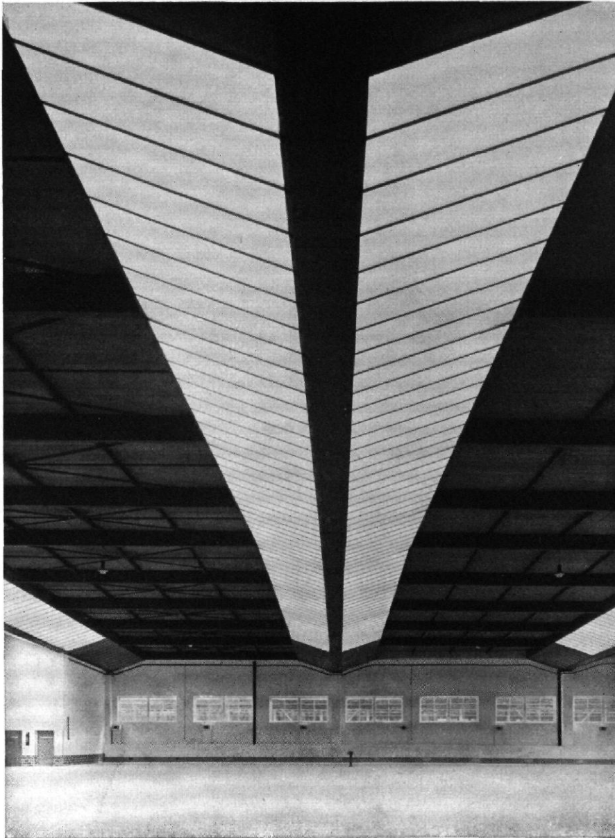
ABB. 1 / GROSSGARAGE DES DRESDENER KONSUMVEREINS VORWÄRTS ARCHITEKT: KARL SCHMIDT, DRESDEN / EINER DER 36 METER LANGEN BINDER
