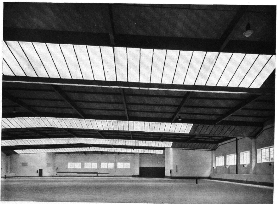
ABB. 2 (OBEN) / GROSS- GARAGE DES DRESDENER KONSUMVEREINS VOR- WÄRTS / ARCHITEKT: KARL SCHMIDT, DRESDEN BLICK AUF DIE DACHBIN- DER MIT DEN OBER- LICHTERN
