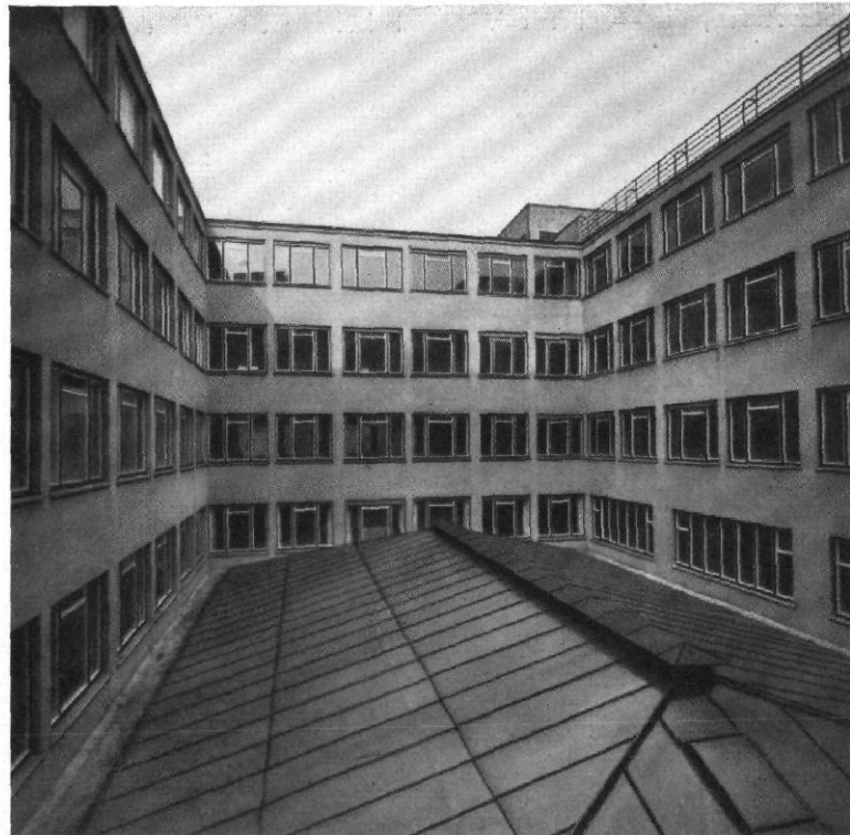
ABB. 9 UND 10 / DER „ZEPPELINBAU“ IN STUTTGART ARCHITEKTEN: PAUL BONATZ UND F. E. SCHOLER, STUTTGART
