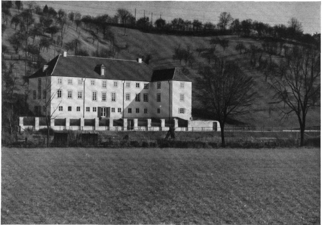
ABB. 16 / DEUTSCHE BURSE IN TÜBINGEN / ARCHITEKT: PAUL SCHMITTHENNER, STUTTGART / ANSICHT DER TALSEITE
