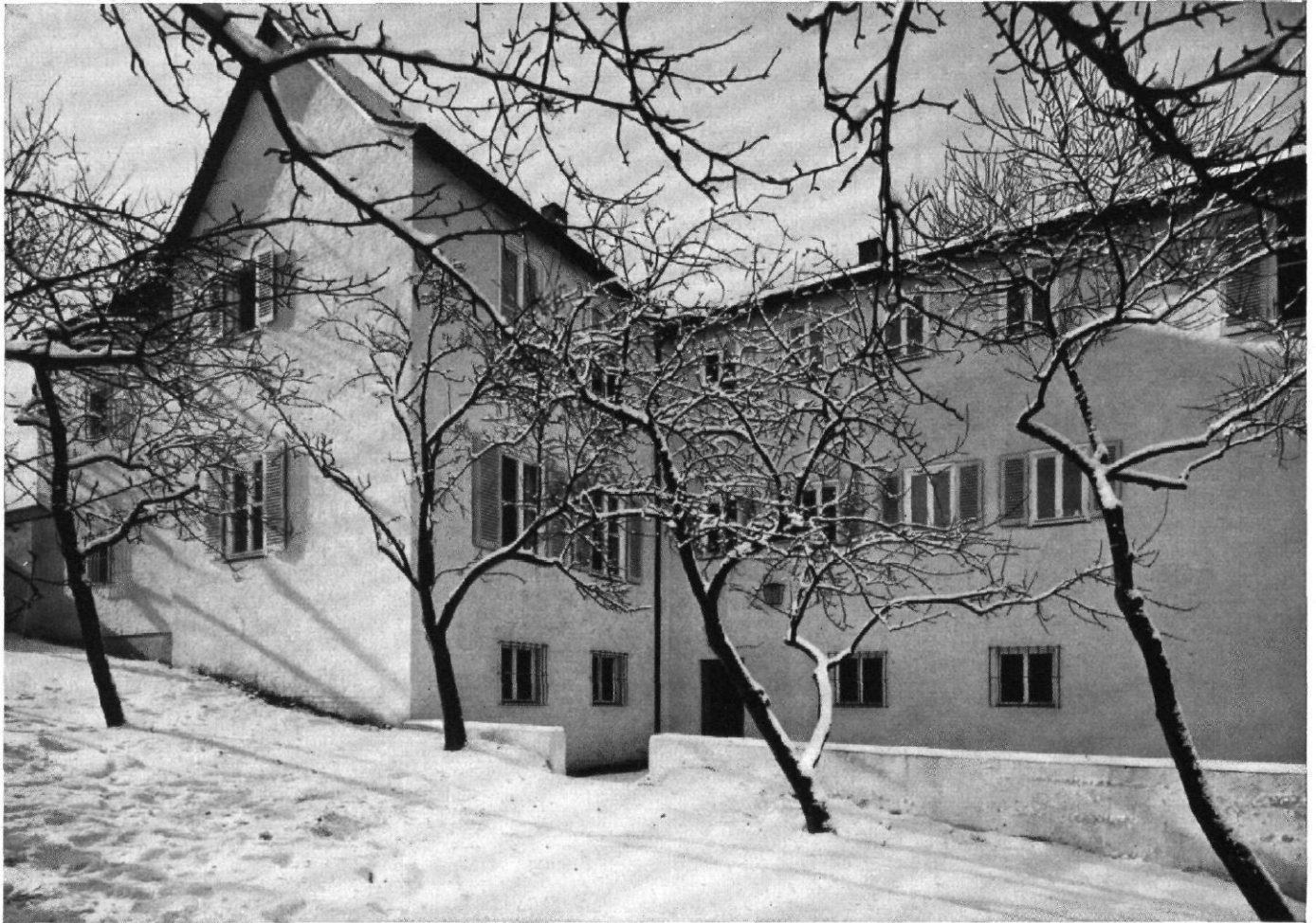
ABB. 13 / HAUS KOHLHAMMER, STUTTGART / ARCHITEKT: KONRAD FURRER, STUTTGART B L I C K V O N N O R D O S T E N
