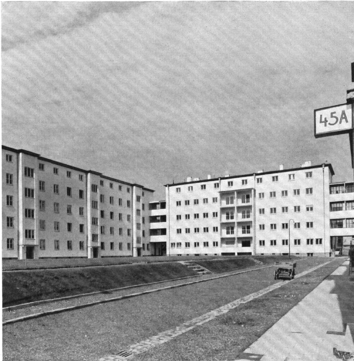
ABB. 5 / MIETSHAUBLOCK IN STUTTGART-CANNSTATT / ARCHITEKT: ALBRECHT GOETHE, MÜNCHEN BLICK IN EINEN WOHNHOF
