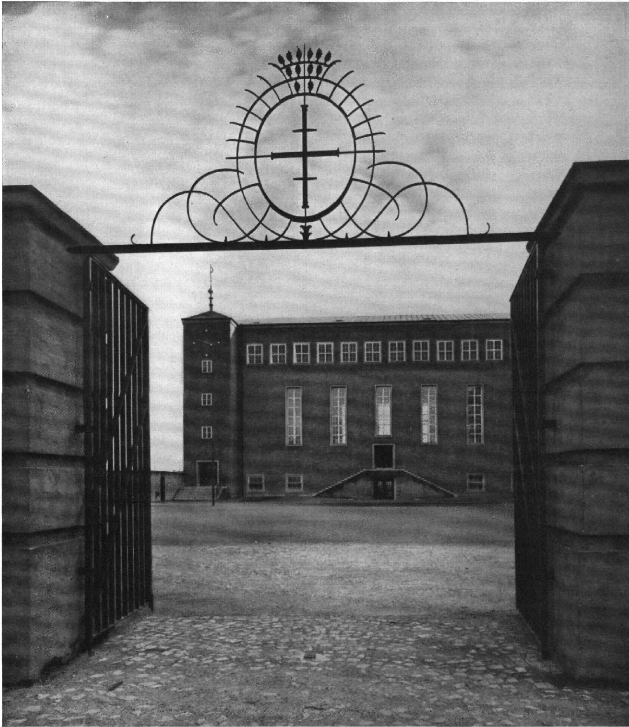
ABB. 1 HOHENSTEINSCHULE IN STUTTGART-ZUFFENHAUSEN / ARCHITEKT: PAUL SCHMITTHENNER, STUTTGART / BLICK AUF DIE TURNHALLE
