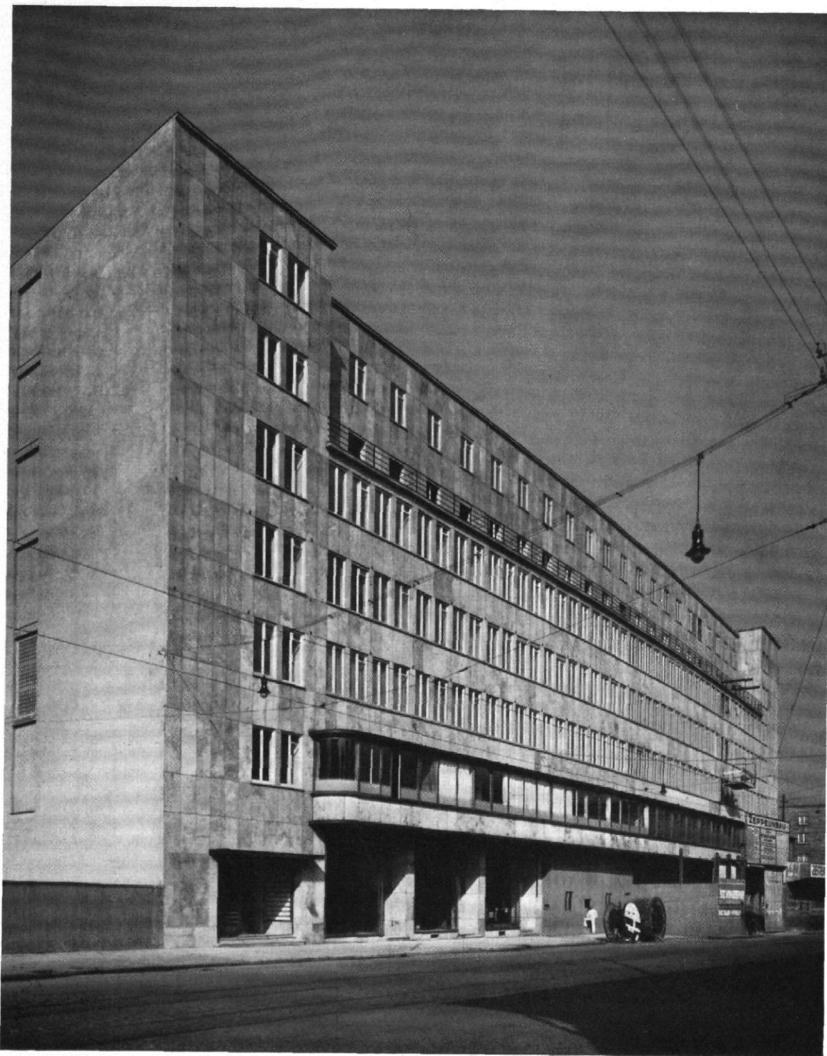
ABB. 2 / DER „ZEPPELINBAU“ IN STUTTGART / ARCHITEKTEN: PAUL BONATZ UND F. E. SCHOLER, STUTTGART DIE FRONT IN DER LAUTENSCHLAGERSTRASSE
