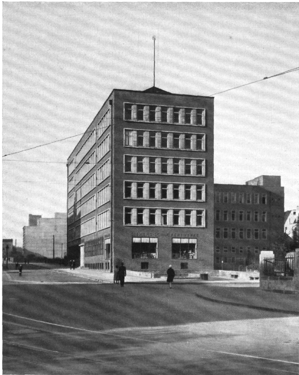
ABB. 1 / DAS SIEMENSHAUS IN ESSEN / ARCHITEKT: HANS HERTLEIN, BERLIN
