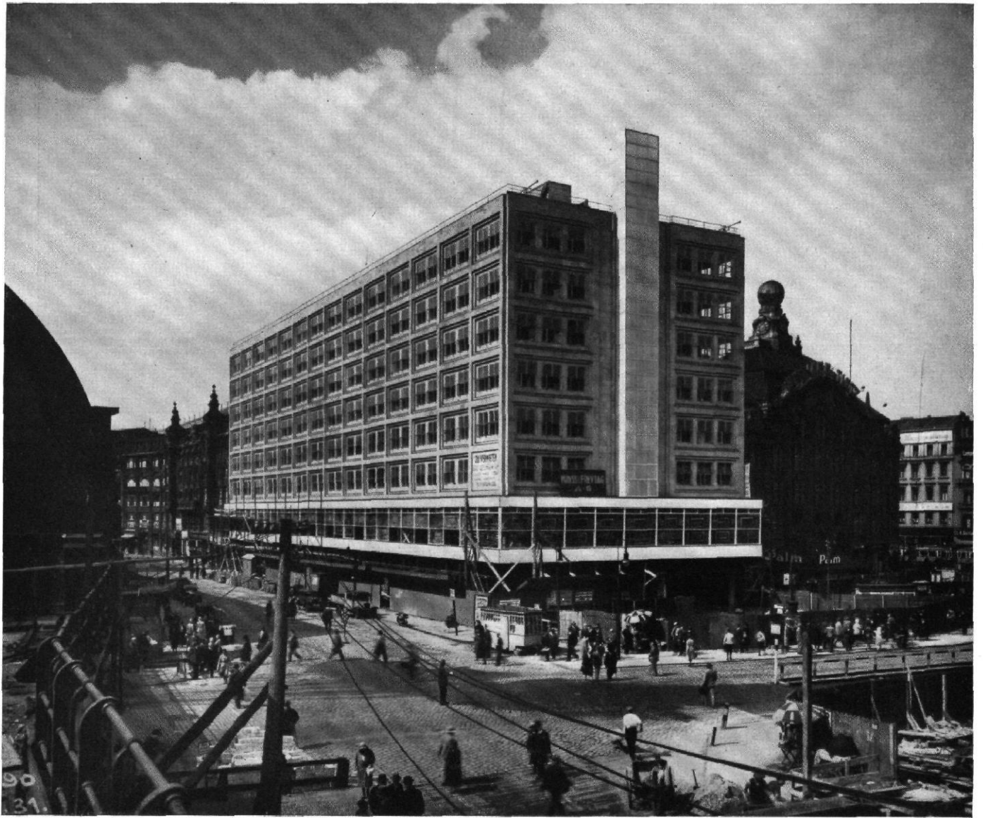
ABB. 7 / DAS HOCHHAUS AM ALEXANDERPLATZ IN BERLIN / ARCHITEKT: PETER BEHRENS, BERLIN / BLICK VON DER STADTBAHN AUS. IM ERSTEN OBERGESCHOSS DIE UM DAS HAUS GEZOGENE GLASGALERIE FÜR GESCHÄFTSAUSLAGEN, DARÜBER DER GLÄSERNE TREPPENTURM
