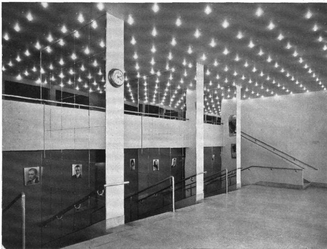
ABB. 5 / KINO „FLAMMAN“ IN STOCKHOLM / ARCHI- TEKT: UNO AHREN, STOCKHOLM / BLICK IN DIE KASSENHALLE MIT AUFGANG ZUM RANG
