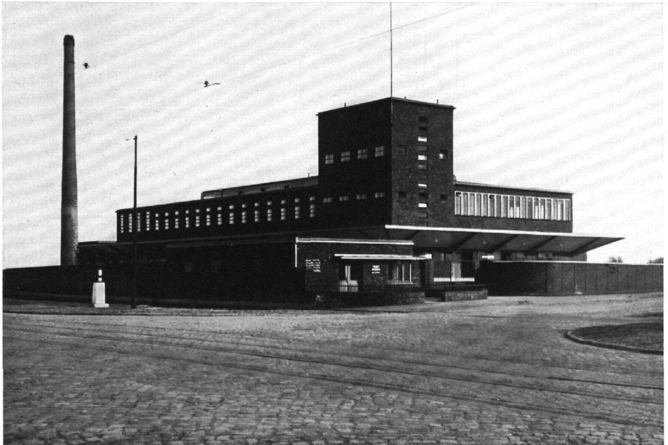
ABB. 1 / MOLKEREI DES KONSUM-BAU- UND SPARVEREINS „PRODUKTION“, HAMBURG / ARCHITEKT: HERMANN DISTEL, HAMBURG DER ECKTURM BEHERBERGT DAS WASSERBASSIN
