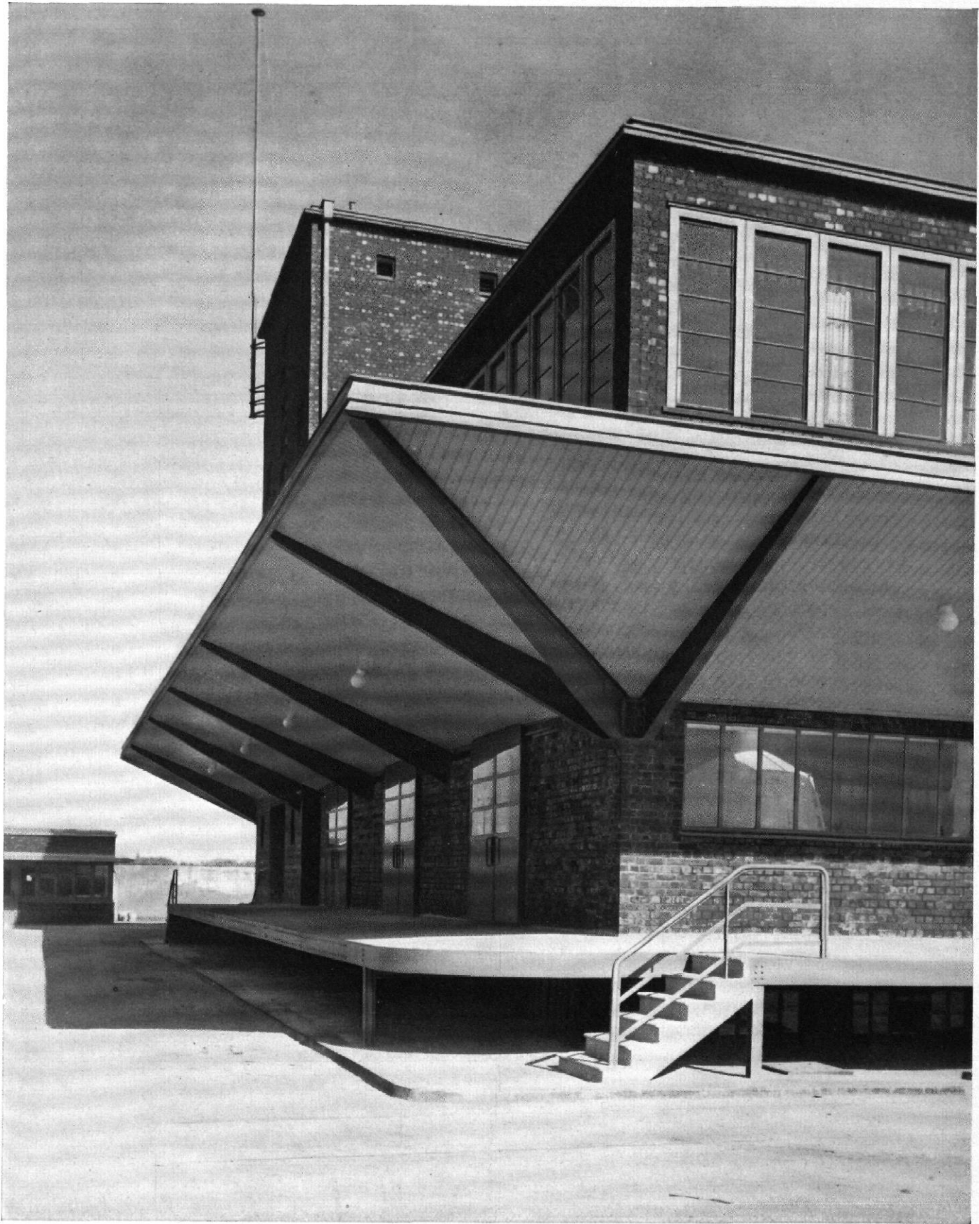
ABB. 2a / MOLKEREI DES KONSUM-BAU- UND SPARVEREINS „PRODUKTION“, HAMBURG / ARCHITEKT: HERMANN DISTEL, HAMBURG LADERAMPE MIT VORDACH
