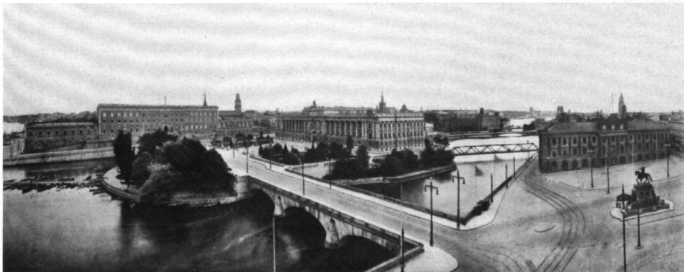
ABB. 2 / „HELGEANDSHOLMEN“ IN STOCKHOLM MIT DEM SCHLOSS (LINKS) UND DEM REICHSTAGSGEBÄUDE (MITTE) IM HEUTIGEN ZUSTAND
