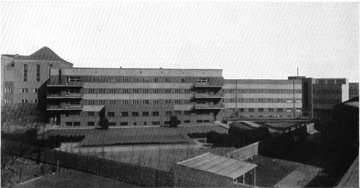
ABB. 10 / ALTERSHEIM DER JÜDISCHEN GEMEINDE IN BERLIN / ARCHITEKT: ALEXANDER BEER, BERLIN GESAMTANSICHT DES DREIECKIGEN GRUNDSTÜCKS MIT DER RÜCKFRONT, LINKS DER BETSAAL
