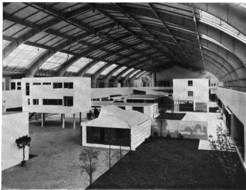
ABB. 4 / VON DER BERLINER BAUAUSSTELLUNG / BLICK IN DIE HALLE II VON SÜDEN LINKS DAS HAESLERSCHE HAUS, RECHTS EIN REIHENHAUS VON
