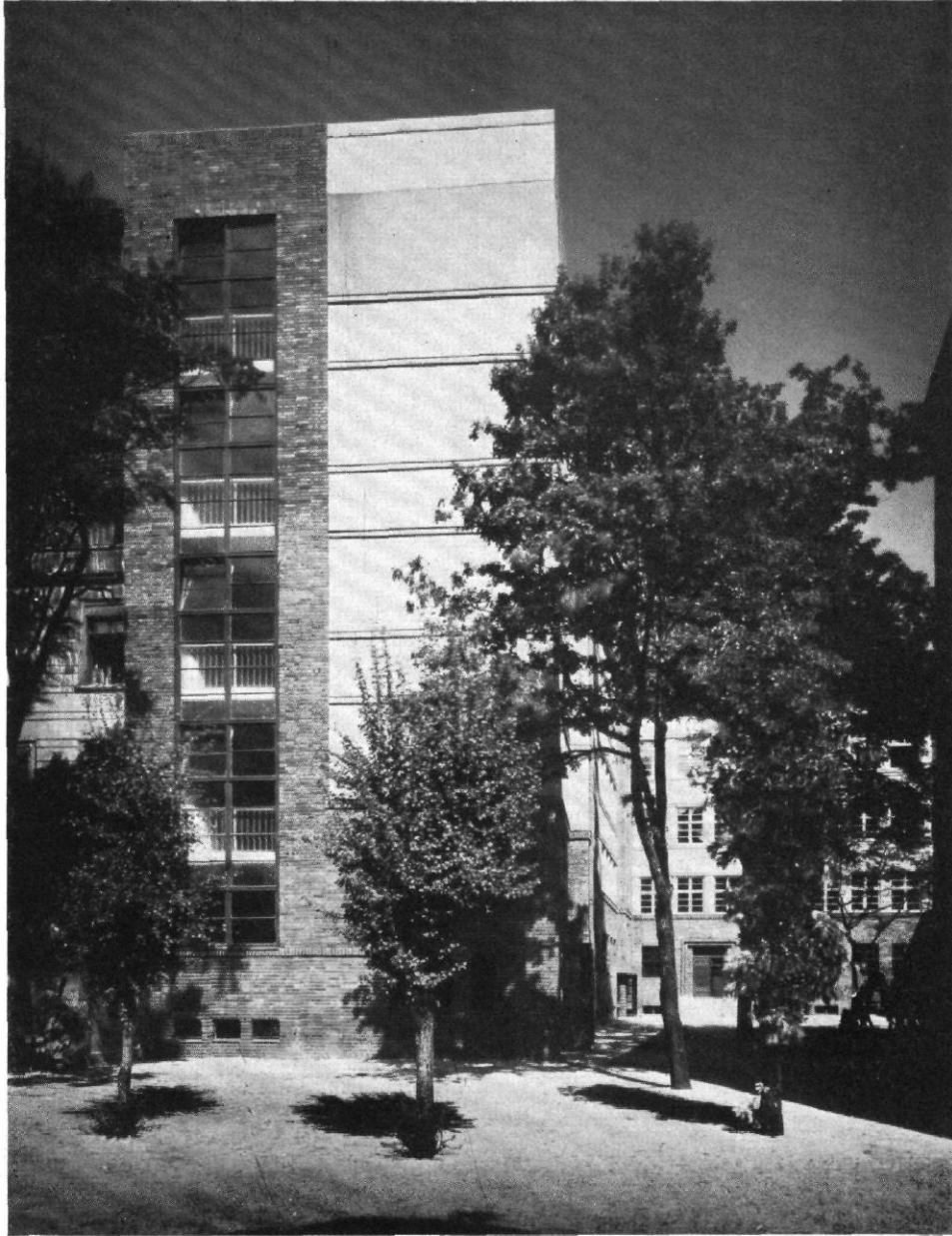
ABB. 6 / VOLKSSCHULE DER JÜDISCHEN GEMEINDE IN BERLIN / ARCHITEKT: ALEXANDER BEER DER HOFFLÜGEL MIT TREPPENHAUS
