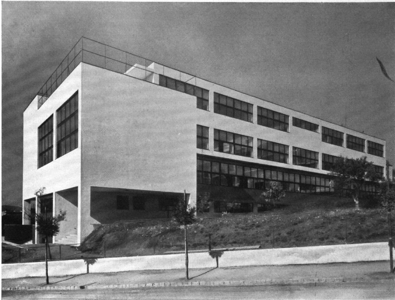
ABB. 3 / FRAUENSCHULE IN BRÜNN / ARCHITEKT: BOHUSLAV FUCHS, BRÜNN / AUSSENANSICHT DES TURNSAALS UND DER LEHRSALE
