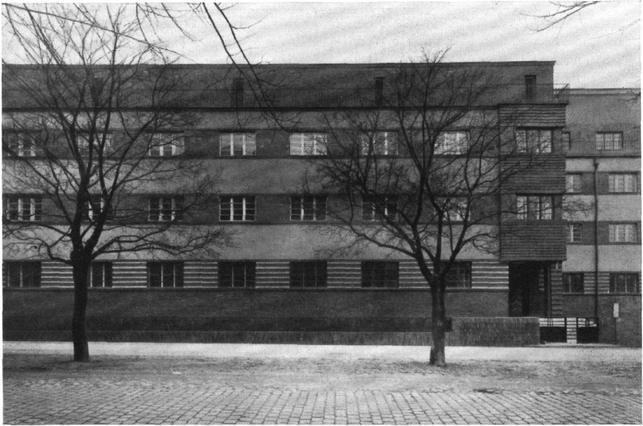
ABB. 7 ALTERSHEIM DER JÜDISCHEN GEMEINDE IN BERLIN / ARCHITEKT: ALEXANDER BEER / STRASSENANSICHT DES LINKEN FLÜGELS
