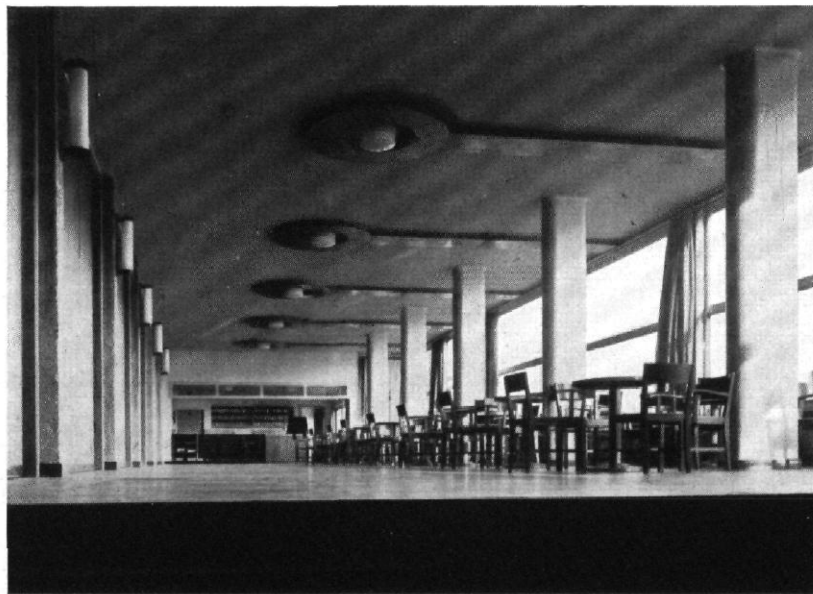
ABB. 16 BIS 18 / STUDENTENHAUS IN JENA ARCHITEKT: ERNST NEUFERT, BERLIN LINKS DER ERFRISCHUNGSRaum, AN DER DECKE DIE LÜFTUNG (VGL. GRUNDRISSE ABB. 7). RECHTS BLICK IN DIE MENSA VOM VORRAUM AUS UND BLICK IN DEN WASCHRAUM
