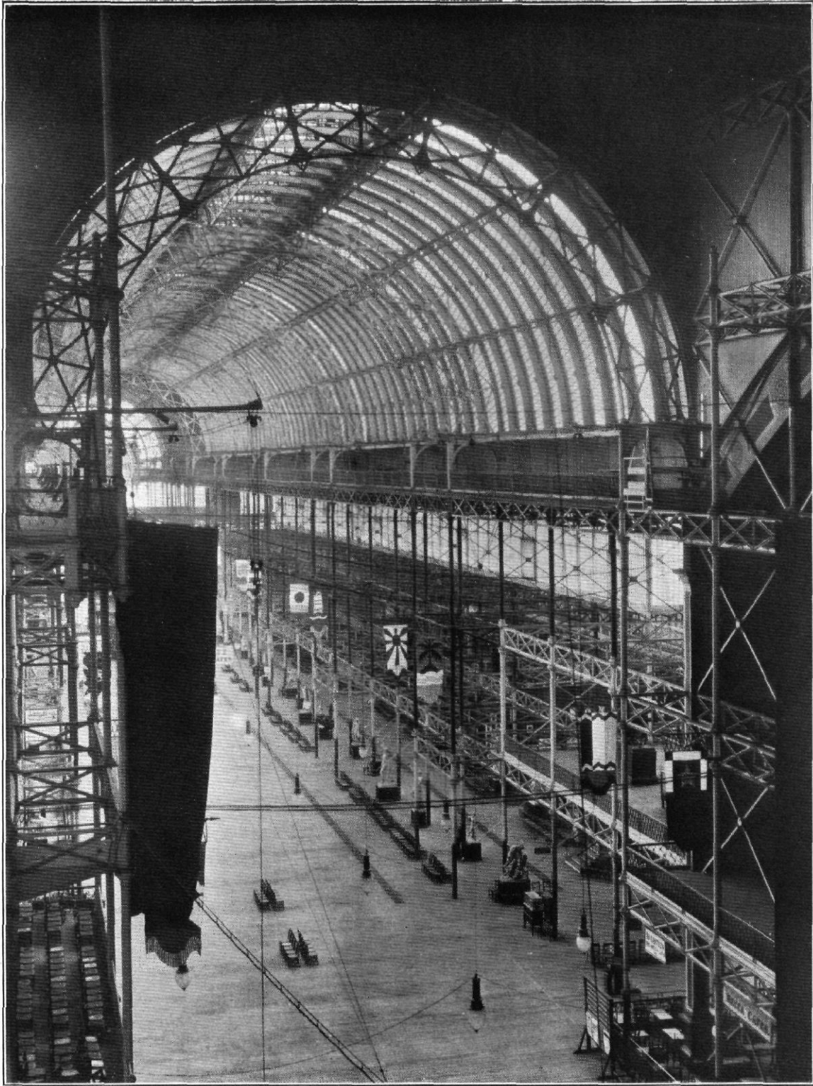
ABB. 5 / DER LONDONER KRISTALLPALAST / ARCHITEKT: JOSEPH PAXTON / BLICK IN DAS INNERE DER QUERHALLE
