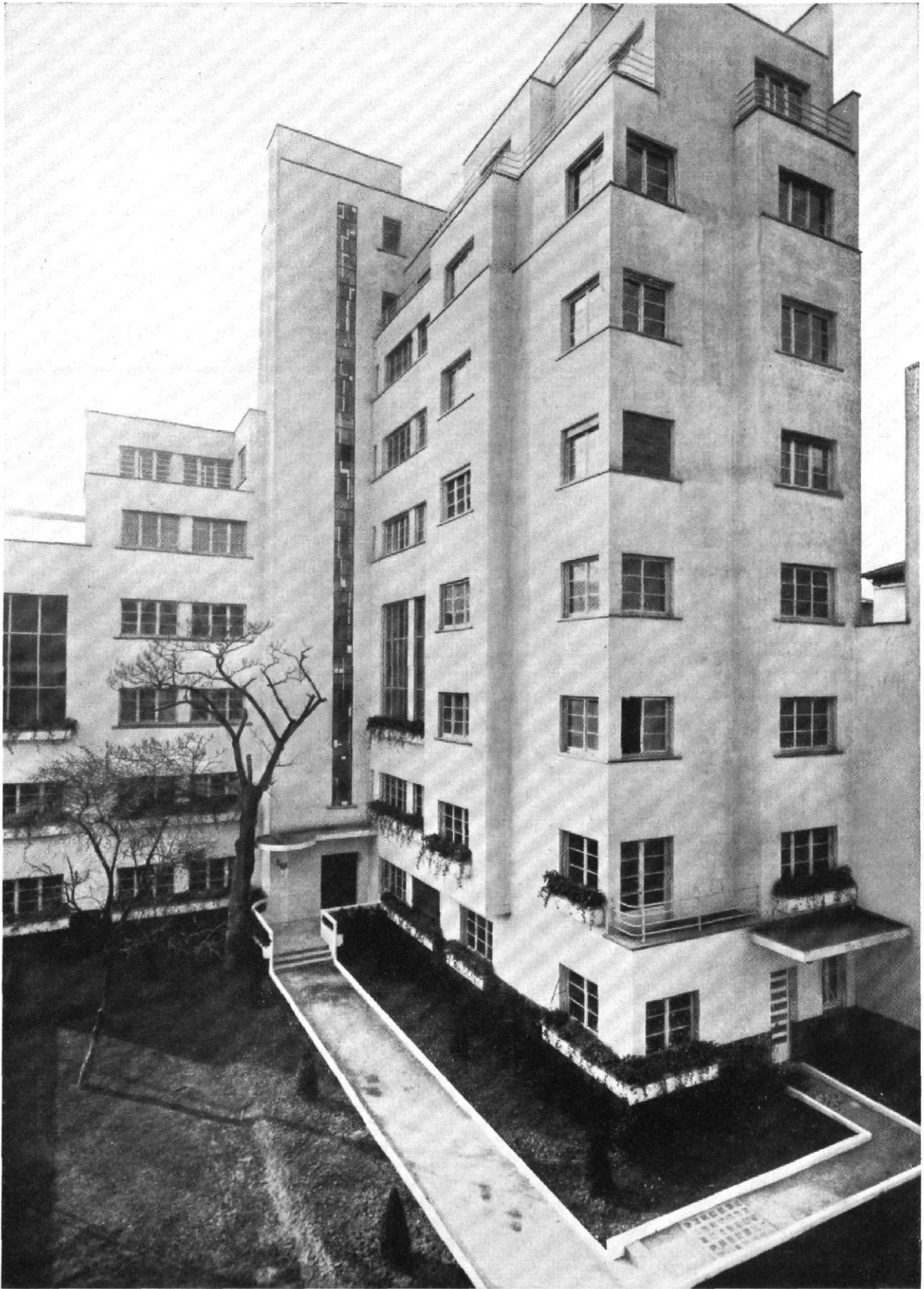
ABB. 1 / EIN MIETSHAUS IN PARIS / ARCHITEKT: ROBERT MALLET-STEVENS, PARIS / GESAMTANSICHT
