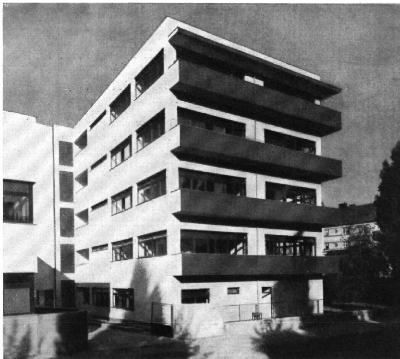
ABB. 4 UND 5 / STUDENTENHEIM IN BRÜNN / ARCHITEKT: BOHUSLAV FUCHS, BRÜNN
