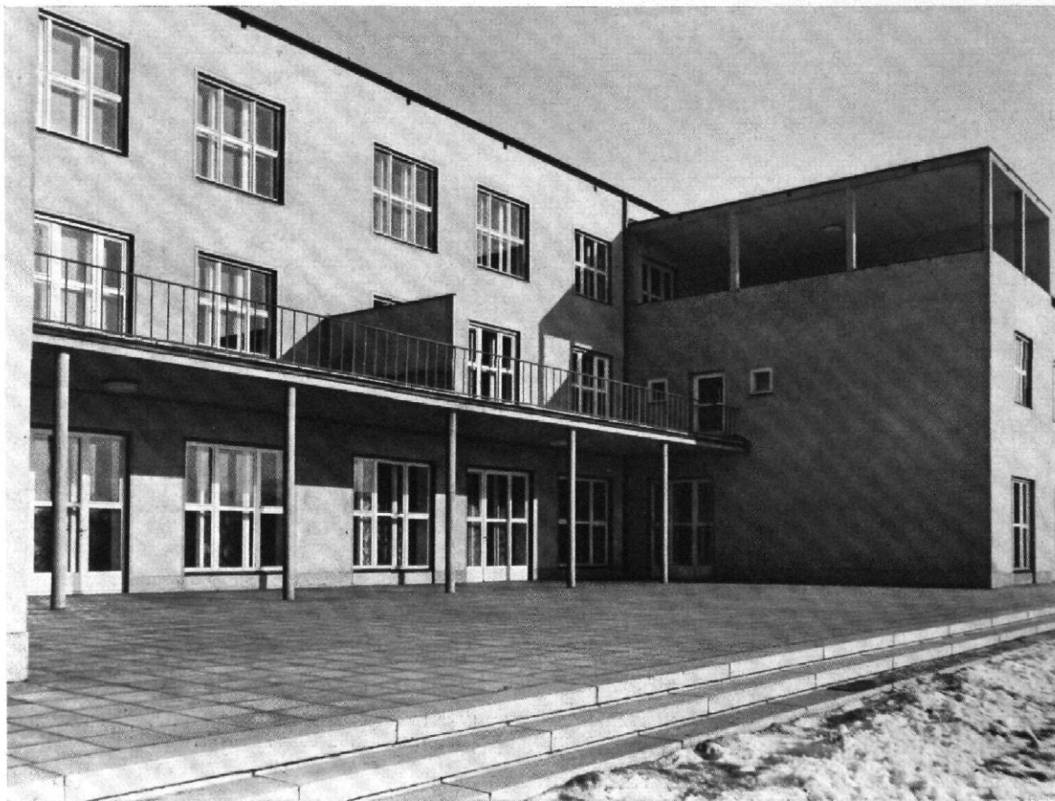
ABB. 1 / ERWEITERUNGSBAU DER NERVENHEILANSTALT IN CHEMNITZ / ARCHITEKT: FRED OTTO, CHEMNITZ TERRASSE AN DER SÜDSEITE
