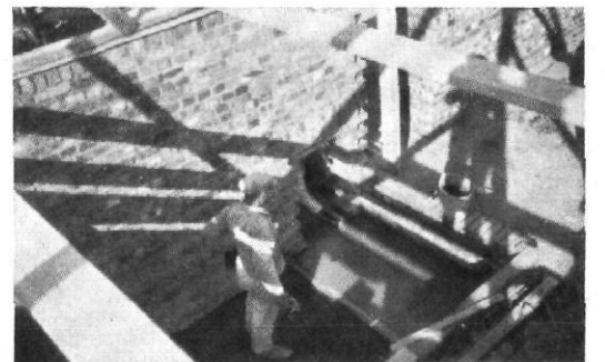
Abb. 14 (links) / Die Montage ging denkbar leicht, ohne jede Maschine vor sich, mit wenigen Leuten, die sich die infolge geringer Abmessungen sehr leichten Hölzer zureichten. Abb. 15 (rechts) / Während der Montage fertigten unter den abgedeckten Etagen die Maurer bereits den Estrich für den Heizkeller.
