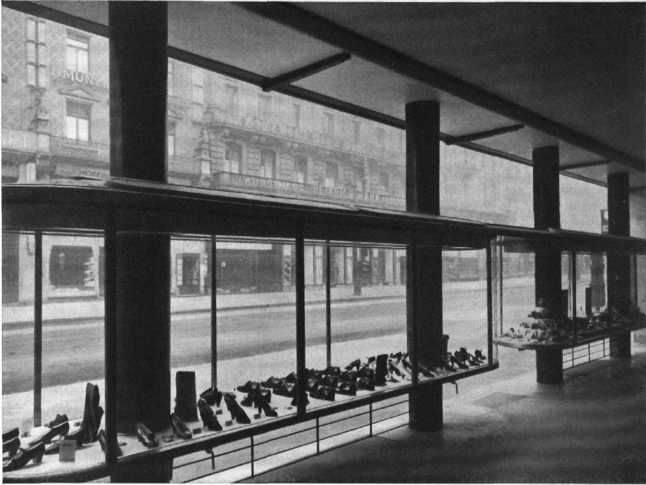
ABB. 8 / GESCHÄFTSHAUS-UMBAU IN FRANKFURT AM MAIN ARCHITEKT: HERMANN ZWEIGENTHAL, BERLIN DIE BEIDEN SCHWEBEVITRINEN FÜR DIE GESCHÄFTE JACOBY UND DR. ALBERSHEIM
