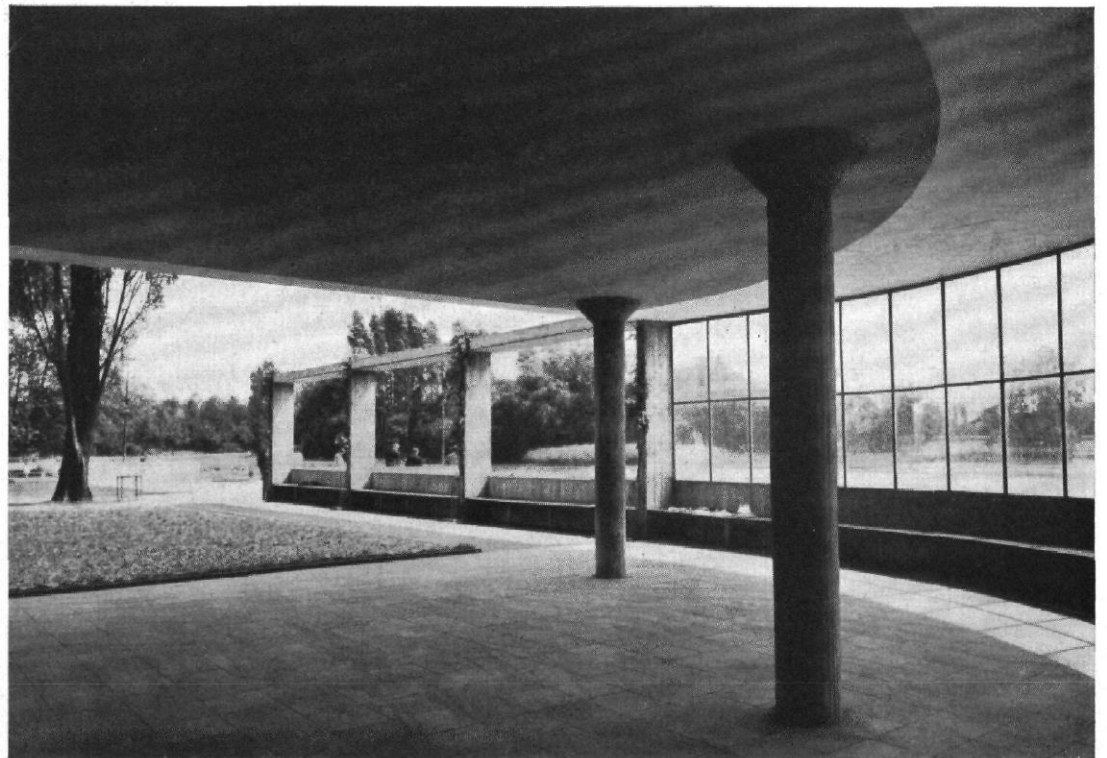
ABB. 8 / ZUR BERLINER AUSSTELLUNG „POELZIG UND SEINE SCHÜLER“ UNTERSTANDSHALLE IM FRANKFURTER OSTPARK ARCHITEKT: MAX CETTO, FRANKFURT AM MAIN INNENANSICHT
