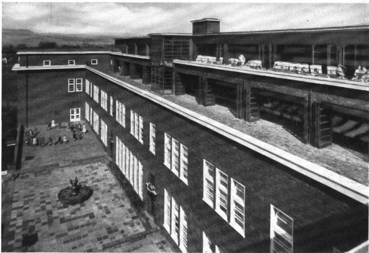
ABB. 3 / KINDERHEIM IN PYRMONT / ARCHITEKT: HEINZ LASSEN, BERLIN BLICK AUF DIE LIEGETERRASSEN MIT DEM BEOBACHTUNGSTURM
