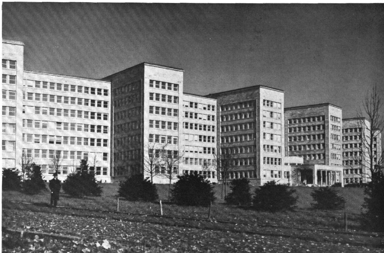
ABB. 1 / VERWALTUNGSGEBÄUDE DER I. G. FARBEN IN FRANKFURT AM MAIN / ARCHITEKT: HANS POELZIG, BERLIN / GESAMTANSICHT
