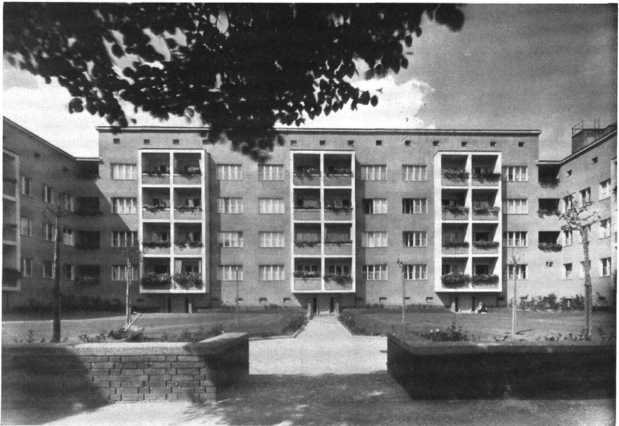
ABB. 22 / DIE NEUE SIEDLUNG LINDENHOF IN BERLIN / ARCHITEKT: HEINZ LASSEN, BERLIN / BLICK IN EINEN VORGARTENHOF
