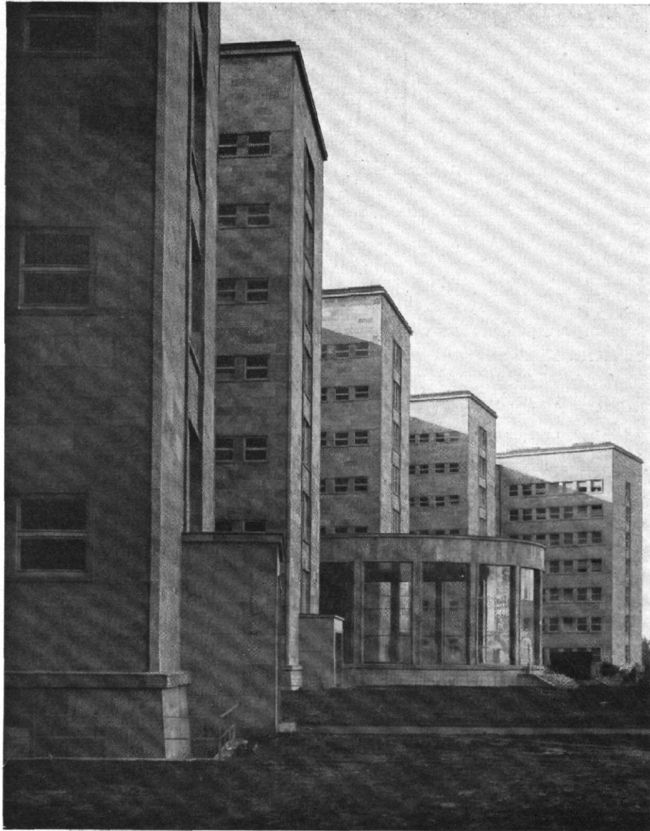
ABB. 23 / VERWALTUNGSGEBÄUDE DER I. G. FARBEN IN FRANKFURT AM MAIN ARCHITEKT: HANS POELZIG, BERLIN / DIE RÜCKFRONT MIT DER AUSSTELLUNGSHALLE
