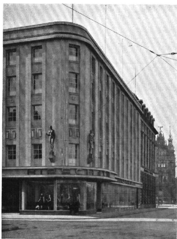
Abb. 13 / Umbau eines Geschäftshauses in Hamburg
