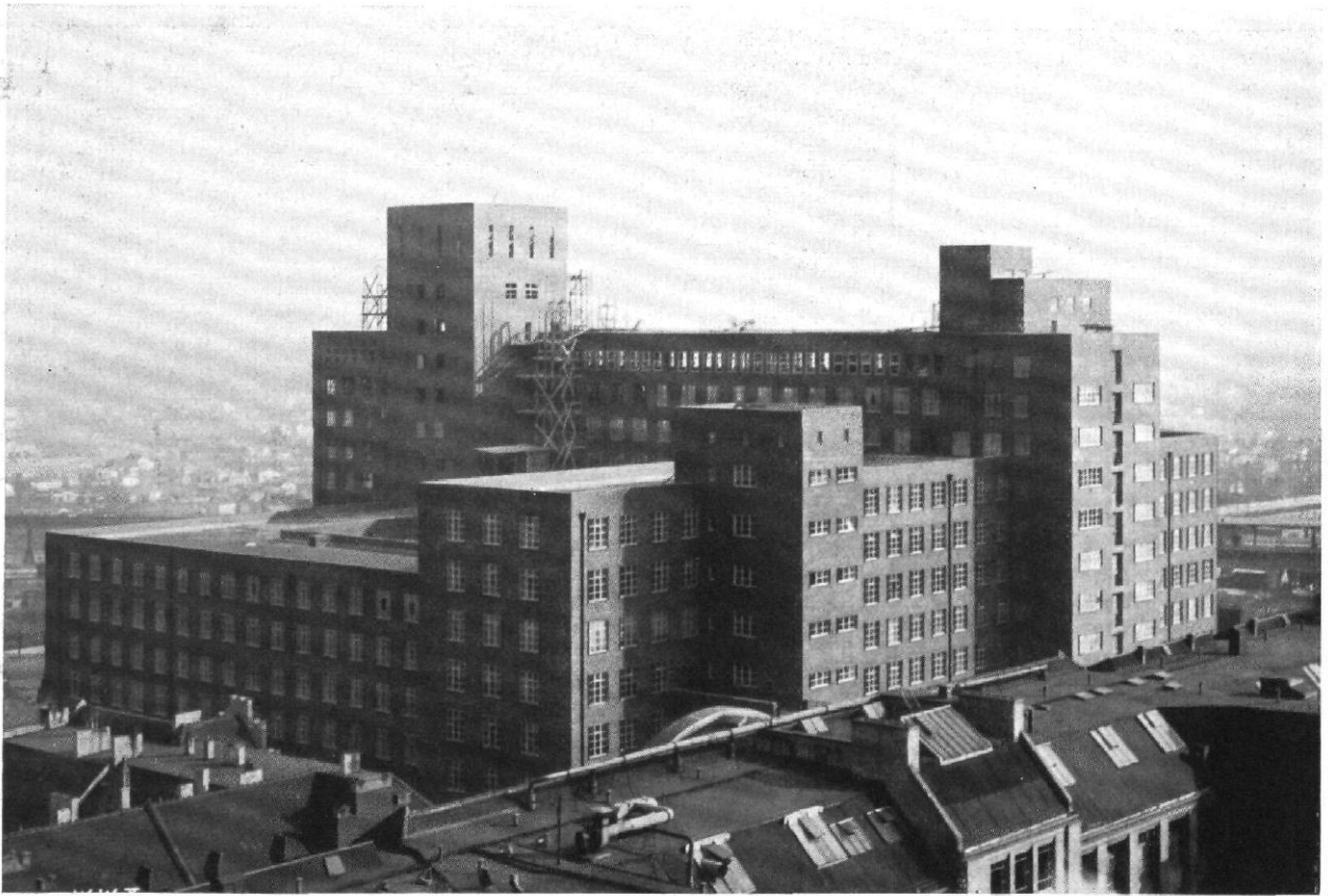
Abb. 1 / Das neue Wernerwerk in Berlin-Siemensstadt im Bau / Architekt: Hans Hertlein, Berlin
