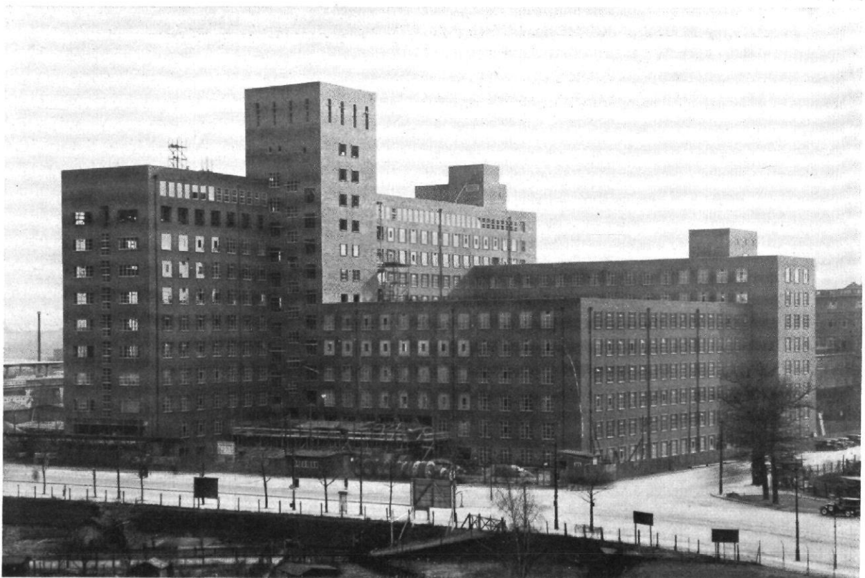
Abb. 2 / Das neue Wernerwerk in Berlin-Siemensstadt im Bau / Architekt: Hans Hertlein, Berlin
