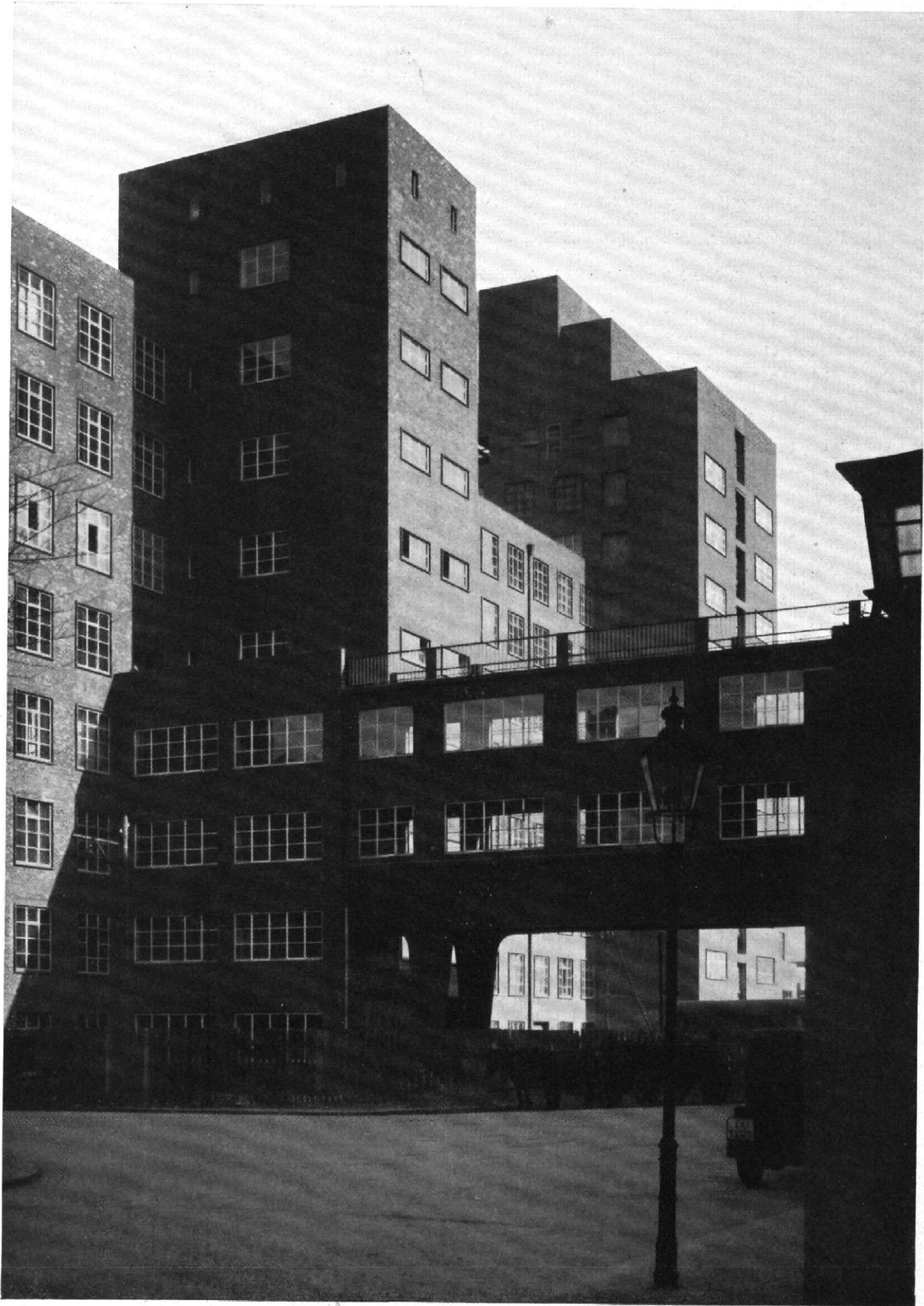
Abb. 3 / Das neue Wernerwerk in Berlin-Siemensstadt im Bau / Architekt: Hans Hertlein, Berlin
