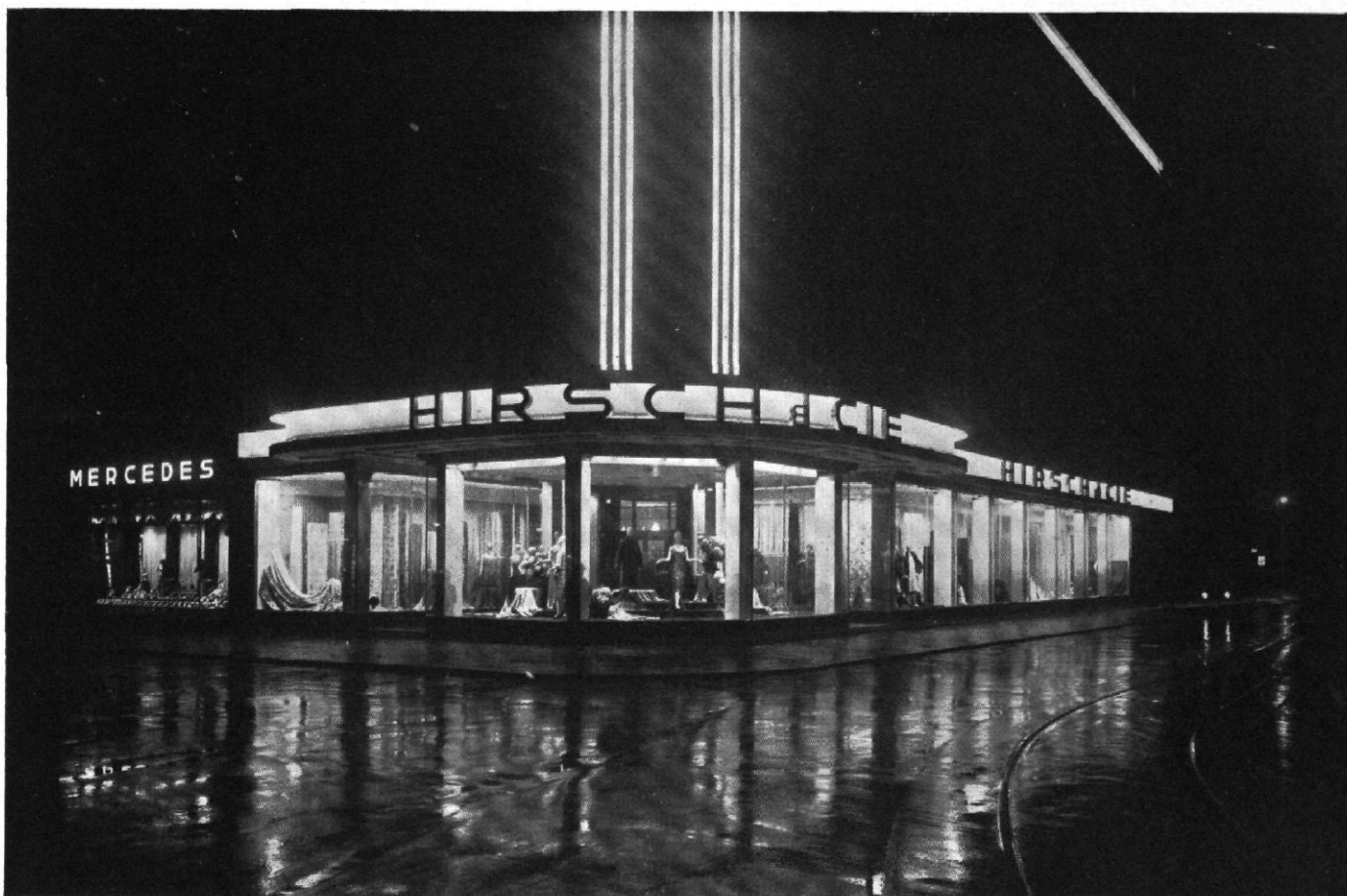
Abb. 12 / Umbau eines Geschäftshauses in Hamburg / Architekten: Schöfß und Opper, Hamburg / Nachtansicht
