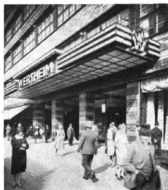
Abb. 4 / Der Wertheim-Bau in Breslau / Architekt: Hermann Dernburg, Berlin
