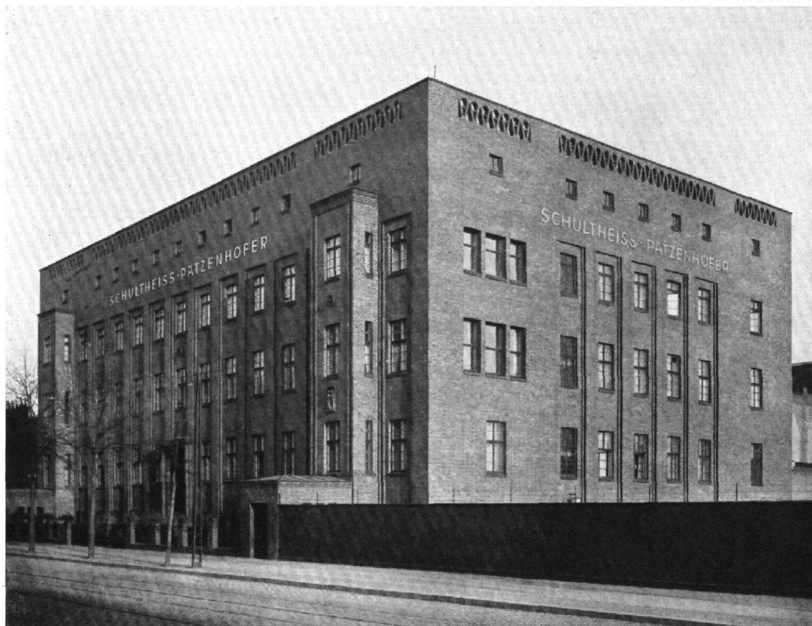
Abb. 12 / Verwaltungsgebäude der Brauerei Schultheiß-Patzenhofer, Berlin / Architekt: Hermann Dernburg, Berlin / Hauptansicht
