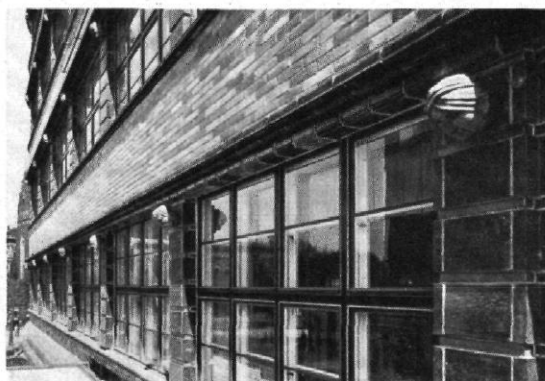
Abb. 6 / Der Wertheim-Bau in Breslau Architekt: Hermann Dernburg, Berlin Einzelheiten der Verkleidung in lichtglasierter Keramik mit vergoldeten Köpfen an den
