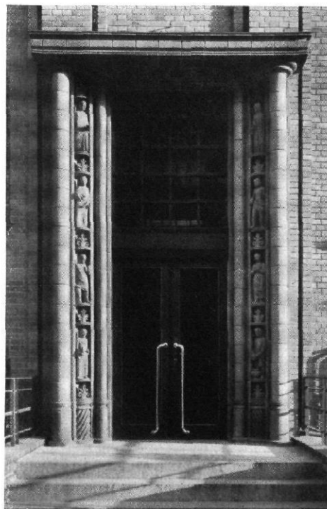
Abb. 12 / Verwaltungsgebäude der Brauerei Schultheiß-Patzenhofer, Berlin / Architekt: Hermann Dernburg, Berlin / Portal. Die Figuren sind Arbeiten des Bildhauers Hans Klakow, Berlin
