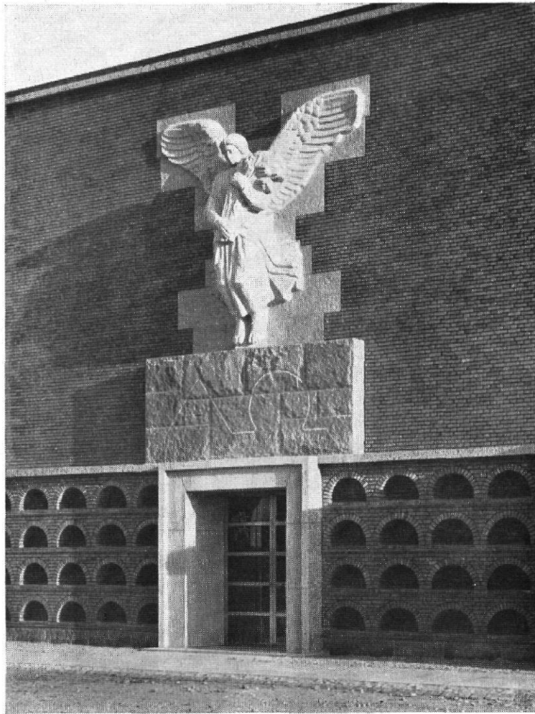
Abb. 9 / Krematorium in Frederiksberg, Dänemark Architekten: Edvard Thomsen und Frits Schlegel, Kopenhagen Eingang zur Kapelle
