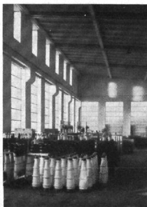
Abb. 9 | Fabrikbauten in Großauheim | Architekt: Karl Wilhelm Ochs, Frankfurt a. M. / Innenansicht der Speditionshalle — Die großen Fenster haben feste Scheiben; die Scheiben über der Kranbahn dienen der Lüftung
