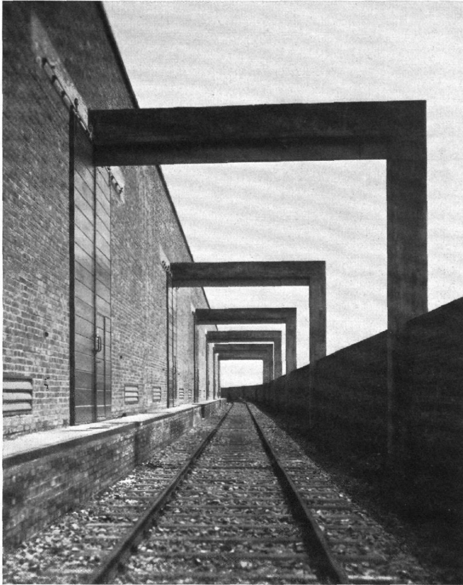
Abb. 1 / Fabrikbauten der Firma Brown, Boveri & Co. in Großauheim / Zufahrtsgleis mit Betonträgern für die Laufkatze / Architekt: Karl Wilhelm Ochs, Frankfurt a. M.
