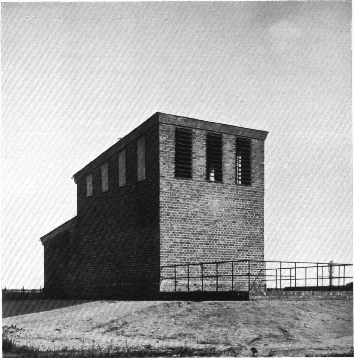
Abb. 10 / Fabrikbauten in Grofsaubeim / Architekt: Karl Wilhelm Ochs, Frankfurt a. M. Acetylenentwicklungs-Anlage
