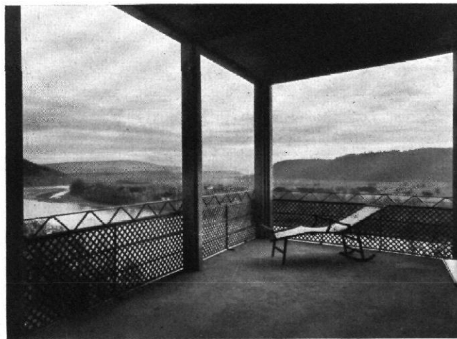
Abb. 9 / Erweiterungsbau des Krankenhauses in Waldshut / Architekt: Gisbert
