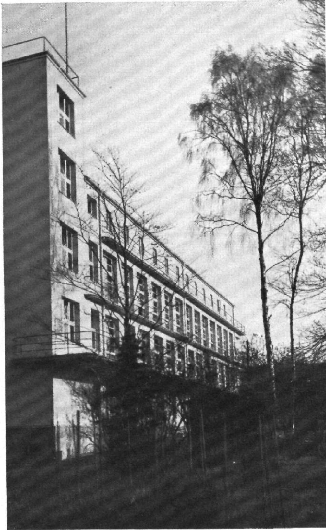
Abb. 9 / Krankenhaus in Freiberg i. Sa. / Architekt: Georg Salzmann, Freiberg Die medizinische Abteilung
