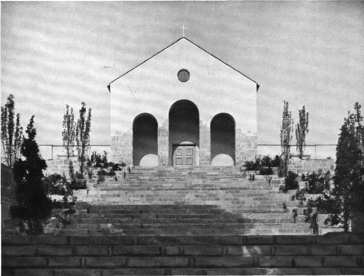
Abb. 1 / Friedhofskapelle in Netzschkau im Vogtlande / Architekt: Alfred Roth, Berlin / Ausgang zur Kapelle
