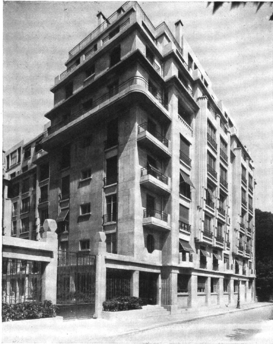
Abb. 2 / Mietshausgruppe in Paris / Architekten: Bassompierre, de Rutté und Sirvin, Paris Teilansicht der Fassade Rue de Versailles
