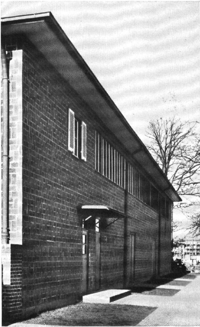
Abb. 13 / Turnhalle in Siemensstadt / Straßenfront / Anschluß an Abb. 9
