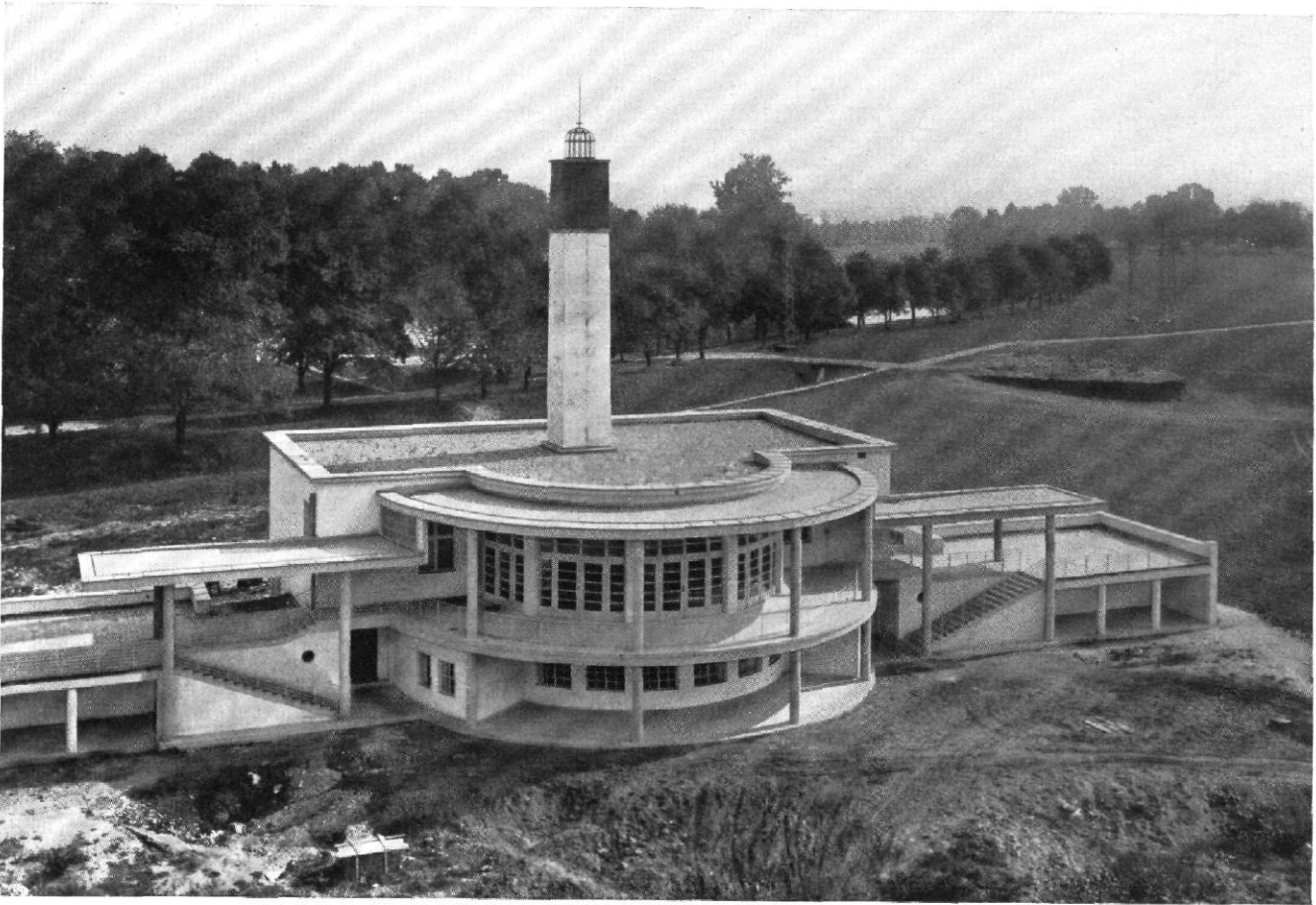
Abb. 5 / Schulblock in Königgrätz / Architekt: Josef Gočár, Prag / Der Kindergarten Im Untergeschoß liegt die zentrale Heizanlage, deren Schornstein das zierliche Gebäude beherrscht. Rechts wird sich später der westliche Teil der Schulanlage anschließen.
