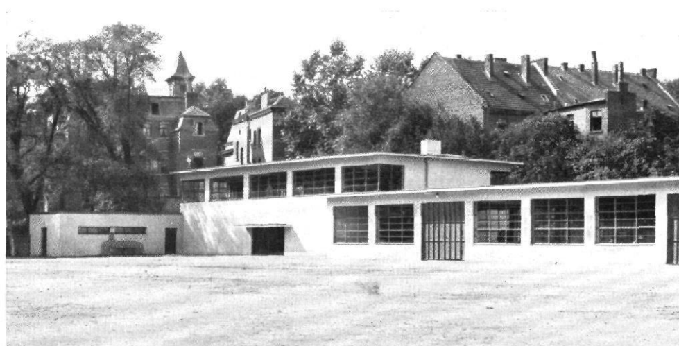
Abb. 4 / Turnhalle und Werkstättengebäude der Kölner Berufsschule in der Ulrichgasse / Architekt: Paul Pott, Köln / Ansicht vom Hofe. Links das Abortgebäude, rechts die Werkstätten.
