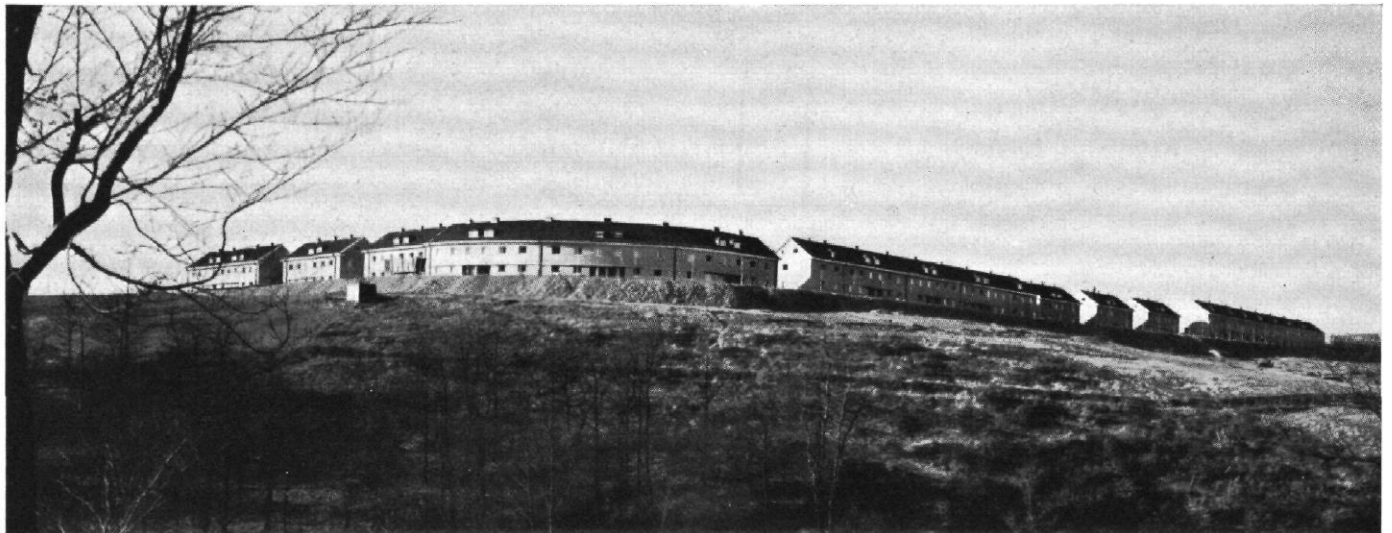
Abb. 2 / Siedlung „Neuenhof“ in Remscheid / Architekt: Ludwig Lemmer, Remscheid / Fernsicht von Südosten
