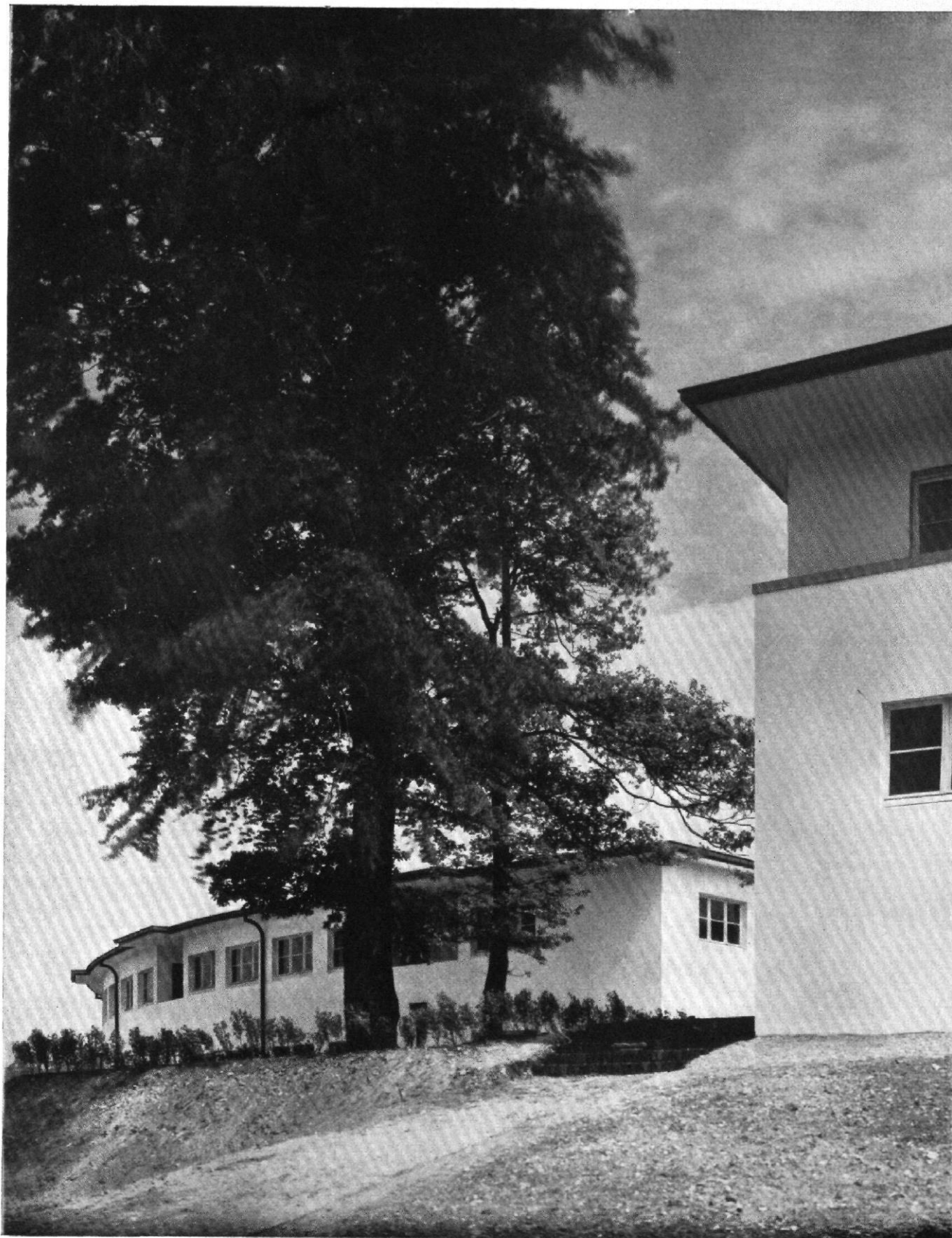
Abb. 12 / Kleinstwohnungen in Remscheid / Architekt: Ludwig Lemmer, Remscheid Blick auf Block B
