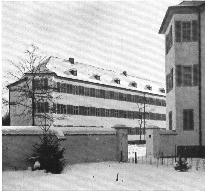
Abb. 1 / Siedlung Siemensstadt / Architekt: Hans Hertlein, Berlin / Blick in die Rieppelstraße von Norden
