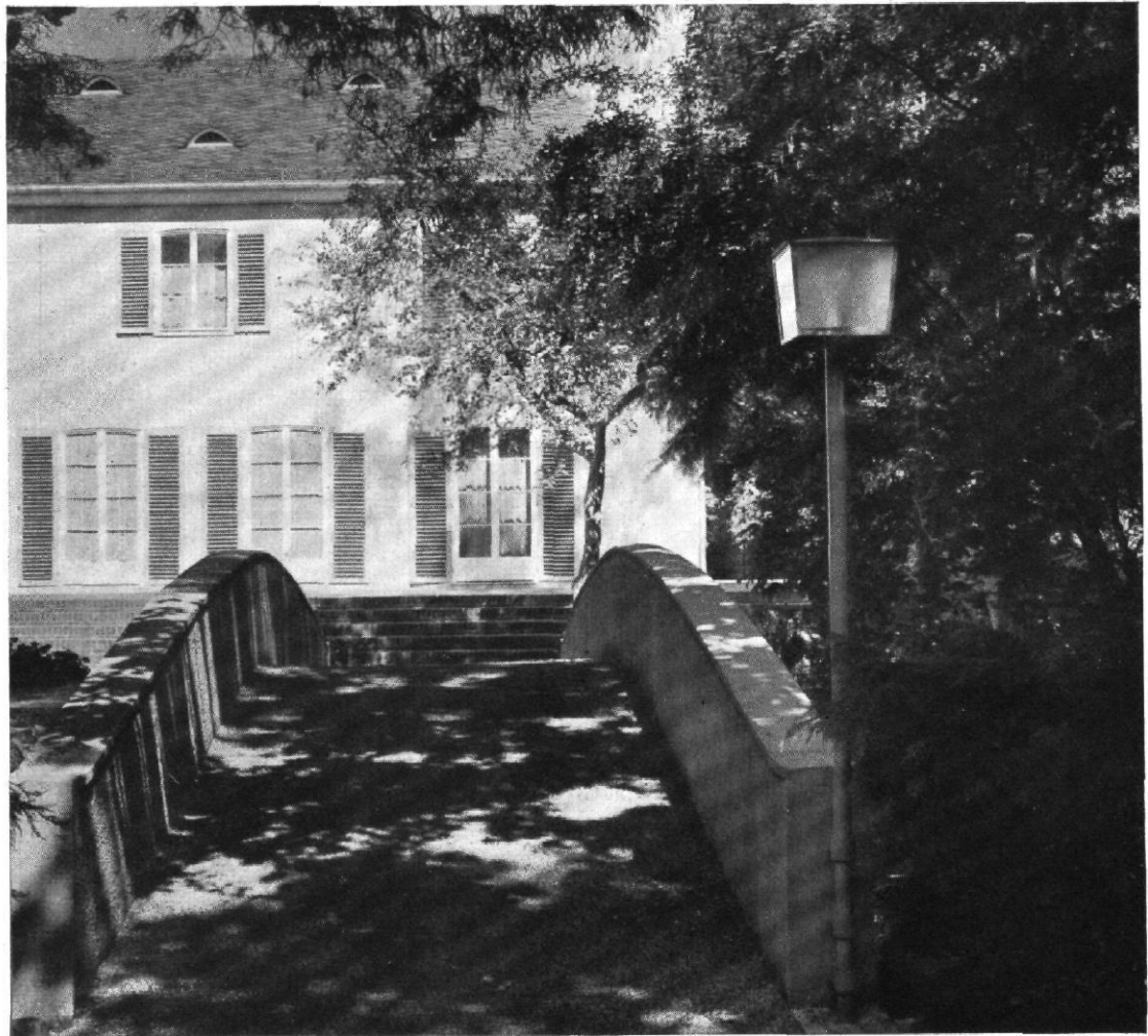
Abb. 3 / Wohnhaus in Hanau / Architekt: Karl Wilhelm Ochs, Frankfurt a. M. / Brücke über den Stadtbach
