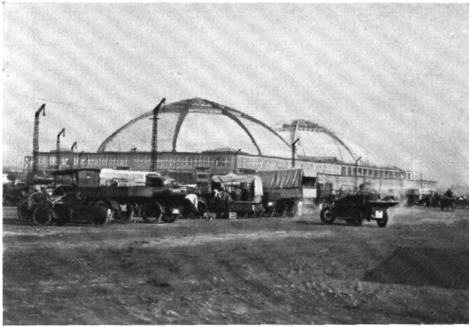
Abb. 13 / Die Leipziger Großmarkthalle / Architekt: Hubert Ritter, Leipzig Ansicht von Südosten
