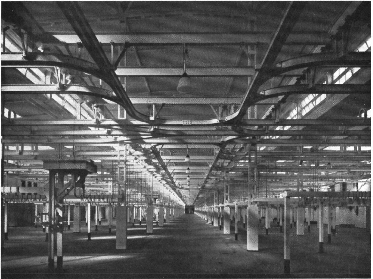
Abb. 7 / Der Seegrenzschlachthof in Hamburg / Architekt: Hermann Distel, Hamburg Kühl- und Fleischabschiebehalle
