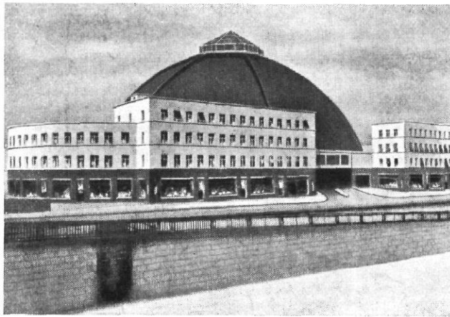
Abb. 10 / Die Großmarkthalle in Basel (im Bau)
