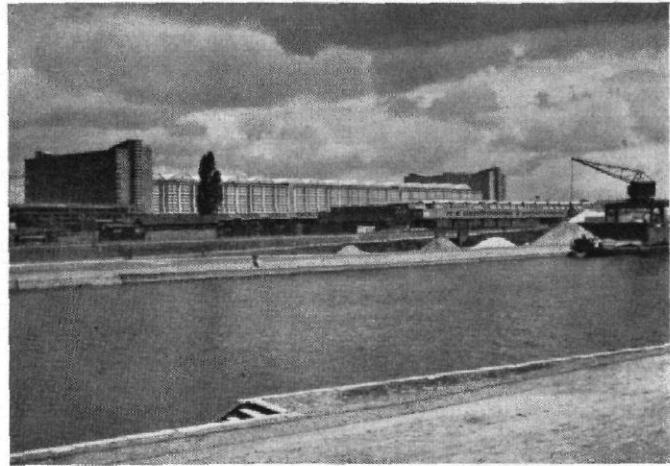
Abb. 14 / Die Großmarkthalle in Frankfurt a. M. Architekt: Martin Elsässer, Frankfurt / Ansicht vom Sachsenhäuser Ufer
