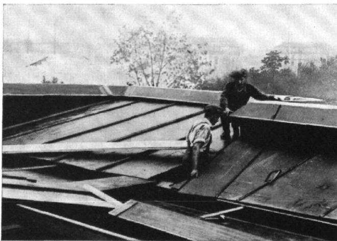
Abb. 4 bis 8 / Französischer Stahlplattenbau. Ein fertiges Haus, daneben Querschnitt durch ein Haus im halben Maßstab. Rechts das Haus im Bau
