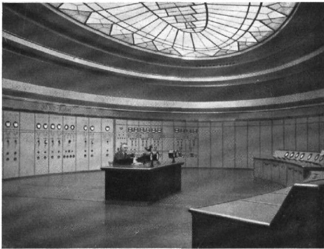
Abb. 10 / Schaltwerk Halensee / Schaltwarte
