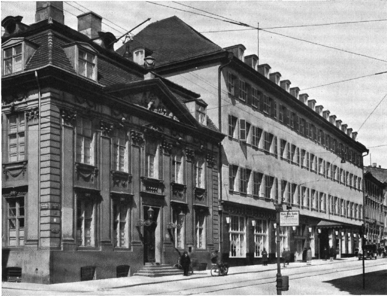
Abb. 1 / Der „Preußenhof“ in Stettin / Architekt: Josef Tiedemann, Berlin / Ansicht von der Straße
