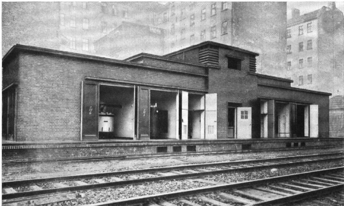
Abb. 26 und 27 (Mitte) / Der „Regelentwurf“ für Kleingleichrichterwerke / Grundriß und Schnitt 1:500 Abb. 28 (Unten) / Ein „Gebäude“ nach dem Regelentwurf in geöffnetem Zustande / Architekt: Richard Brademann
