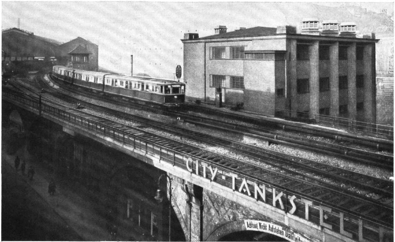
Abb. 47 / Gleichrichterwerk Friedrichstraße / Architekt: Richard Brademann, Berlin / Ansicht von der Stadtbahn und Front an der Prinz-Louis-Ferdinand-Straße. Vgl. auch Seite 520
