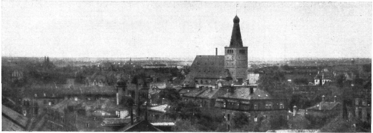
Abb. 11 und 12 / Friedenskirche St. Johannis, Nürnberg / Architekt: German Bestelmeyer / Die Kirche im Stadtbild und Schnitt 1:600
