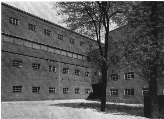
Abb. 21 / Schaltwerk Markgrafendamm Architekt: Richard Brademann, Berlin / Hochspannungsbaus
