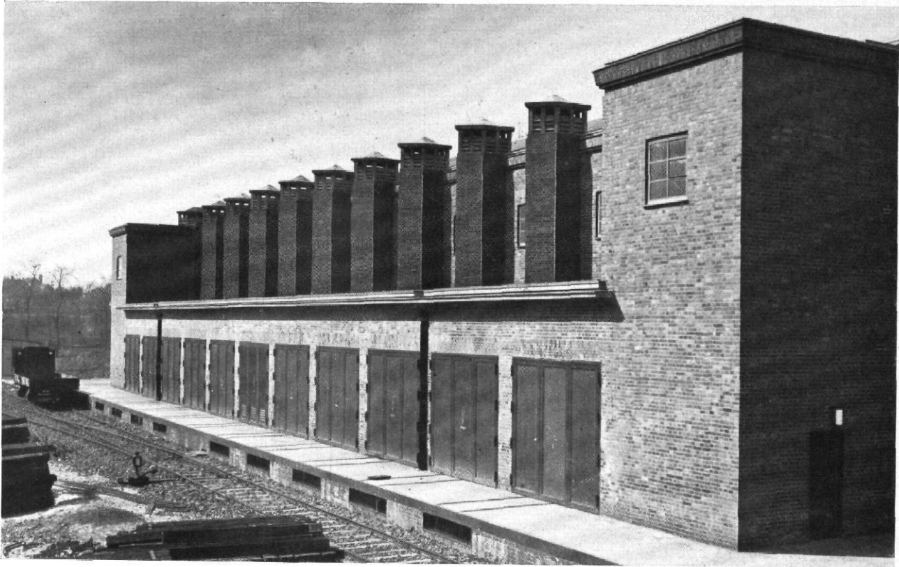
Abb. 6 / Schaltwerk Halensee / Architekt: Richard Brademann, Eerlin / Gleichrichterhaus
