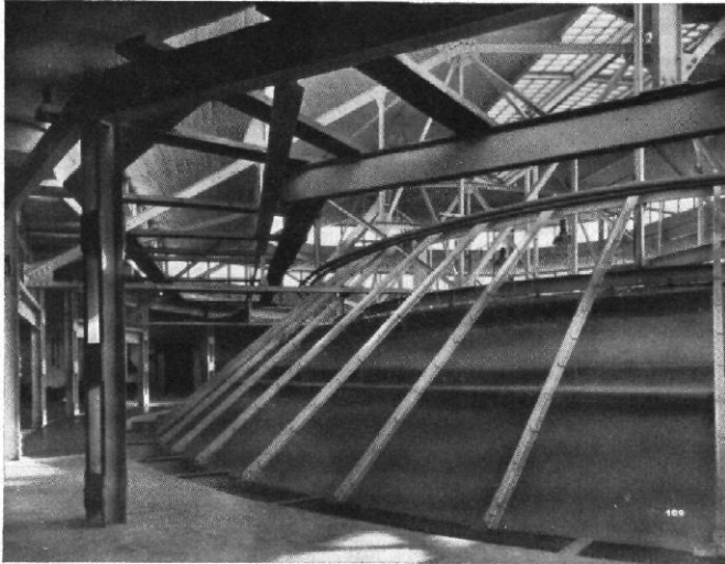
Abb. 8 / Schaltwerk Halensee / Dach über der Schaltwarte
