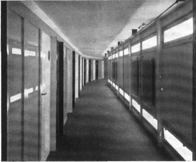
Abb. 66 / Breslau / Ausstellung / Ledigenheim / Architekt: Hans Scharoun / Blick in den Flur eines Wohnzweiges / Daß die Heizkörper mitten auf der Wand statt am Fußboden und die Fenster unmittelbar am Fußboden angeordnet sind, wird nicht wesentlich zur Erwärmung dieses Raumes beitragen. Der Architekt hat anscheinend noch allzusehr unter dem Eindruck der großen Leistung der „Bremen“ gestanden, als daß er sich von schiffsbau-technischen Motiven hätte freimachen können.
