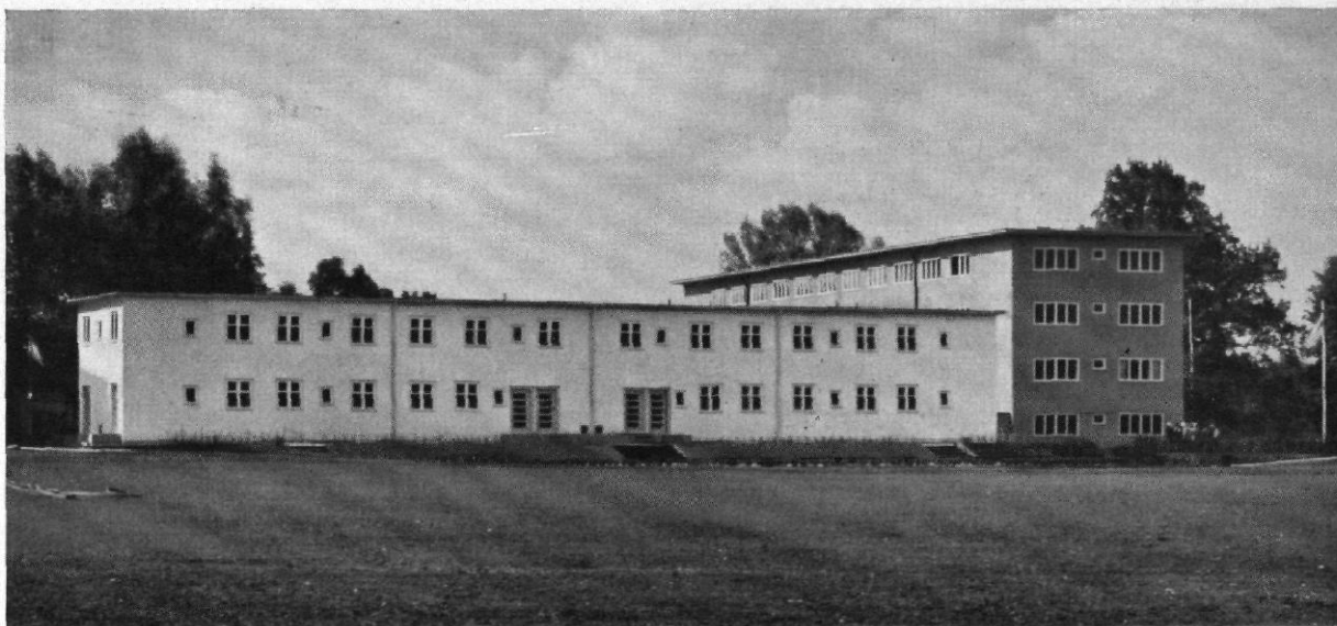
Abb. 17 / Breslau / Ausstellung / Wohnhausblock / Architekt: Gustav Wolf
