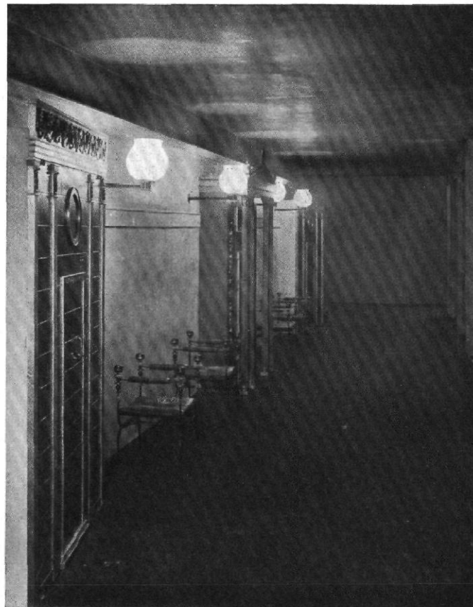
Abb. 19 / Stockholm, Skandiatheater / Architekt: E. G. Asplund / Wandelgang
