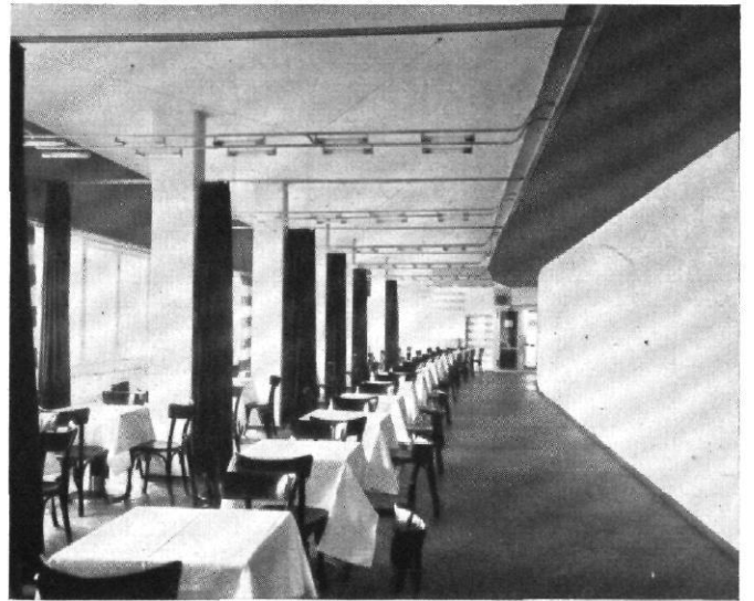
Abb. 67 / Breslau / Ausstellung / Ledigenheim / Architekt: Hans Scharoun / Blick in den Speiseraum / Das Hineinziehen der tragenden Pfeiler in den Raum, das eine durchlaufende Fensterreihe in der Außenwand gestattet, behindert die Sicht in den Garten. Das kullissenartige Hintereinanderreiben dieser Pfeiler übt auf den Besucher eine beengende und unbeagliche Wirkung aus, die wohl gerade durch die Anordnung der riesigen Fensterflächen vermieden werden sollte.
