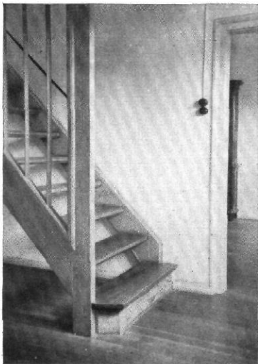
Abb. 26 | Haustyp W | Treppe vom Obergeschoß zum Dachgeschoß | Hierzu Abb. 30 Architekt: Paul Schmittbenner, Stuttgart
