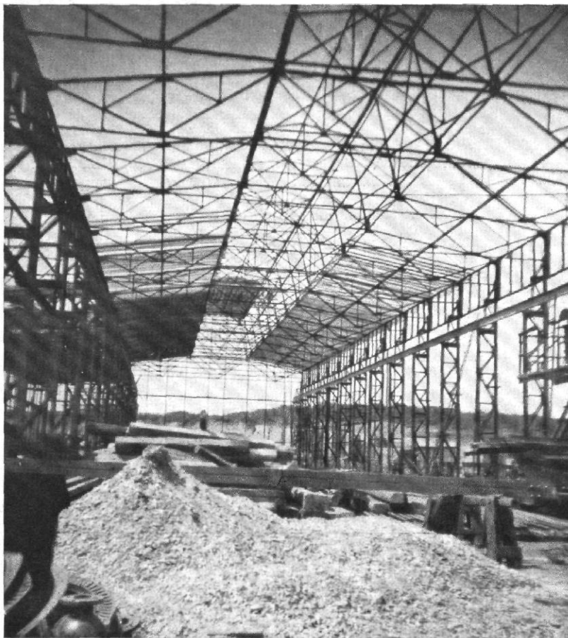
Abb. 55 | Großfabrikhalle der Firma Werner & Pfleiderer, Feuerbach, Stuttgart | Das Eisengerüst in der Montage | Ausführung der Eisenkonstruktion Maschinenfabrik Eßlingen Architekt: Paul Schmittbenner, Stuttgart
