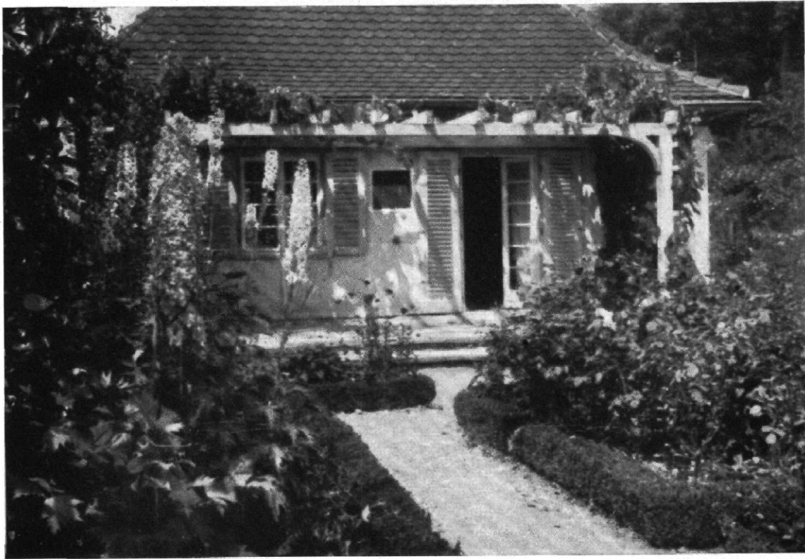
Abb. 6 | Haus René Schickele, Badenweiler | Blick auf die Weinlaube von der Südostseite | Architekt: Paul Schmitthenner, Stuttgart
