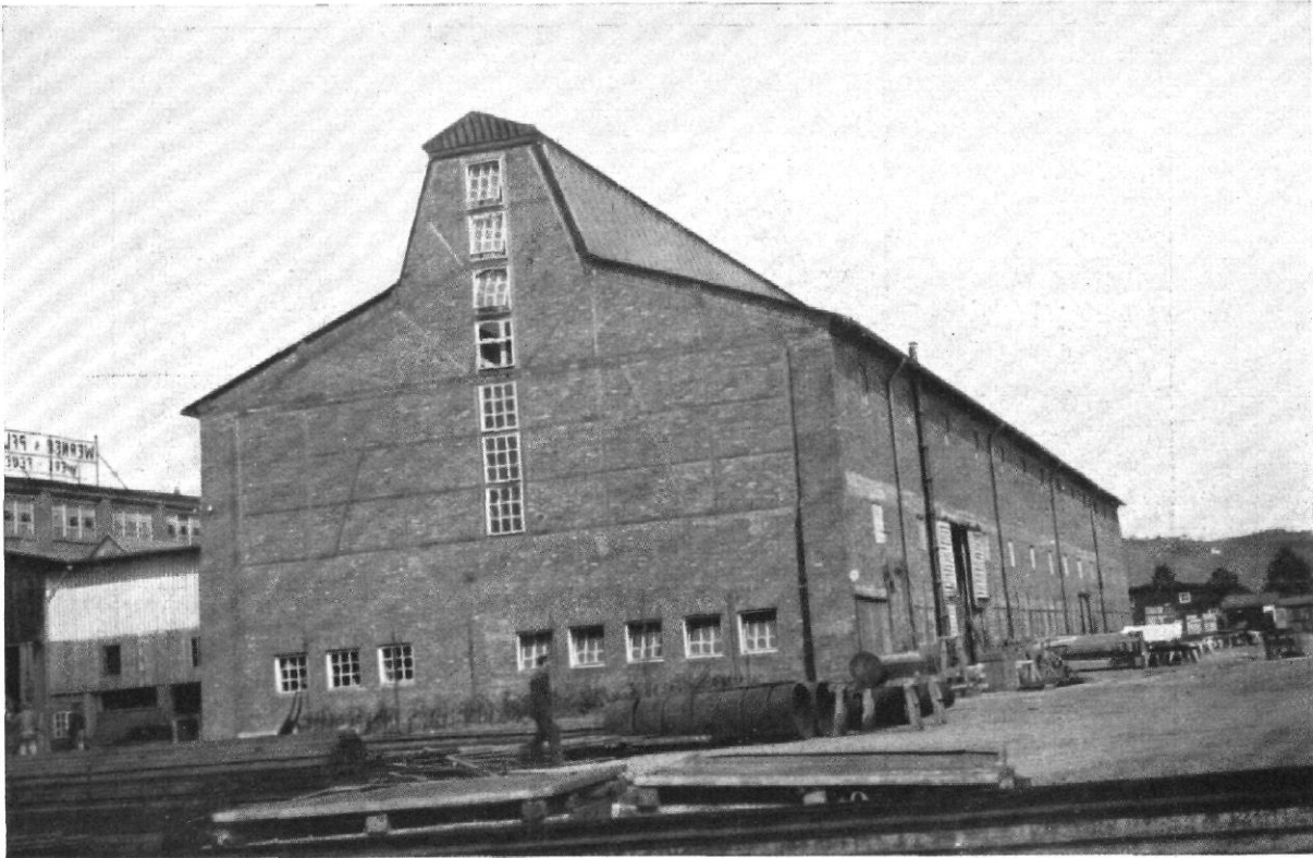
Abb. 56 | Großfabrikhalle Werner & Pfeiderer, Feuerbach, Stuttgart | Erbaut 1922 | Ausführung: Karl Kübler, Stuttgart | Architekt: Schmitthemer
