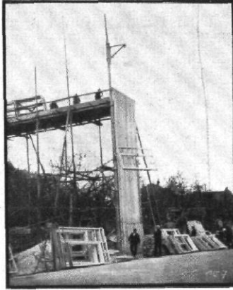
Abb. 36 | Zu dem Haus am Hang führt über die Bäume hinweg eine Brücke auf Höhe des massiven Erdgeschoß-Fußbodens. Die fertigen Rahmen mit gestrichenen Fenstern und Türen werden mit dem Motor der Beton-Mischmaschine aufgezogen.
