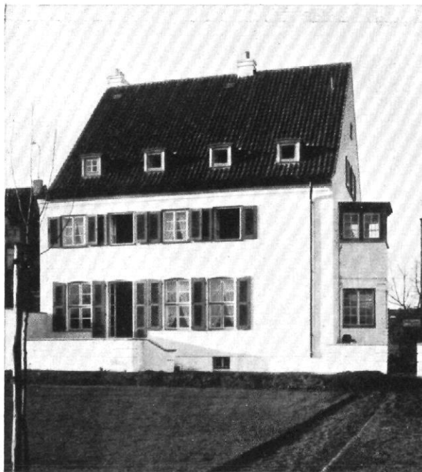
Abb. 71 | Haus eines Arztes in Hannover Architekt: Baurat W. Tiedje, Köln
