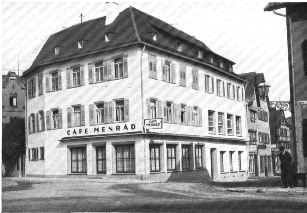
Abb. 83 | Haus in Gmünd nach dem Umbau Architekt: Reg.-Baumeister A. Schuhmacher, Stuttgart
