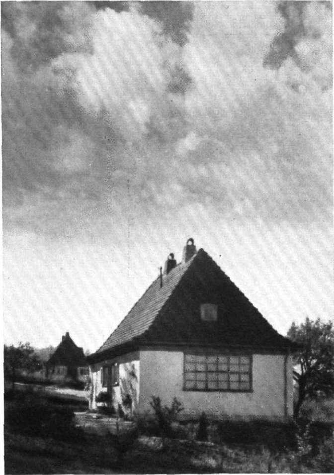
Abb. 11 | Haus des Malers B. in Badenweiler von Westen | Im Hintergrund Haus Annette Kolb | Architekt: Paul Schmitthenner, Stuttgart
