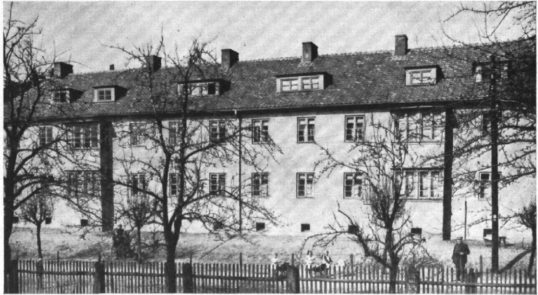
Abb. 11 | Mietshaus in Eisleben
