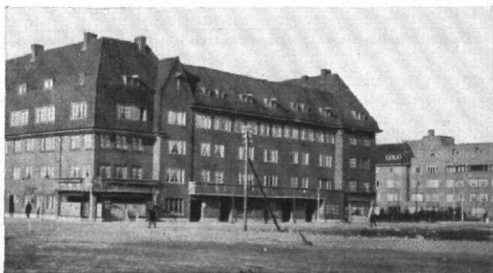
Abb. 26 / Rettungsversuch am flachen Dache durch Aufsetzen eines Steildaches mit flacher Haube
