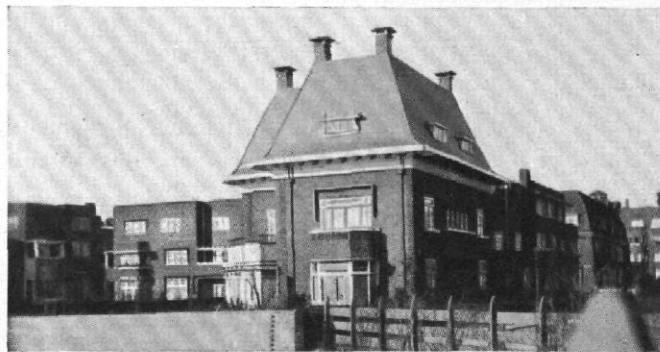
Abb. 26 / Rettungsversuch am flachen Dache durch Aufsetzen eines Steildaches mit flacher Haube
