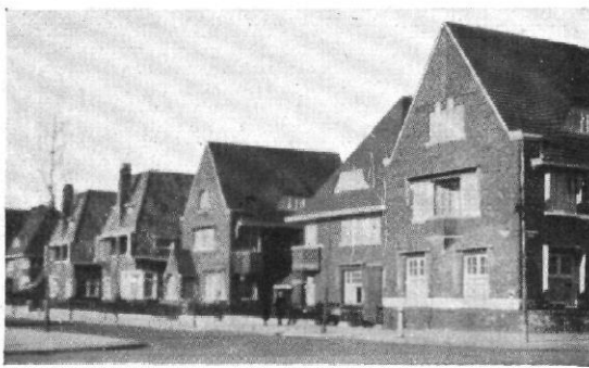
Abb. 22 / Im Vordergrund vernünftige, im Hintergrund fürliche (halb steil, halb flach) Dachformen aus Amsterdam
