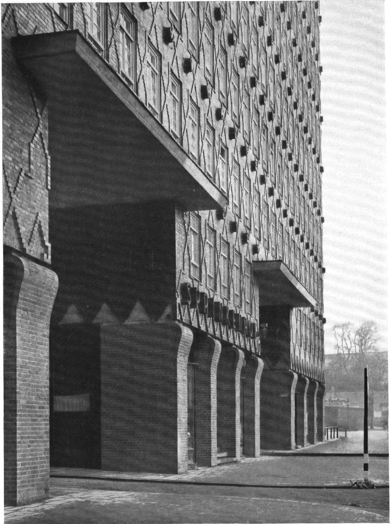
Abb. 2 | Der Sprinkenhof in Hamburg | Architekten: Fritz Höger und Hans und Oskar Gerson, Hamburg Die Durchfahrten
