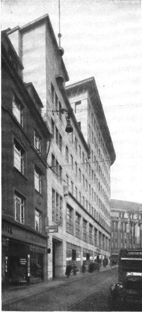
Abb. 10 / Kommunalbank in Bochum / Architekt: Wilhelm Kreis, Dresden / Seitenansicht
