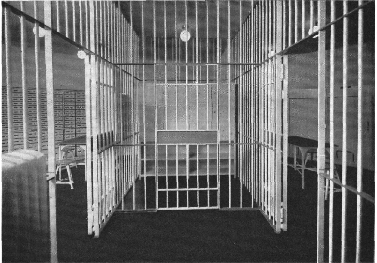
Abb. 18 / Kommunalbank in Bochum / Architekt: Wilhelm Kreis, Dresden / Tresorraum
