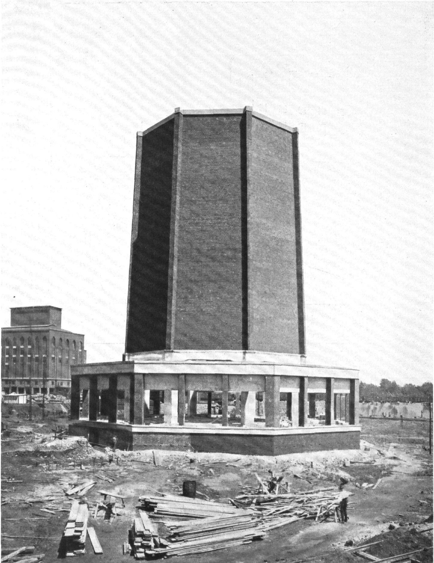
Abb. 11 / Großkokerei Minister Stein in Dortmund-Eving / Architekt: Helmuth von Stegmann, Dortmund / Kaminkühler
