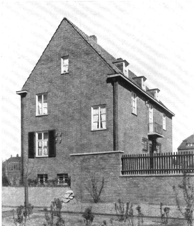
Abb. 9 und 10 / Großkokerei Hansa in Dortmund / Architekt: Helmuth von Stegmann, Dortmund | Beamtenwohnhäuser Diese Häuser wirken auch dadurch angenehm, daß sie trotz ihrer Zugehörigkeit zu einem großen technischen Werke nichts als menschliche Behausungen sein wollen und in keiner Weise den Stolz auf ihre Verwandtschaft durch Übernahme „technischer Formen“ hervorzukehren suchen.
