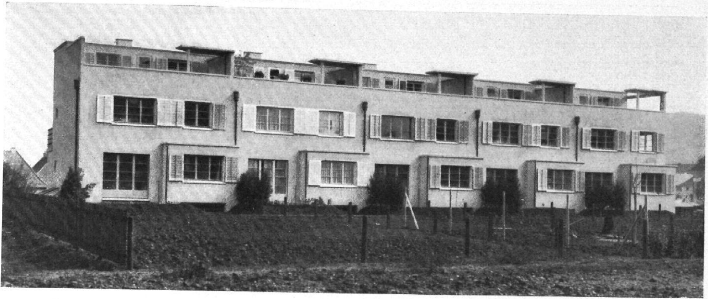
Abb. 9 | Zürich | Bauten der Immobilien-Gesellschaft „Guggach“ | Architekt: Schwegler & Bachmann, Zürich | Gartenseite der Häuser
