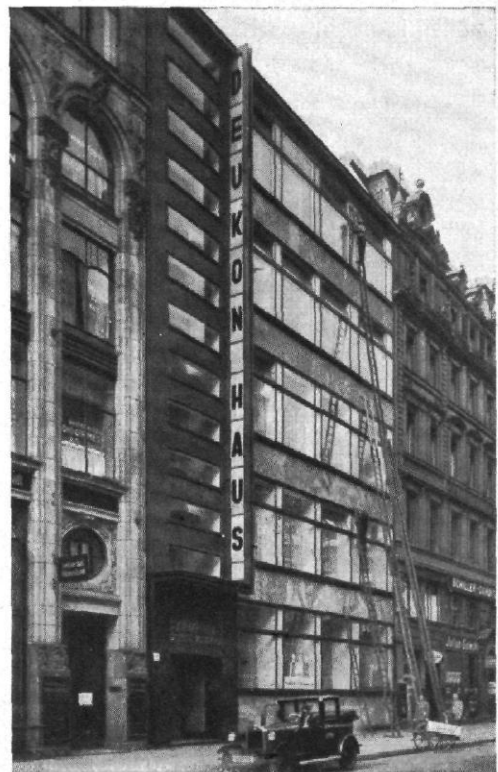
Abb. 6 | Berlin | Deukon-Haus, Markgrafenstraße Architekt: Erich Mendelsohn | Die Fenster werden von der Groß-Berliner Glas- und Messing-Putz-Anstalt „Reform“ Kurniker & Co., Berlin W 8, geputzt
