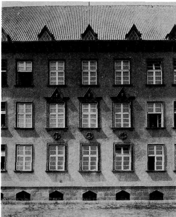
Teil der Fassade
