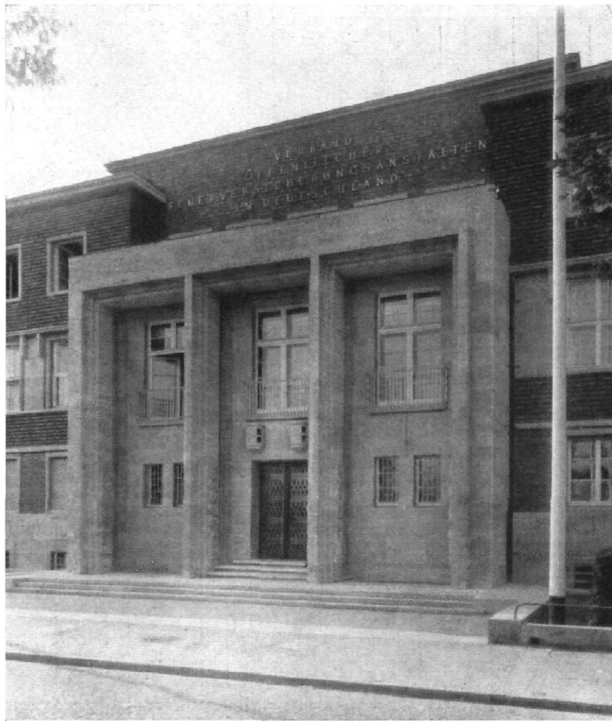
Abb. 1 und 2 Verbandsbaus der Feuer- versicherungs - Anstalten in Deutschland in Berlin-Dahlem
