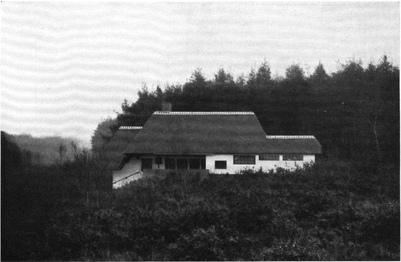
Abb. 4 / Sommerhaus in Wolfbezen / Erbaut 1926 — 27 / Architekt: Maurits Plate, Haarlem Vgl. Abb. 5
