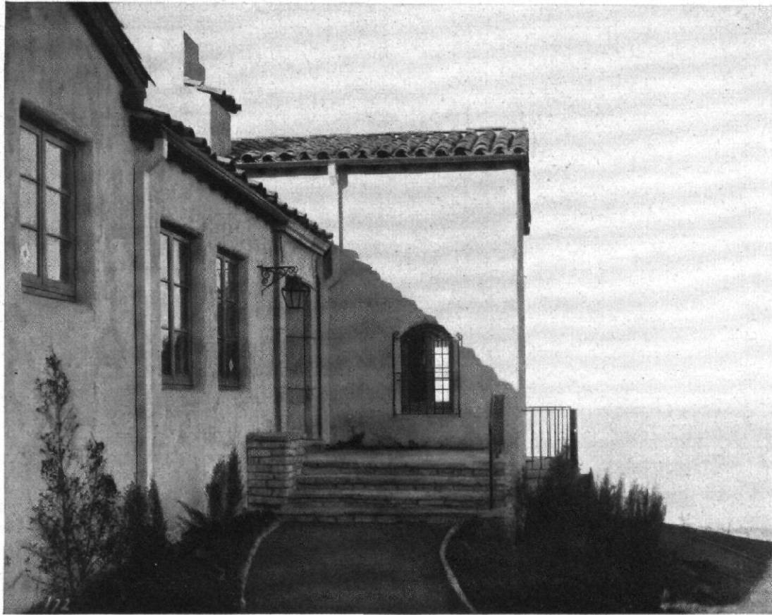
Abb. 4 / Wohnhaus A. E. Cameron in Palos Verdes, Kalifornien / Teilansicht / Architekt: Kirtland Cutter Vgl. Abb. 1 bis 7, 13, 18 und 28
