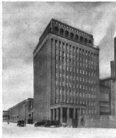
Abb. 3 / Elektrizitätswerk Klingenberg Architekten: Klingenberg und Issel
