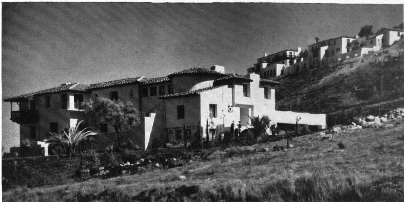
Abb. 14 2 / Wohnhaus E. W. Gard in Palos Verdes, Kalifornien / Architekt: Kirtland Cutter Vgl. Abb. 27
