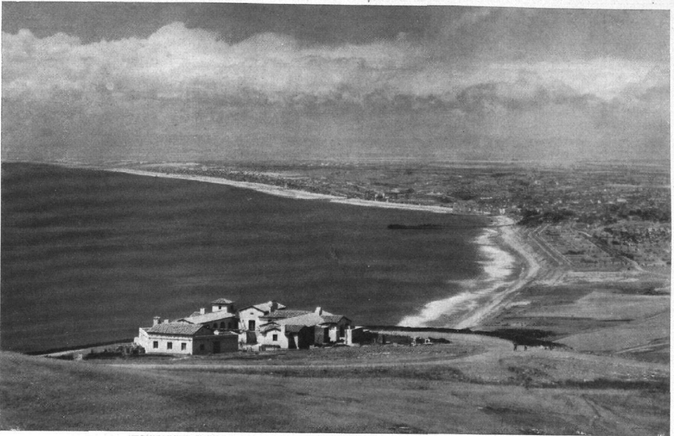
Abb. 2 / Wohnhaus A. E. Cameron (im Vordergrund) in Palos Verdes, Kalifornien / Architekt: Kirtland Cutter Vgl. Abb. 1 bis 7, 13, 18 und 28
