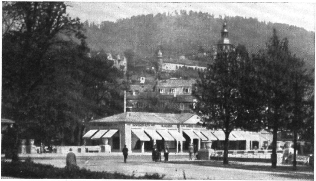
Oben: Nach Umbau Mitte: Vor Umbau Unten: Teilansicht nach Umbau
