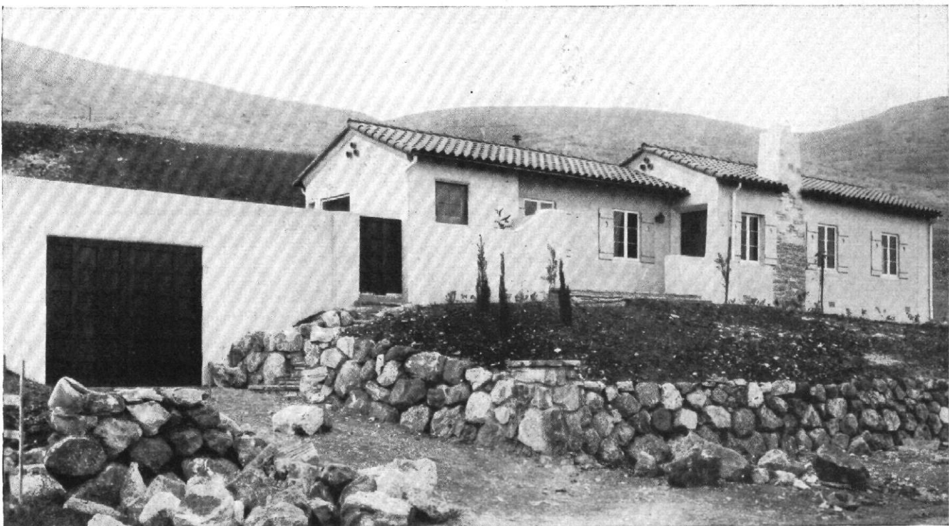
Abb. 20 / Wohnhaus P. J. Kerr in Palos Verdes, Kalifornien / Architekt: Clarence E. Howard
