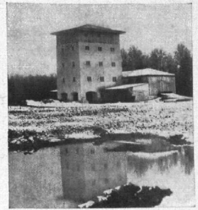
Abb. 13 / Sägewerk in Roskinskow Architekt: Pietrusky
