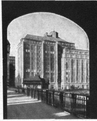
Abb. 12 / Ballin-Haus in Hamburg Architekt: Gerson
