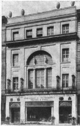
Abb. 20 / Kunstgewerbebaus Berlin / Architekt: Dernburg
