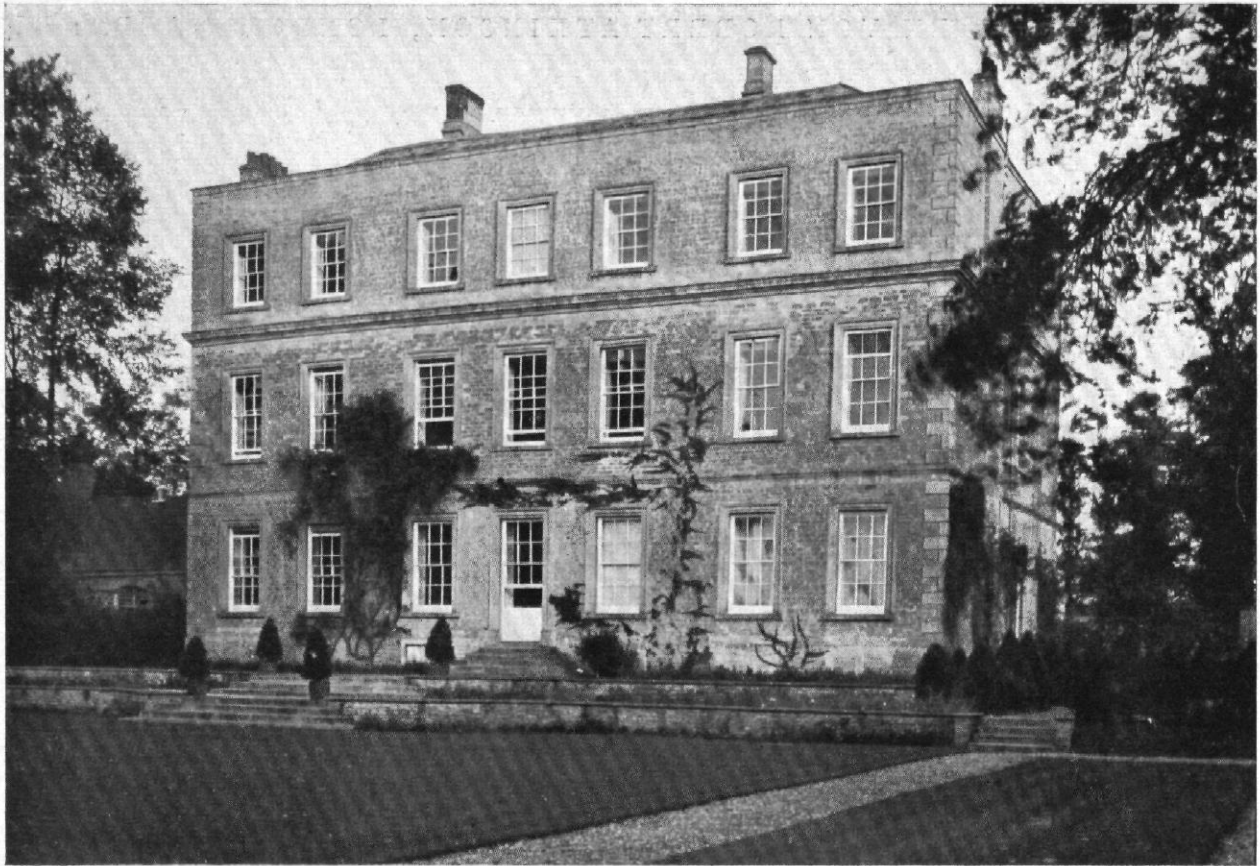
Abb. 4 / Newington House in Oxford / Gartenansicht / Instandsetzung durch: Robert Atkinson, London
