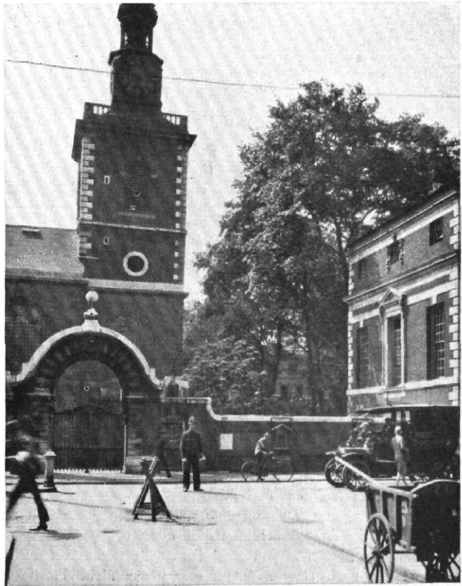
Abb. 40 / Kirche in London von Sir Christopher Wren Rechts: The Midland Bank / Vgl. Abb. 39
