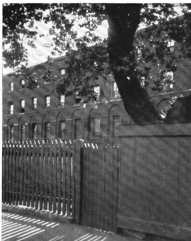
Abb. 36 / Wohnhaus aus der Zeit der George in Kennigton Road, London Architekt unbekannt
