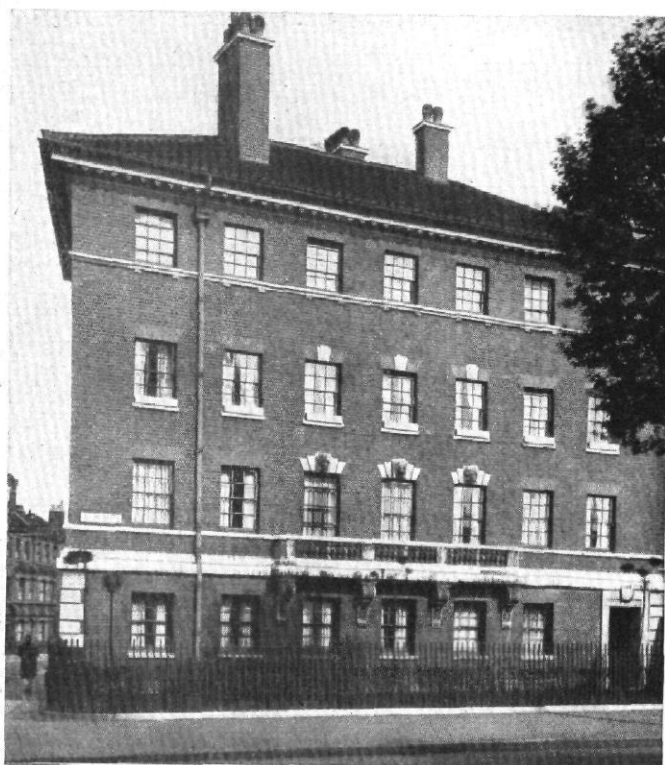
Abb. 33 / Wohnhaus in Kennigton Road, London / Vgl. Abb. 35 Architekten: Adshead und Ramsay, London Das Haus enthält vier Stockwerkswohnungen
