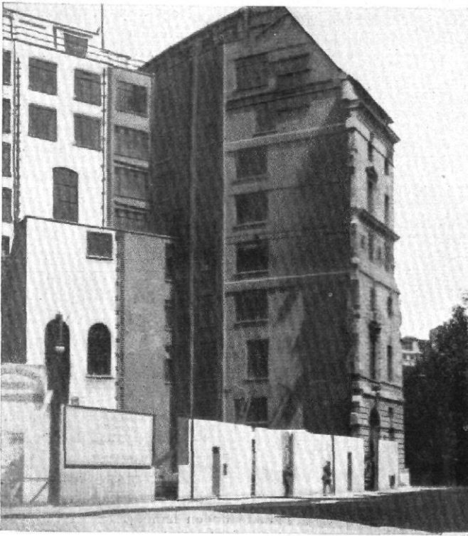
Abb. 37 / Britannic House, Finsbury, Circus, London Architekt: Sir Edwin Lutyens Vgl. Abb. 41 bis 49
