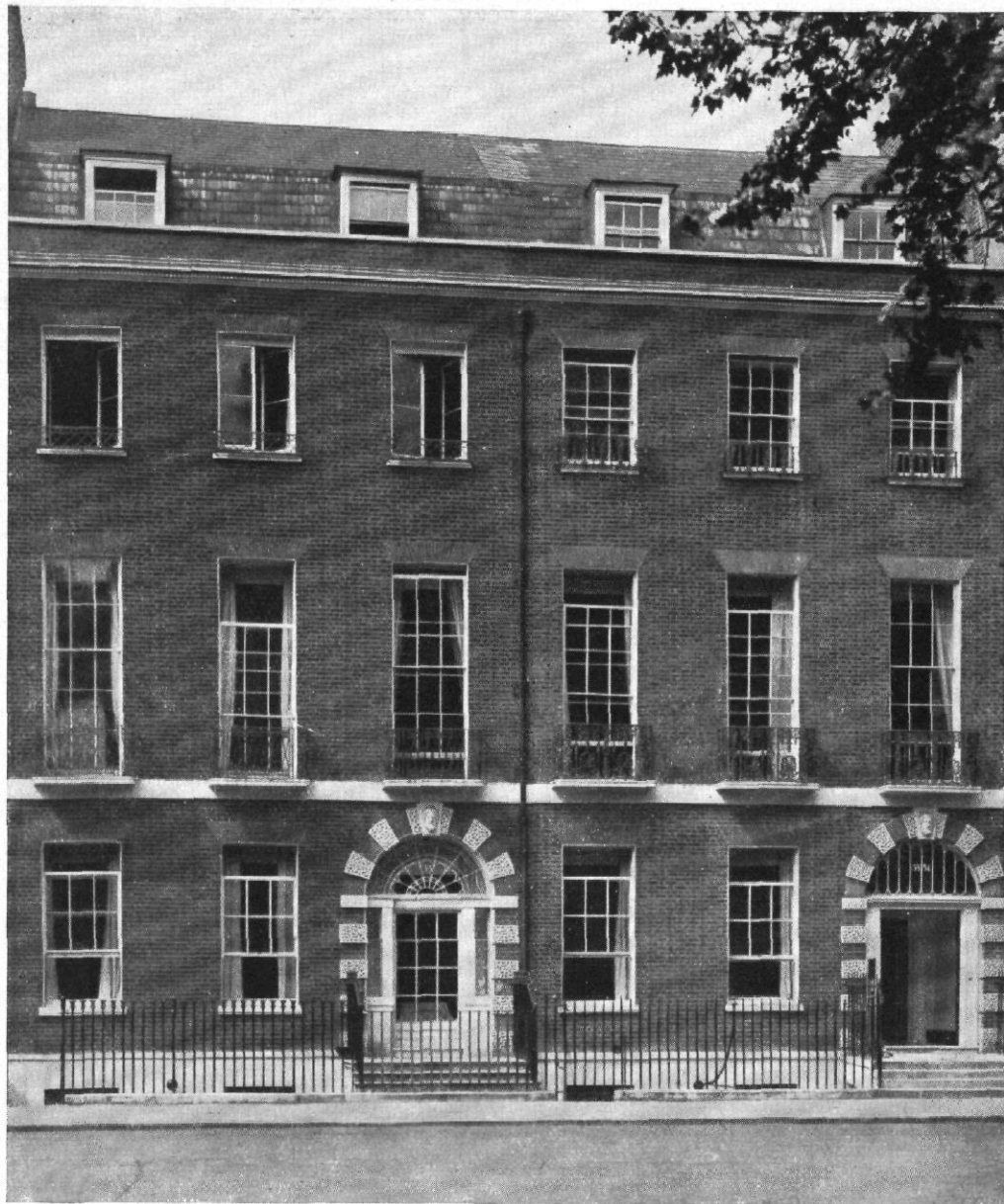
Abb. 93 bis 95 / Gebäude der „Architectural Association“ in London / Oben: Ansicht am Bedford Square nach der Umgestaltung durch Robert Atkinson, London / In einer weiteren Umgestaltung, durch Easton und Robertson, wurde dem Klub ein drittes, gleichartiges Haus (links) binzugefügt. Vgl. die Grundrisse unten. Näheres über die Architectural Association vgl. S. 314 bis 315
