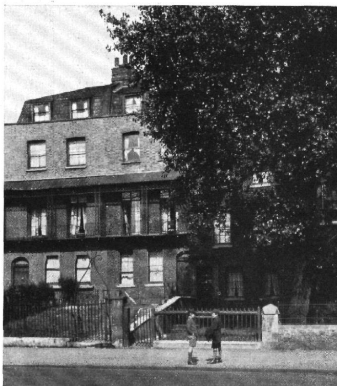
Abb. 34 / Wohnhaus aus der Zeit der George in Kennigton Road, London Architekt unbekannt
