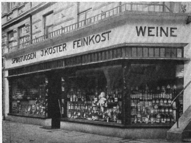
Abb. 7 / Laden in der Osterstraße, Hamburg Architekt: Rudolf Klebing, Hamburg
