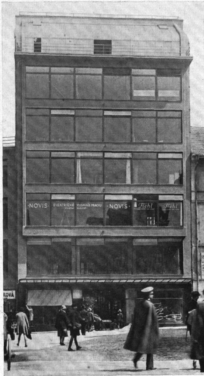
Abb. 1 / Geschäftsbaus Lindt in Prag / Rückansicht Architekt: Kysela, Prag / Vgl. Abb. 3—5
