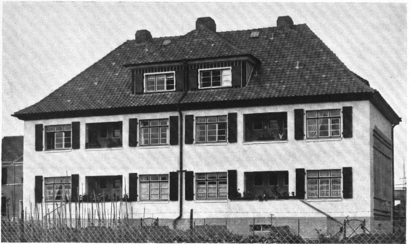
Abb. 1 | Beamten-Wohnhaus in Halberstadt | Gartenansicht Architekt: Paul Schaeffer-Heyrothsberge, Magdeburg
