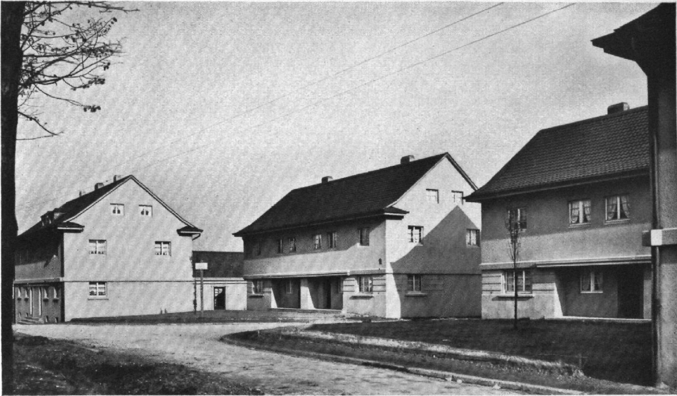
AUS DER SIEDLUNG NEUENHOF BEI REMSCHEID ARCHITEKT: LUDWIG LEMMER, REMSCHEID
