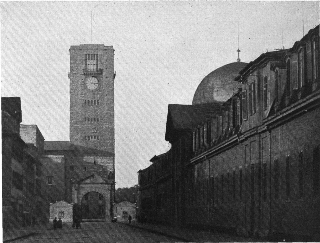
Abb. 13 / Bahnhof Stuttgart / Architekten: Paul Bonatz und F. E. Scholer in Stuttgart
