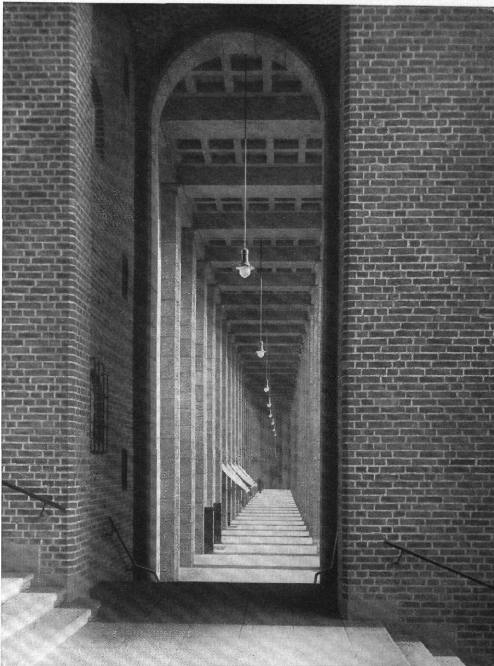
Abb. 15 / Bahnhof Stuttgart / Architekten: Paul Bonatz und F. E. Scholer in Stuttgart Blick von der linken Vorballe in die Pfeilerhalle
