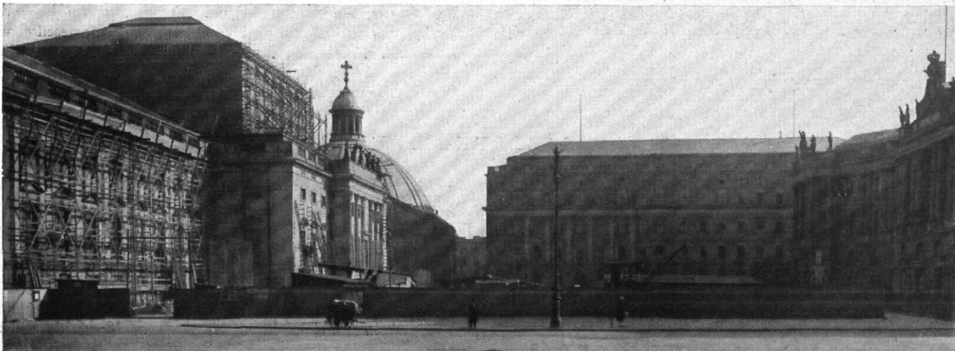
Abb. 4 / Friedrichsforum, aufgenommen März 1928 auf der Platz-Achse (Vom Eingang zum Universitäts-Vorhof aus) Die Hedwigskirche verschwindet bis über die Hälfte ihres Giebelvorbaues hinter den seitlichen Ausblättern der Oper. So wird die Kirche vollends erschlagen und die Platzwirkung vernichtet.
