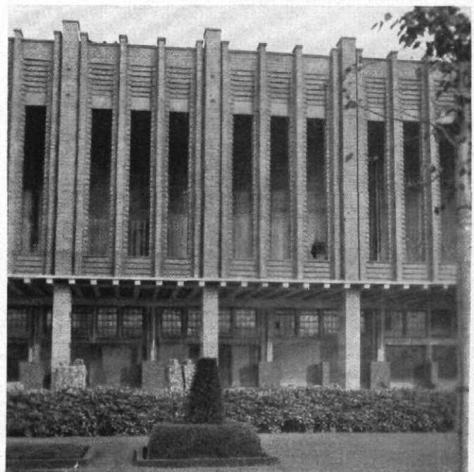
Abb. 6 | Köln. Die neue gotisierende Fassade der Messehallen. Die als Backsteinpfeiler verkleideten Stiele laufen zwischen den dekorativ behandelten Sparren durch.
