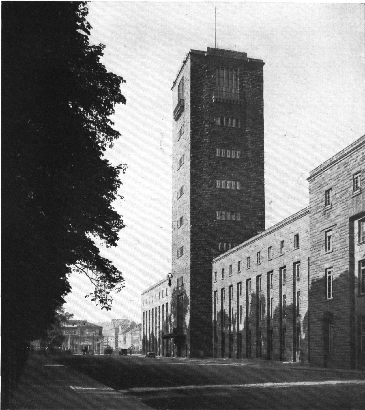
Abb. 1 / Bahnhof Stuttgart / Architekten: Paul Bonatz und F. E. Scholer in Stuttgart Seitenansicht nach der Ludwigsburger Straße
