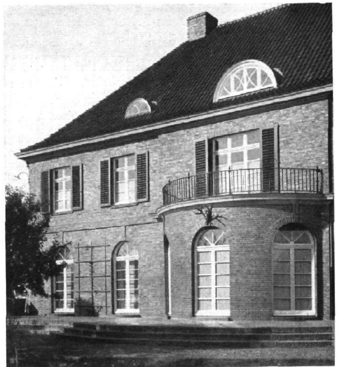
Abb. 6 | Herrenhaus auf Gut Waldhof in Holstein | Teil der Gartenansicht Architekten: Puls u. Richter, Kiel | Vgl. Abb. 1 bis 5 und Text S. 134 bis 135
