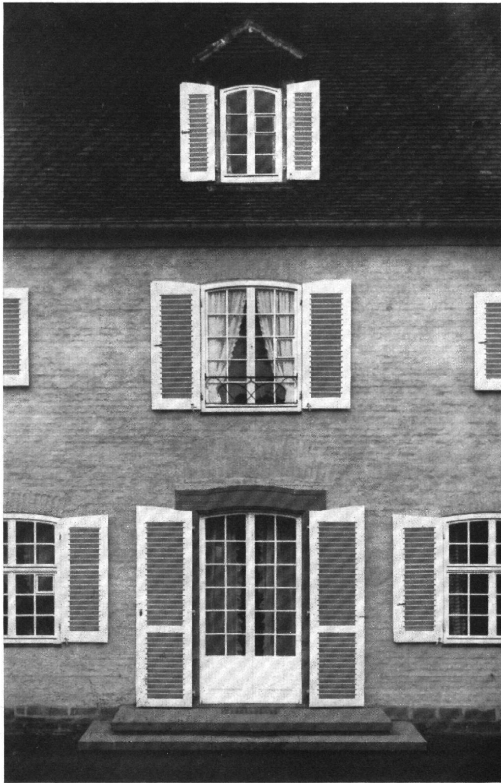
Abb. 8 | Haus W. Roser, Stuttgart | Tür des Gartensaals an der Südseite | Architekt: Paul Schmittbenner Vgl. Abb. 1—7 und 9—16
