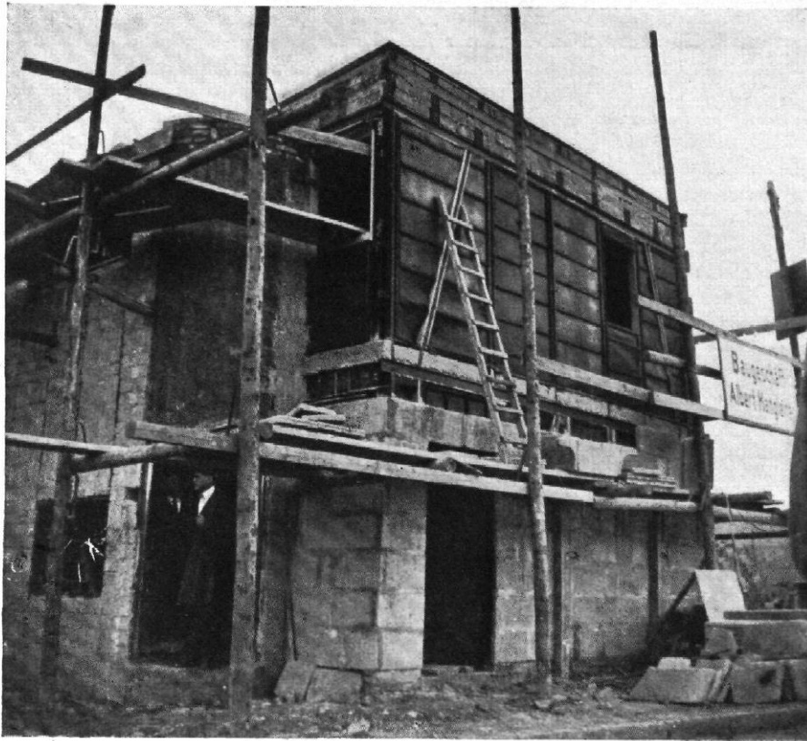
Abb. 1 | Ein Haus der Stuttgarter Werkbundsiedlung im Bau
