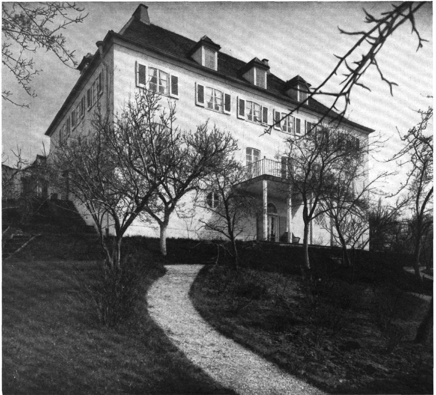
Abb. 18 | Haus Dr. Raßbach, Stuttgart | Architekt: Paul Schmittbenner, Stuttgart | Talseite nach Süden · Backsteinrobbau geschlemmt
