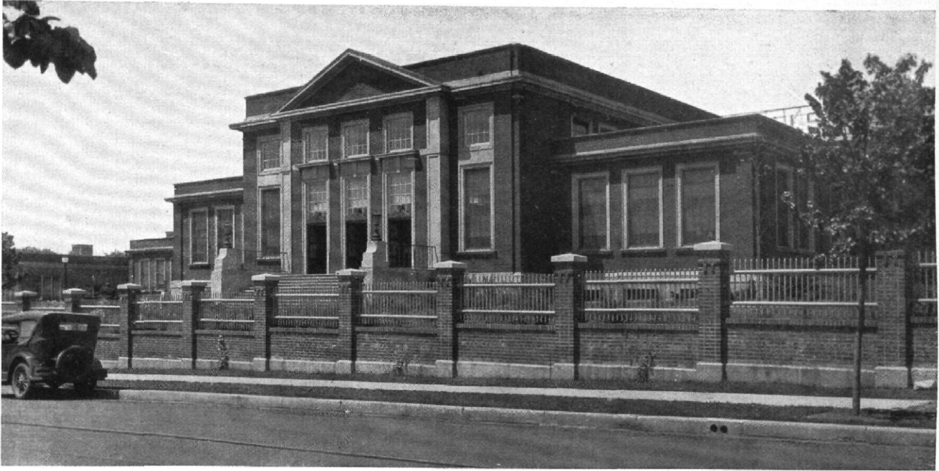
Abb. 5 | Woblfabrtsbauten der „Berkshire Knitting Mills“ in Wyomissing | Südfront der Speisehalle | Vgl. Abb. 6 und 7 Material: tiefrote Ziegelsteine, Schmuckformen ockergelbe, unglasierte Terra Cotta | Architekt: Paul Hessemer, Wyomissing
