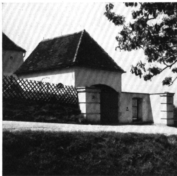
Abb. 3 | Haus W. Roser, Stuttgart, Garage mit Eingang am Feuerbacherweg | Vgl. Abb. 1 und 3-16 Arch.: Paul Schmittbenner, Stuttgart
