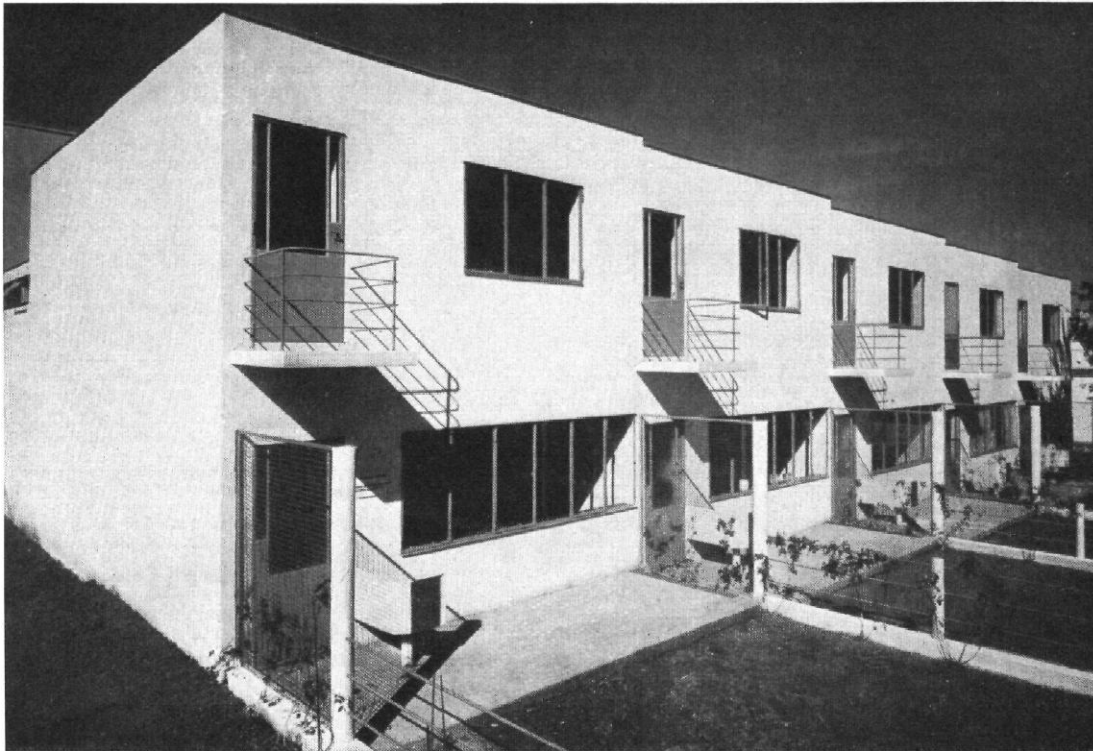
Abb. 9 | Weißenhofsiedlung Stuttgart | Reihenhäuser von Oud | Vgl. Abb. 8 und 10 sowie die Grundrisse in Heft 7 auf Seite 297 Abb. 8 und 10 zeigen die zahlreichen Außenwände, die die Ausführung verteuern dürften vgl. Text Seite 394/95
