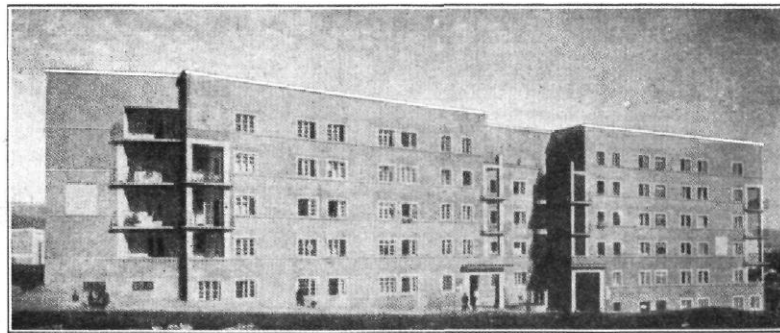
Abb. 138 WOHNHAUS DER GEMEINDE WIEN XVII 1924, SÜDSEITE
