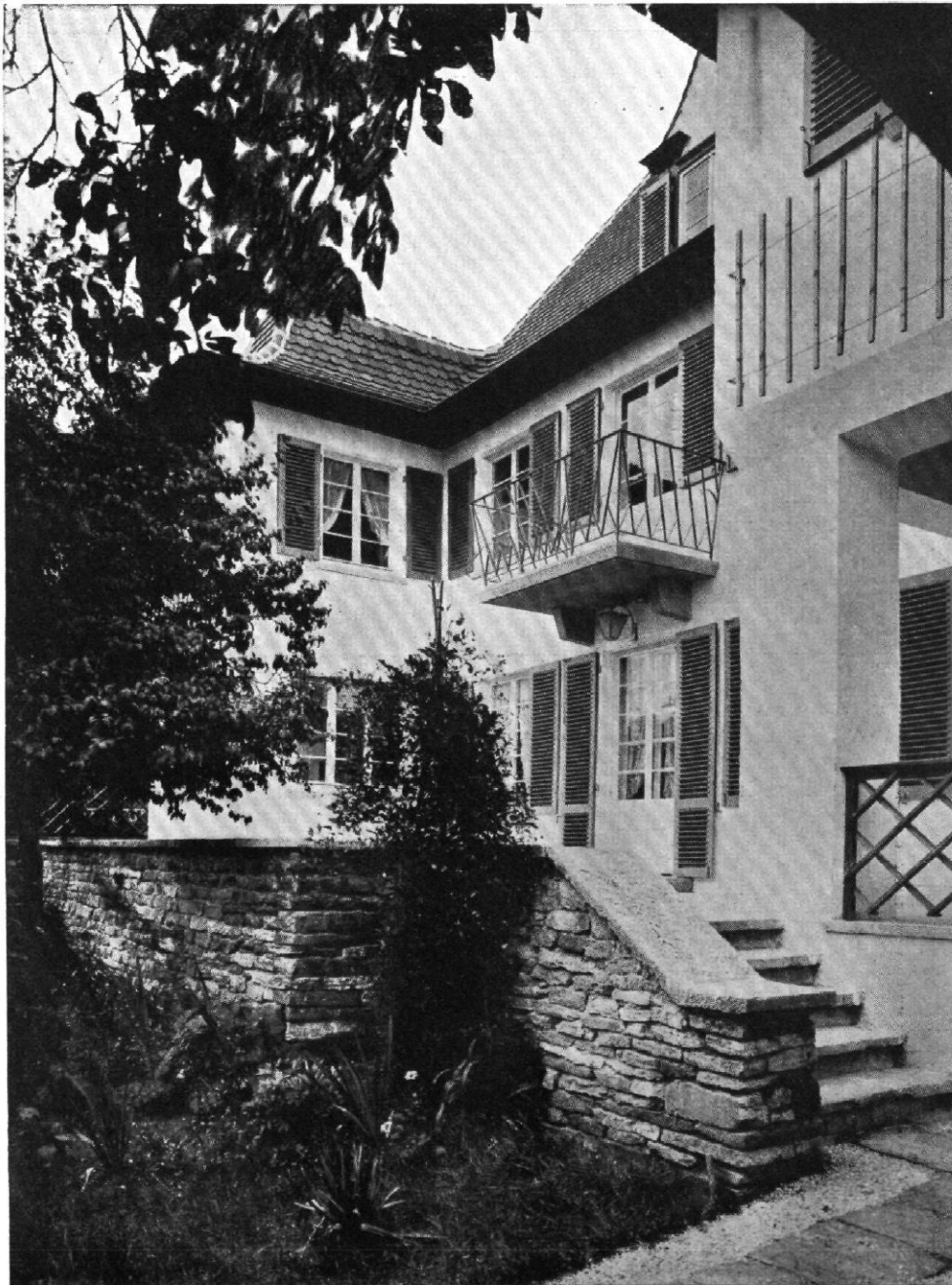
GARTENANSICHT EINES WOHNHAUSES IN STUTTGART
