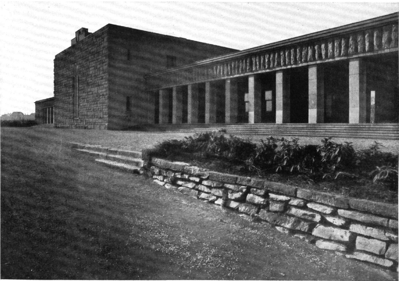
Abb. 5 und 6 | Friedhof Essen-Hottrop | Blick in den Ehrenhof vor der Einsegnungshalle, darunter Ansicht der Einsegnungshalle nach dem Friedhof | Erbaut 1925-26 Architekt: Ernst Bode, Essen vgl. Abb. 1 bis 4 und 7 bis 11
