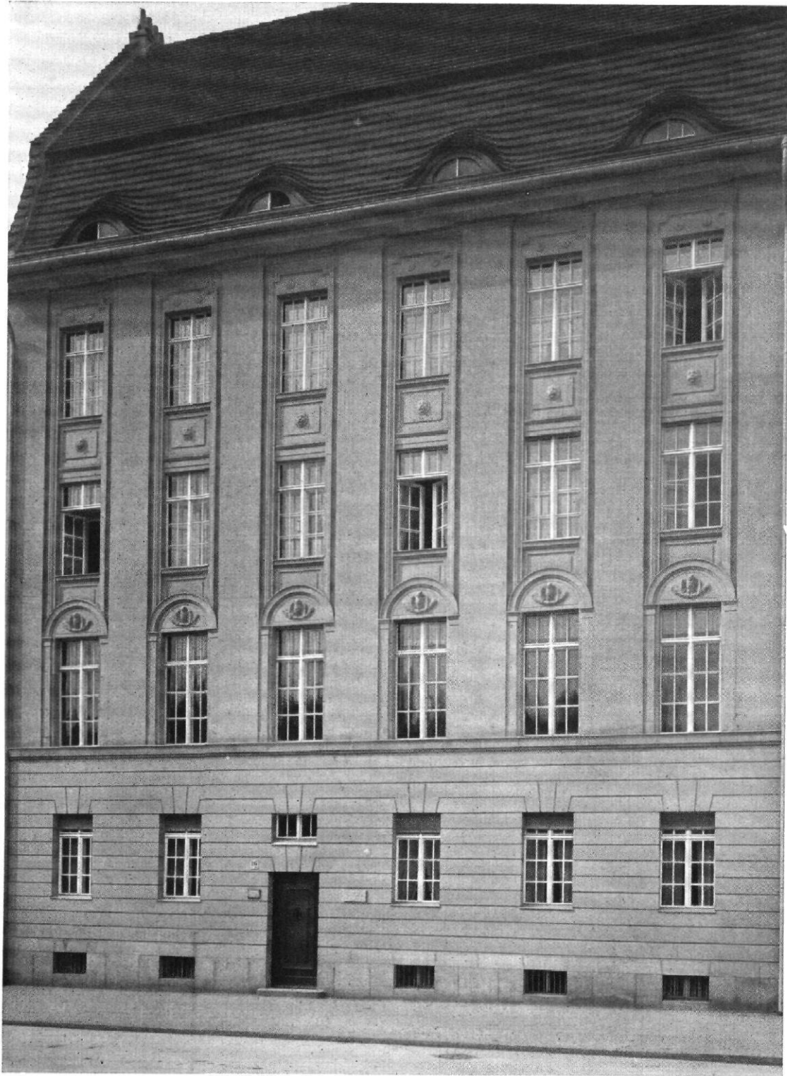
Abb. 61 / Lehrerwohnhaus an der Ofener Straße, Berlin Architekt: Ludwig Hoffmann, Berlin Straßenansicht
