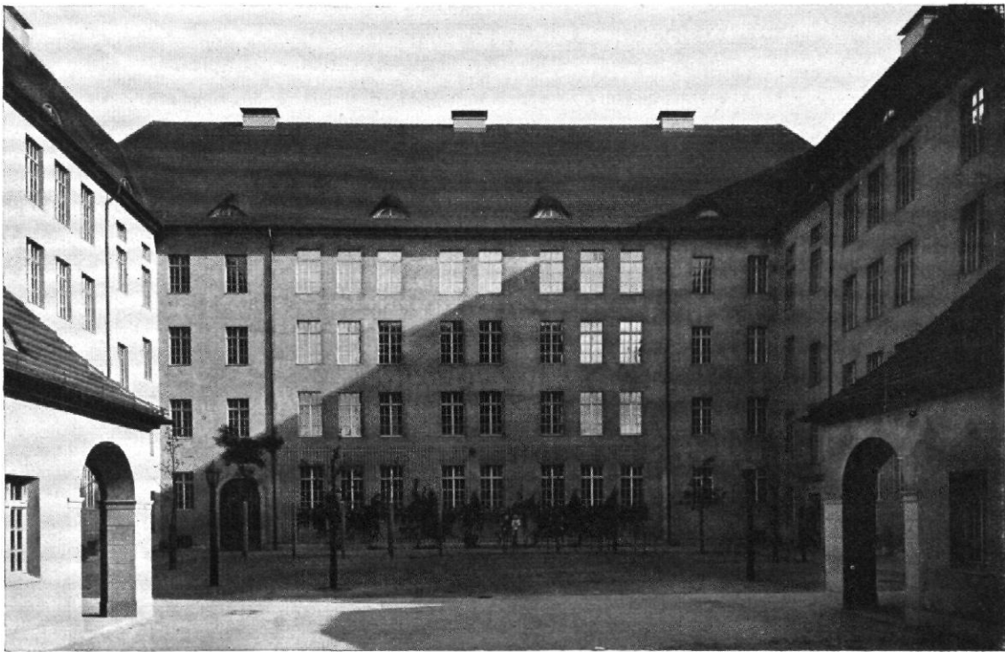
Abb. 42 | Schule an der Wehlauer Straße, Berlin | Architekt: Ludwig Hoffmann, Berlin Schulhof
