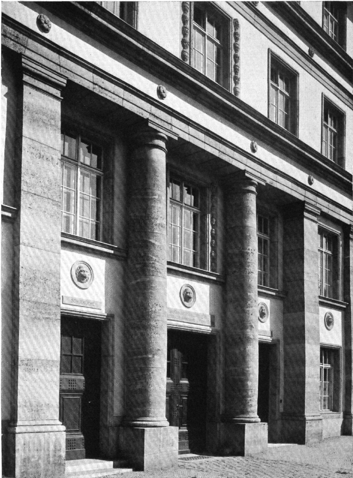
Abb. 84 / Verwaltungsgebäude an der Badstraße, Berlin / Architekt: Ludwig Hoffmann, Berlin / Teilansicht
