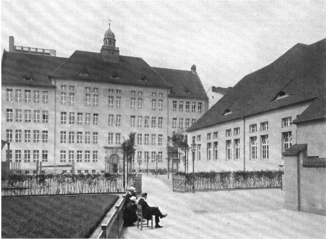
Abb. 41 | Schule an der Koppenstraße, Berlin | Architekt. Ludwig Hoffmann, Berlin Hofansicht
