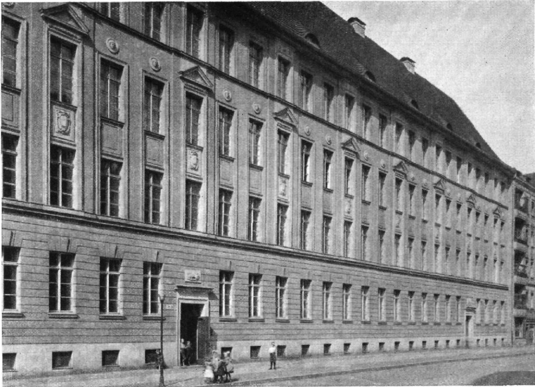
SCHULE AN DER MALPLAQUETSTRASSE IN BERLIN ARCHITEKT: LUDWIG HOFFMANN
