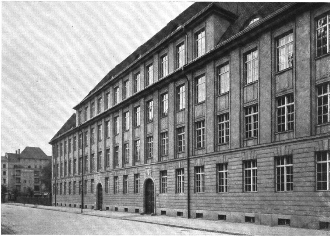
Abb. 73 | Schule an der Gothenburger Straße, Berlin | Architekt. Ludwig Hoffmann, Berlin Straßenansicht
