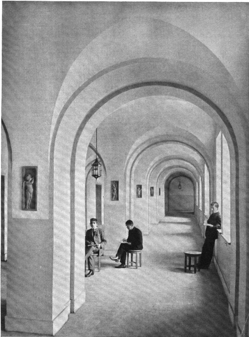
Abb. 44 | Schule an der Koppenstraße, Berlin | Architekt: Ludwig Hoffmann, Berlin Schulkorridor
