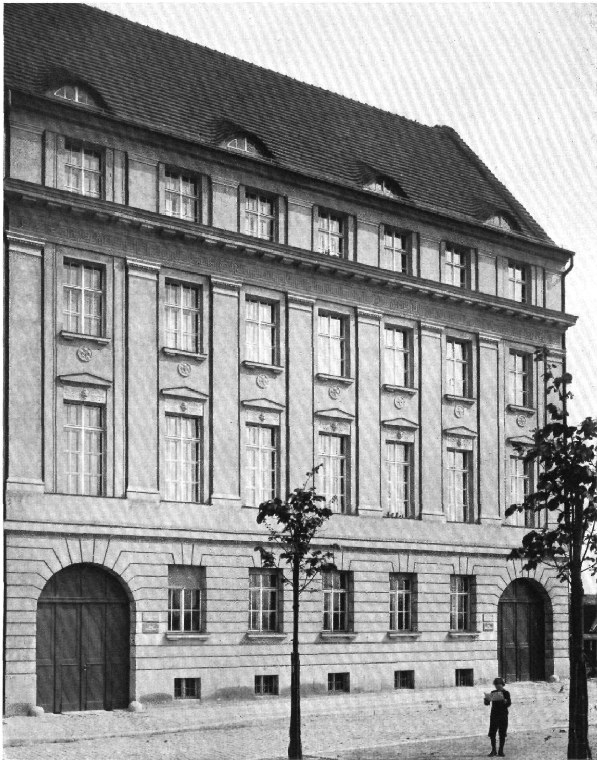
Abb. 37 | Lehrerwohnhaus an der Behmstraße, Berlin | Architekt: Ludwig Hoffmann, Berlin Ansicht
