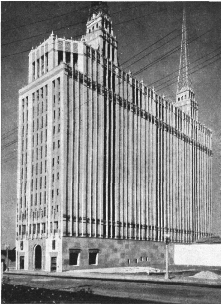
Bürogebäude in Hollywood / Architekten: Morgan, Walls & Clements Verkleinert nach: T. P. Bennett, Bauformen in Eisenbeton. Verlag Ernst Wasmuth A.G., Berlin
