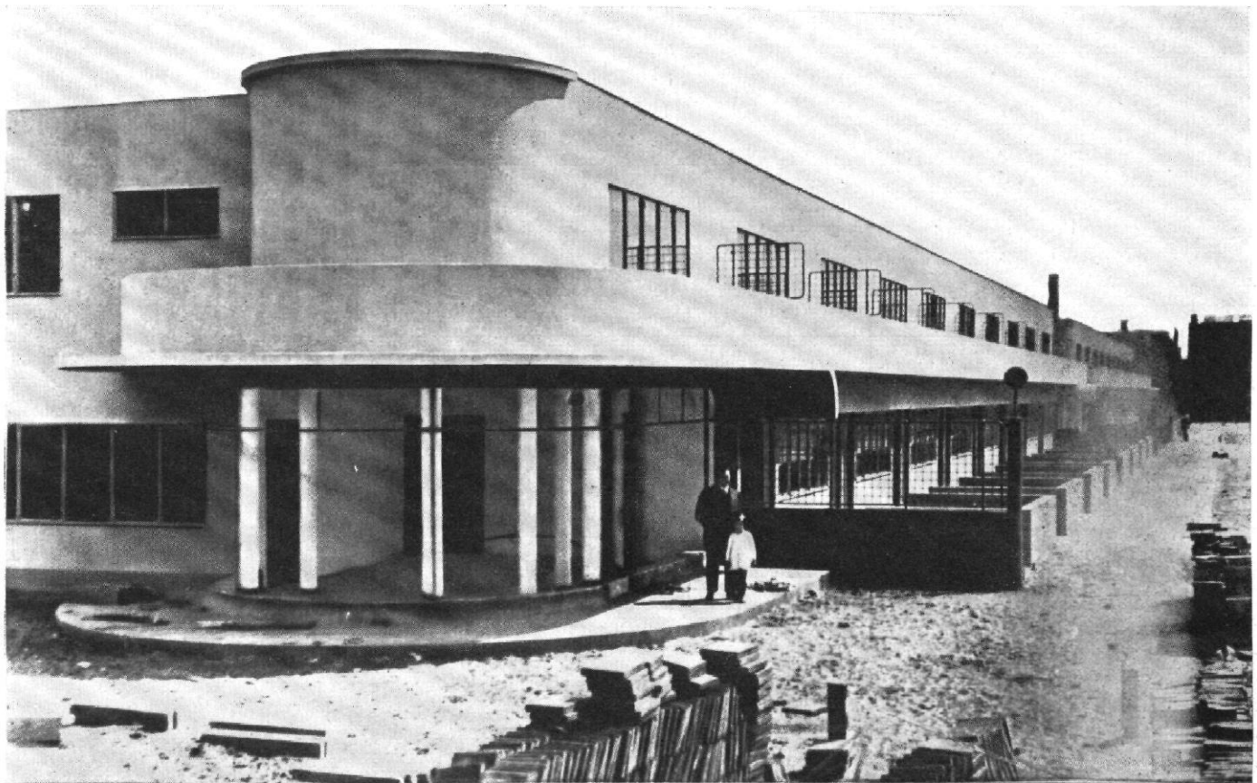
Abb. 5 und 6 / Reihenhäuser für Hoek van Holland im Bau / Architekt: J. J. P. Oud-Rotterdam vgl. Abb. 1 und W. M. B. 1927, Heft 1, Seite 35 ff.
