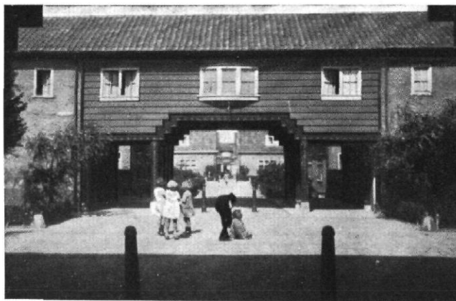
Abb. 16 | Gartenstadt Oostzaan bei Amsterdam | Wohnstraße
