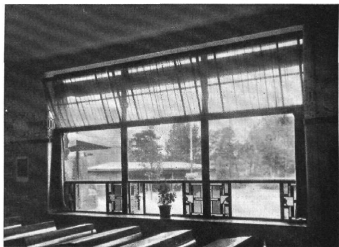
Abb. 38 | Elementarschule Utrecht | Architekten: Op ten Noort und Scheffer Fensterausbildung im Klassenzimmer
