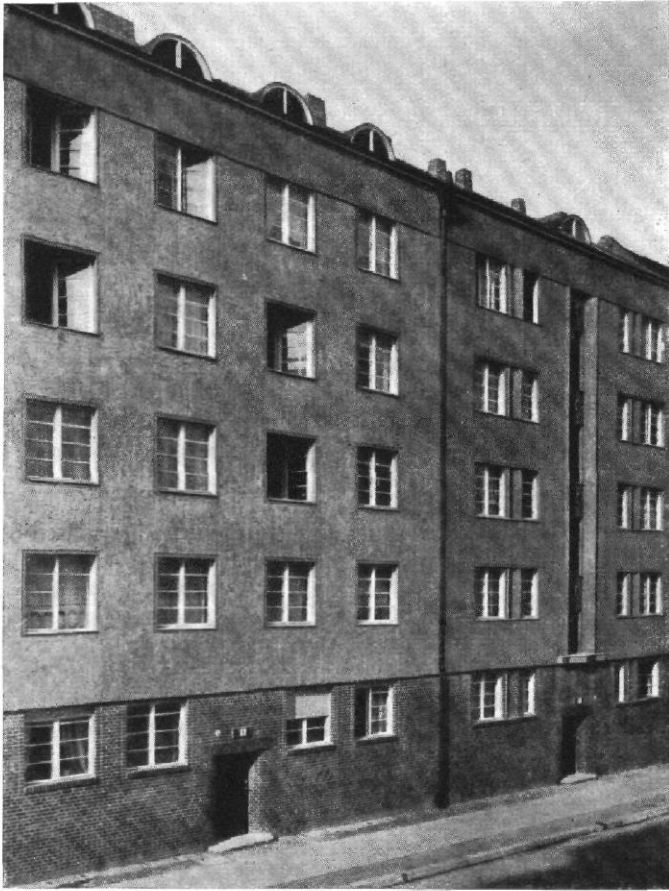
Abb. 3 | Wohnhäuser in der Spanheimstraße, Berlin
