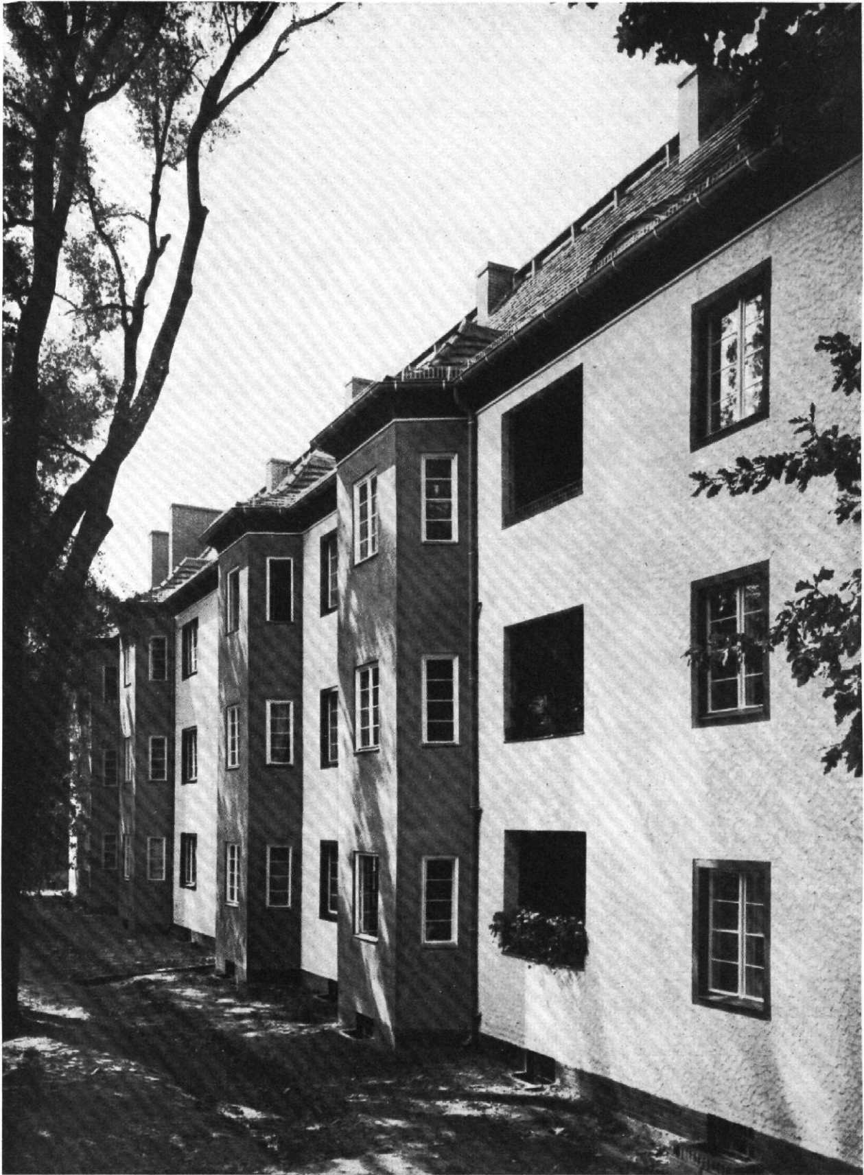
Abb. 4 / Wohnhausgruppe Berlin-Zehlendorf-Mitte / Teilansicht / Vgl. Abb. 1-3 und 5-6 Architekt: Franz Seeck, Berlin
