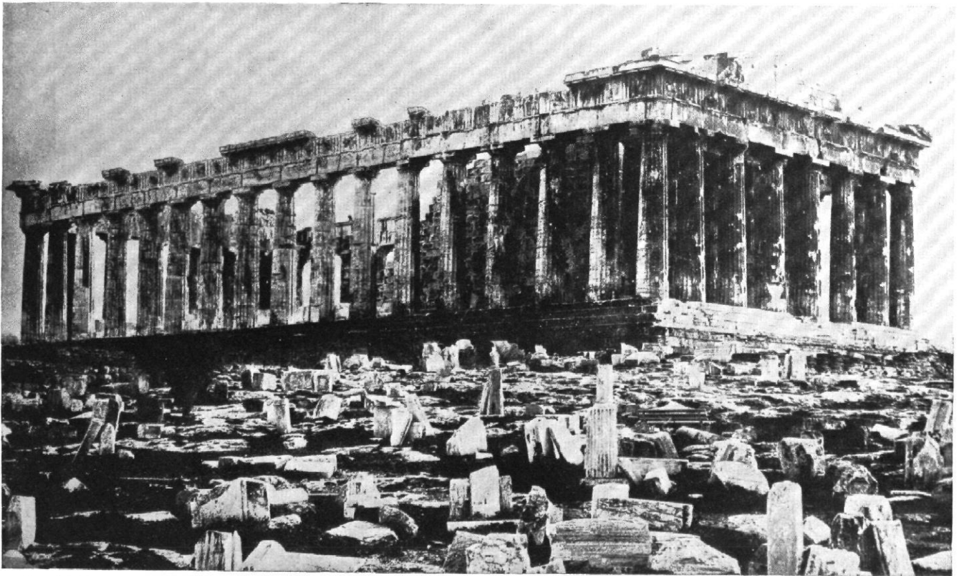
Abb. 3 | Der Parthenon in Athen nach Wiederaufrichtung der durch die Pulverexplosion von 1687 umgestürzten mittleren Säulen der Längsseiten | Vgl. Abb. 2 und Text S. 261
