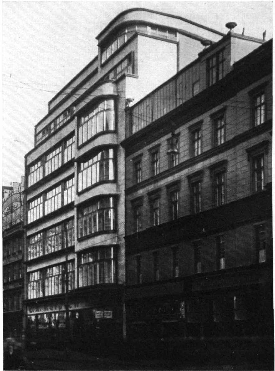
Abb. 19 | Umbau des Herpich-Hauses, Berlin | Architekt: Erich Mendelsohn, Berlin Vgl. Abb. 18, 20, 21 und Text S. 194
