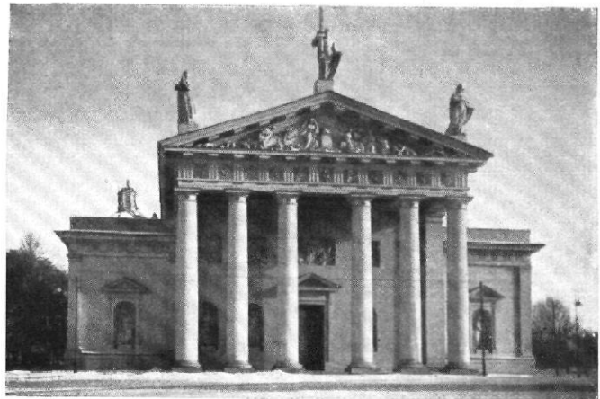
Abb. 9 | Dom in Wilna | Erbaut 1777 bis 1801
