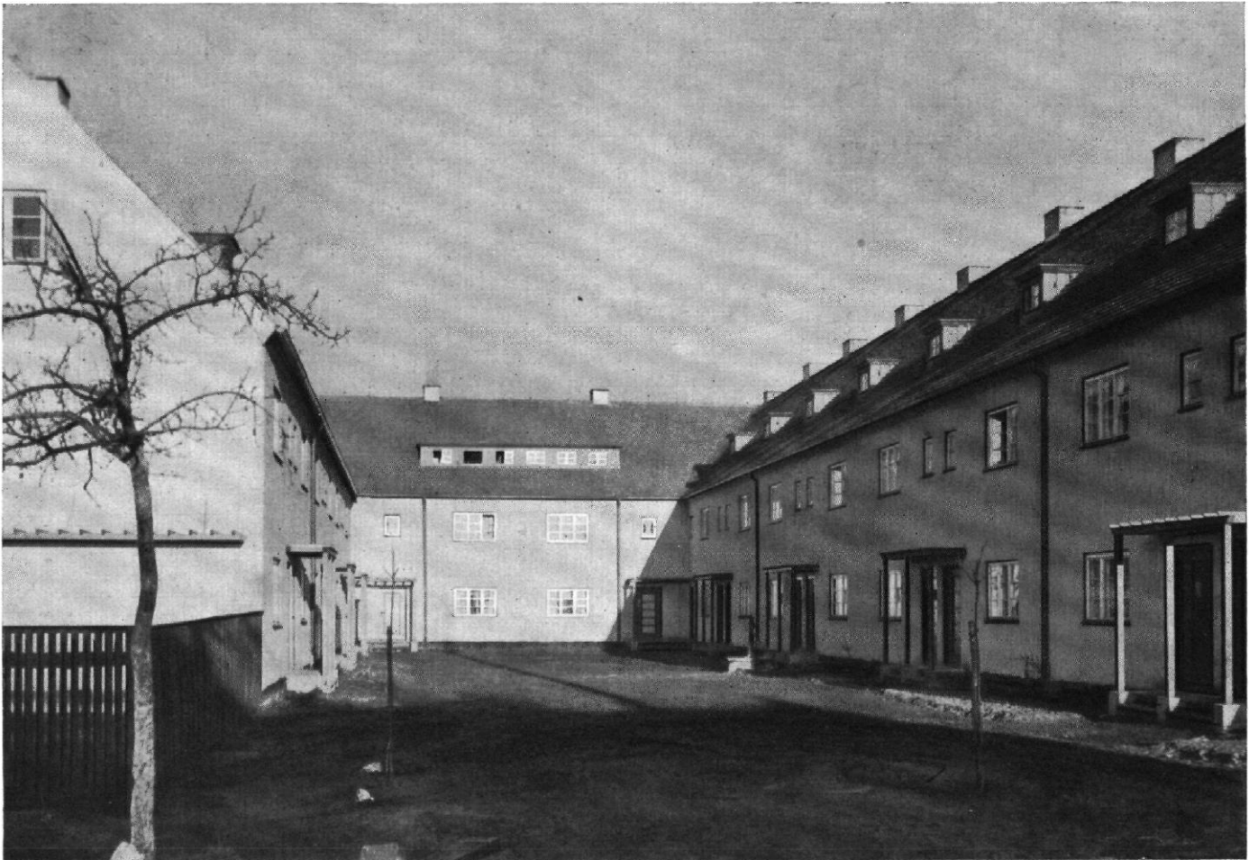
Abb. 13 | Siedlung Cawallen (Schlesien) | Architekt: „Schlesisches Heim“ (Leiter: Ernst May)
