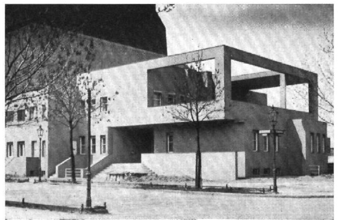
Abb. 6 / Weg mit dem flachen Dach! Mehr Licht!
