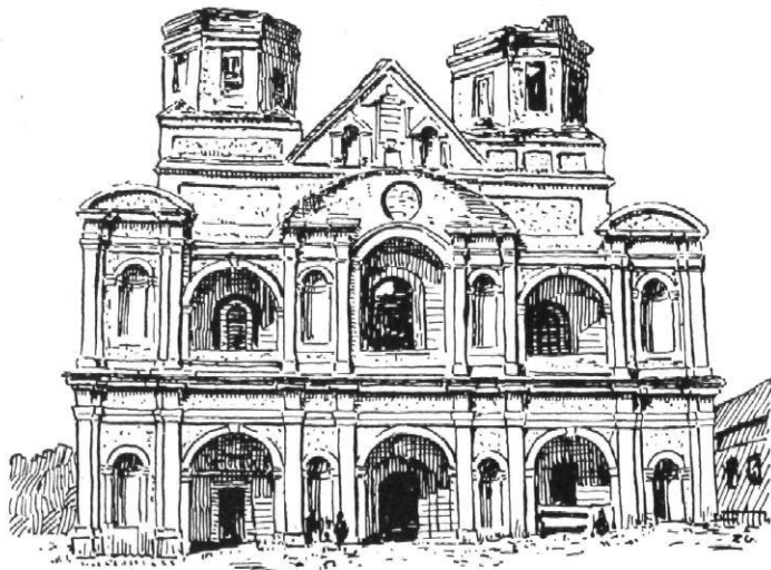
Abb. 1 | Fassade der Himmelfahrtskirche zu Wolodymir in Wolhynien
