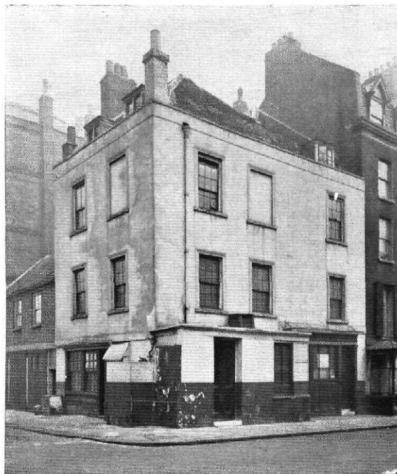
Abb. 10 / Wohnhaus in London Mayfair, No. 6 John Street Ansicht vor dem Umbau / vgl. Abb. 26
