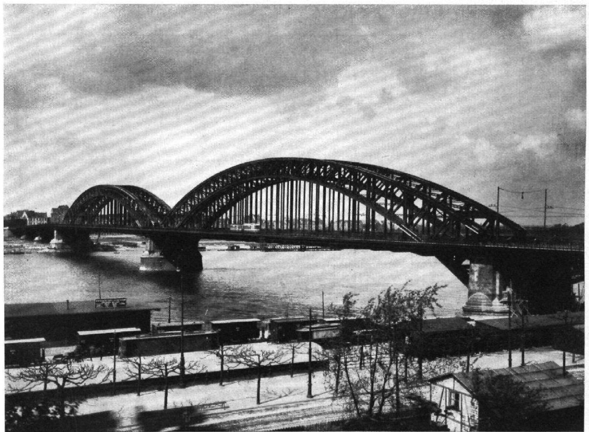
Abb. 1 u. 2 / Umgestaltung der Rheinbrücke in Düsseldorf Oben: vor dem Umbau / Unten: Neugestaltung der Brücke Architekt: Lyonel Wehner, Düsseldorf
