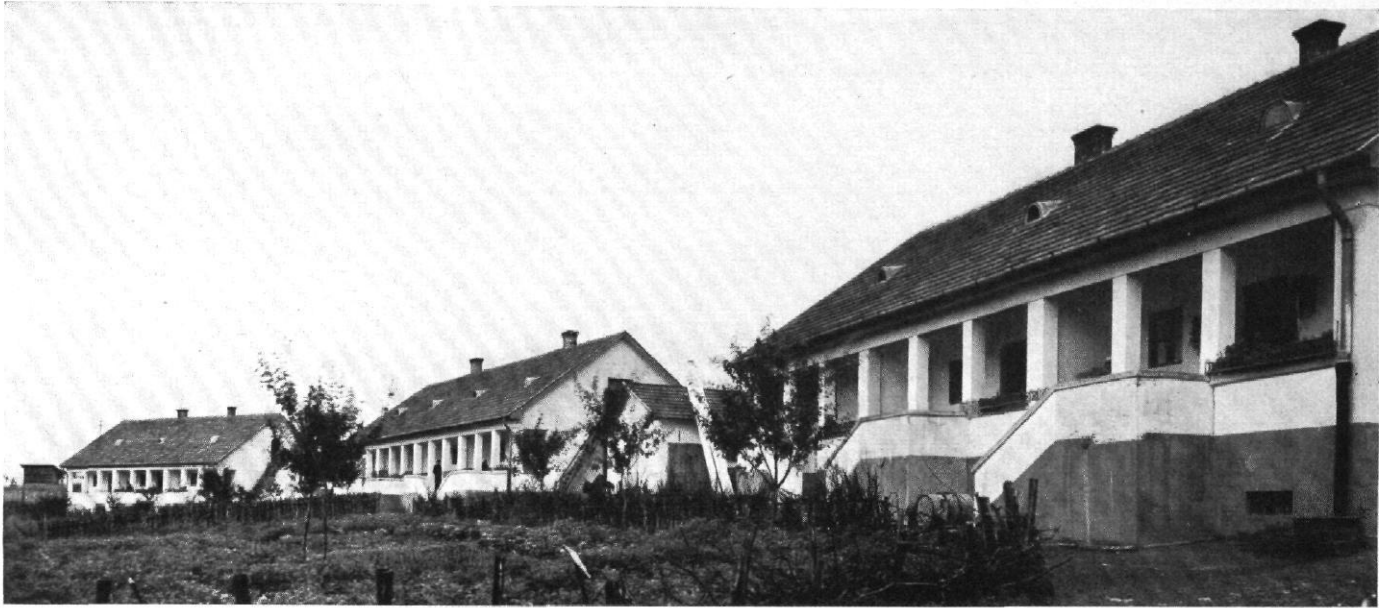
Abb. 4 / Arbeiterwohnhäuser des Gräflich Béla Zichyschen Manganbergwerkes in Urkut, Ungarn (1924) Architekt: Erwin von Quittner, Budapest
