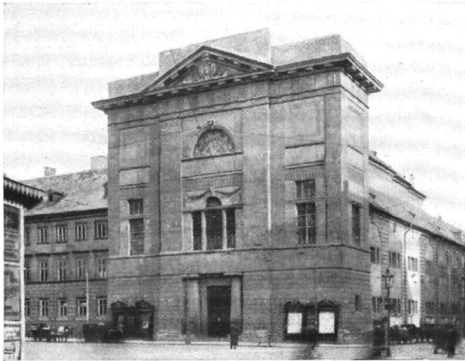
Abb. 24 / Prag / Zollgebäude am Platz der Republik
