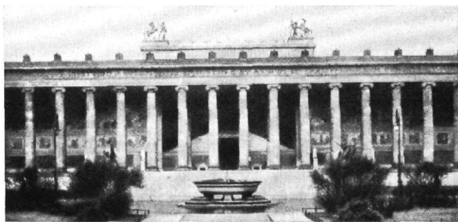
Abb. 4 / Altes Museum in Berlin / Architekt: Karl Friedrich Schinkel / Hauptansicht Beispiel einer offenen Treppenhalle mit besonderer Nische für die Treppenläufe, die sich so räumlich und maßstäblich gut in den Baukörper eingliedern
