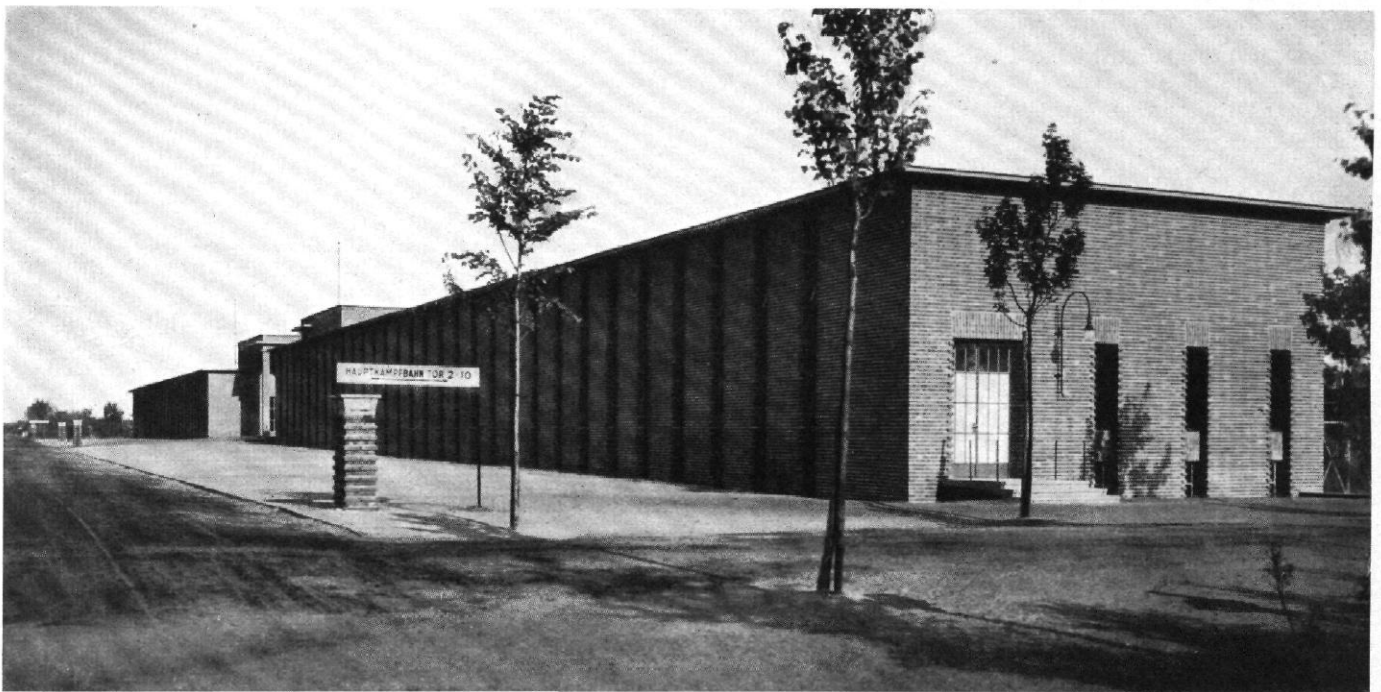
Abb. 12 und 13 / Kampfbahn zu Köln / Architekt: Baudirektor Adolf Abel, Hochbauamt Köln Sporthallen und Umkleideräume von der Aachener Straße aus
