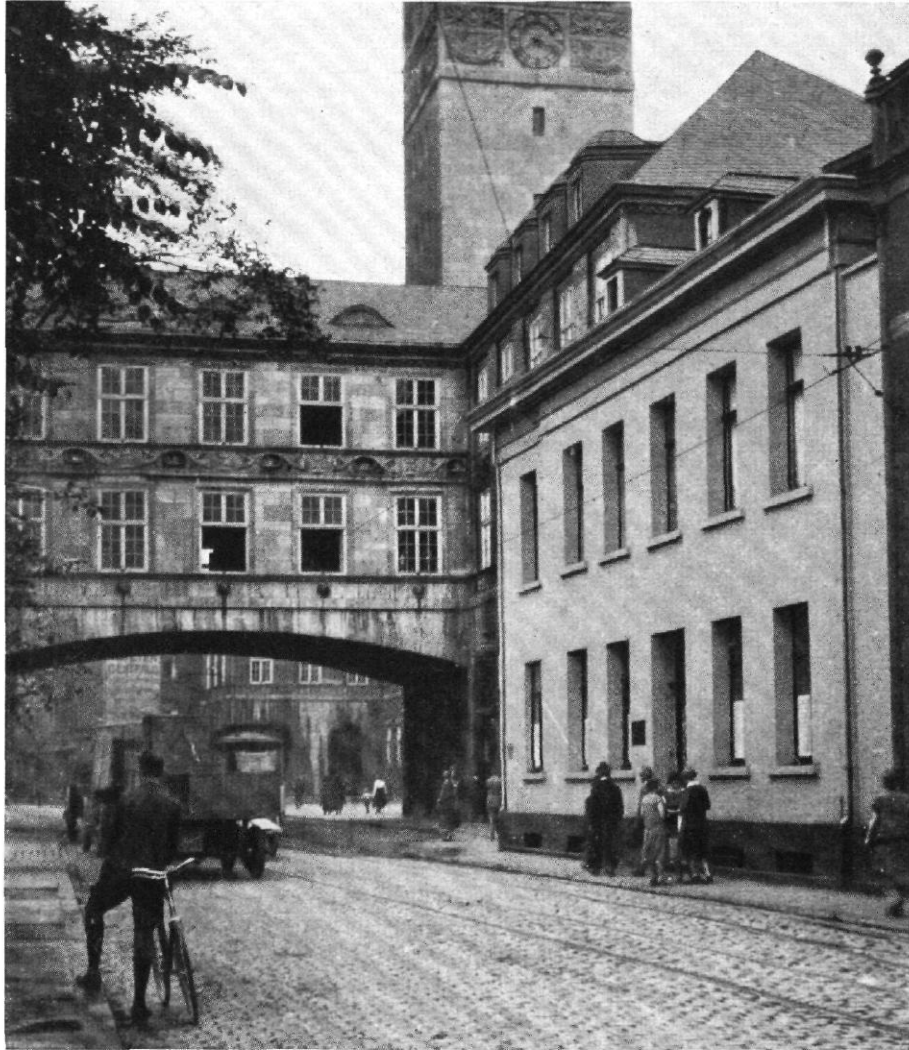
Abb. 26 / Rathaus in Mülheim / Architekten: Pfeifer und Großmann, Mülheim Vgl. den Gegensatz zwischen dem überreichen Schmuck des Rathauses und der „modernen“ Strenge des Hauses (rechts) aus der ersten Hälfte des 19. Jahrhunderts / Vgl. Abb. 21
