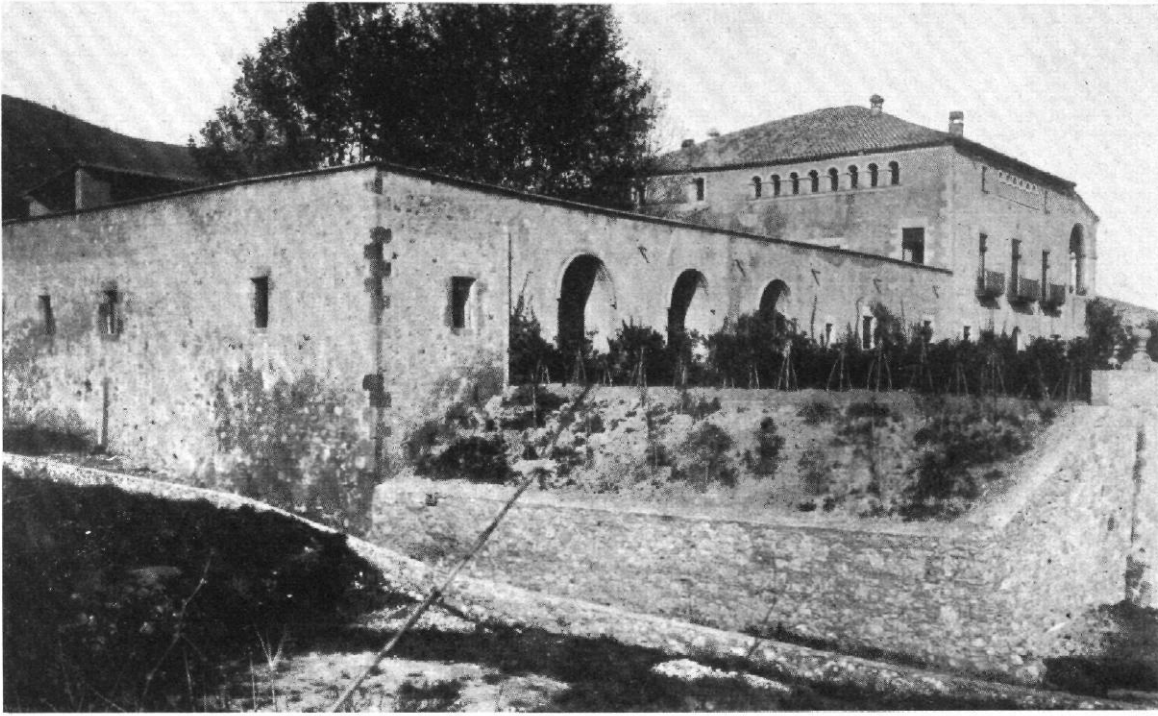
Abb. 5 / Landhaus Guell in Pedralves bei Barcelona
