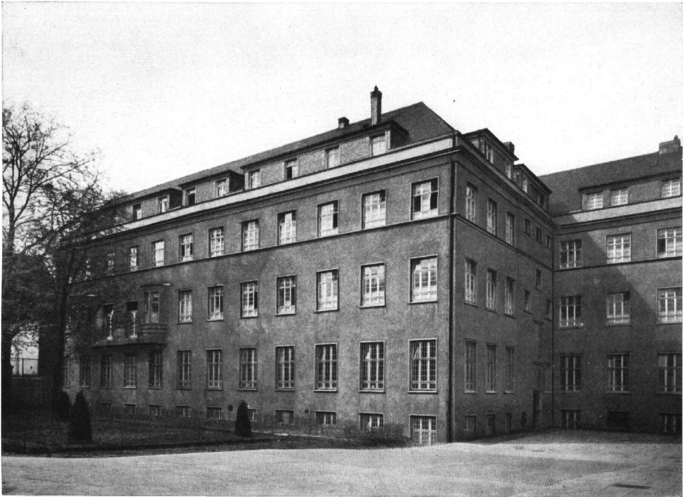
Abb. 8 / Verwaltungsgebäude der Bergbau A.G. Lothringen / Architekten: Fritz August Breuhaus und Heinrich Rosskotten Hofansicht
