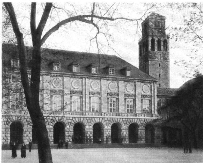
Abb. 25 / Rathaus in Mülheim / Architekten: Pfeifer und Großmann, Mülheim Haupteingang
