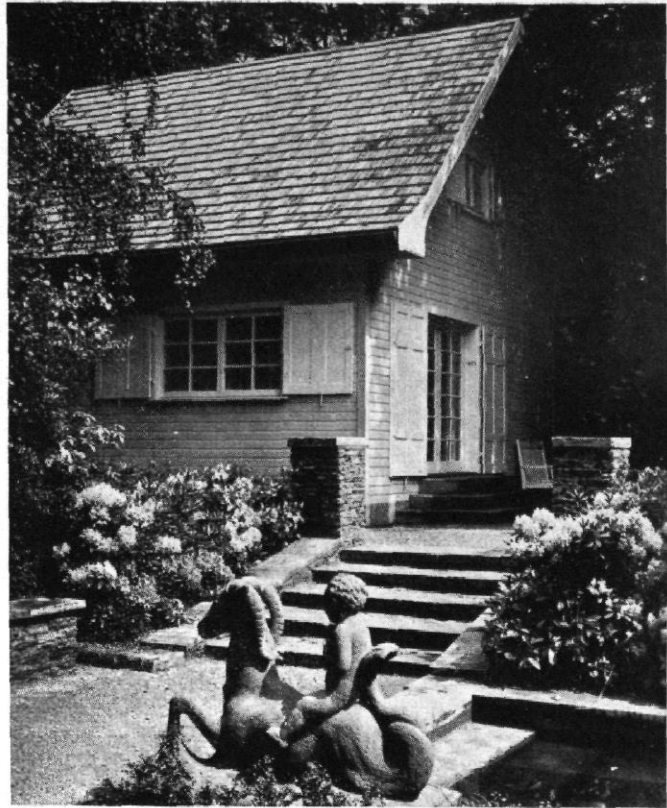
Abb. 1 / Gartenbauausstellung in Dresden Ferienhaus der Deutschen Werkstätten Hellerau / Architekt: Karl Bertsch Eckansicht des Hauses mit Garten nach dem Entwurf von Gustav Allinger, Berlin
