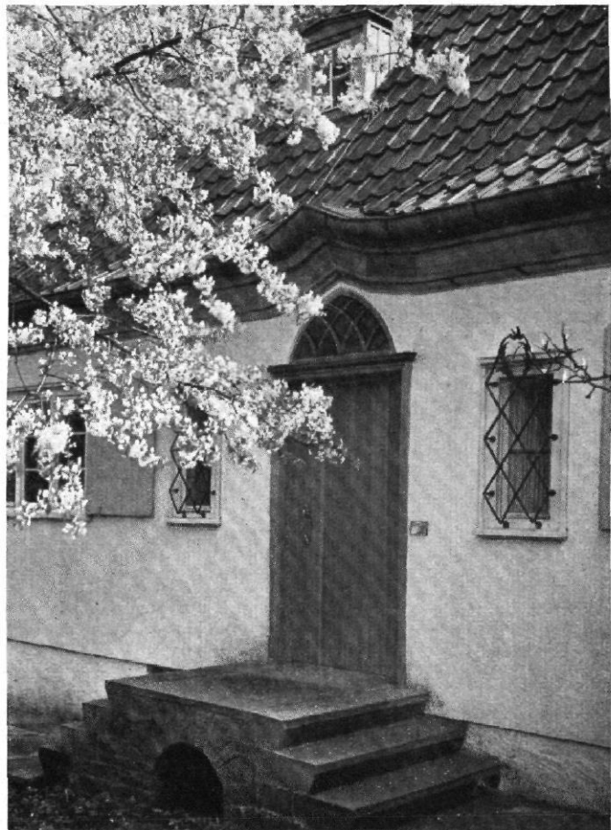
Abb.11 / Haus Schmitthenner in Stuttgart / Architekt: Paul Schmitthenner, Stuttgart Eingangstür Ausführung in Lärchenholz massiv auf Einschubleisten
