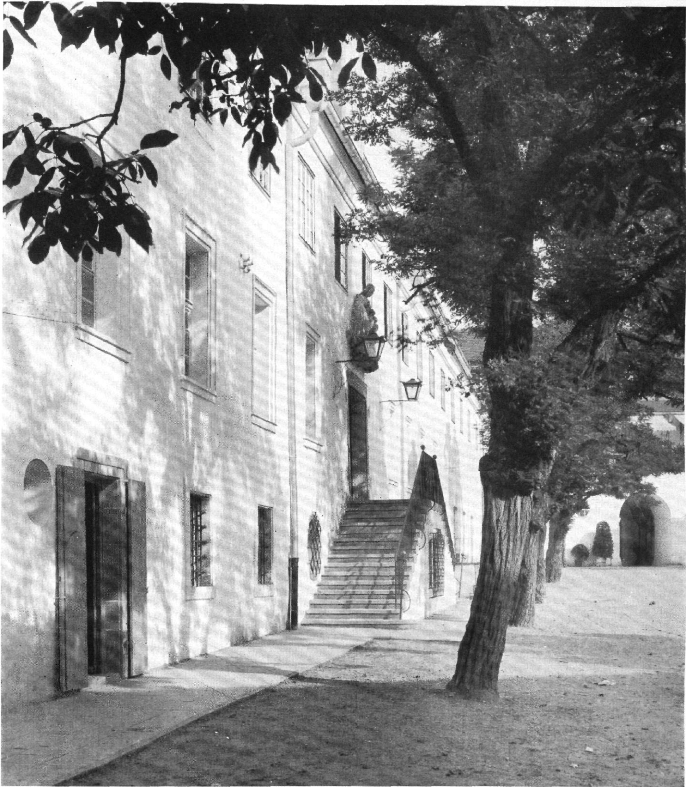
Abb. 24 / Haus des Deutschtums in Stuttgart / Architekt: Paul Schmitthenner, Stuttgart / Erbaut 1924/25 / Freitrepppe im Hof zum Deutschen Auslandsinstitut Material: Muschelkalk und Schmiedeeisen / Plastik über der Tür: „Mutter Deutschland“ in farbigem Zement von Bildhauer Wilhelm Fehrie, Gmünd / (vgl. Abb. 29)
