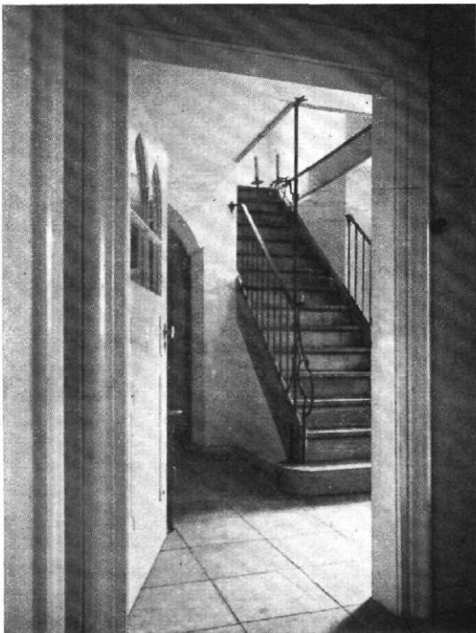
Abb. 13 / Haus Schmitthenner in Stuttgart Architekt: Paul Schmitthenner, Stuttgart / Erbaut 1922 Treppenhaus Wägen in Kiefernholz, Stufen Eichenholz, Fußboden Solnhofer Platten
