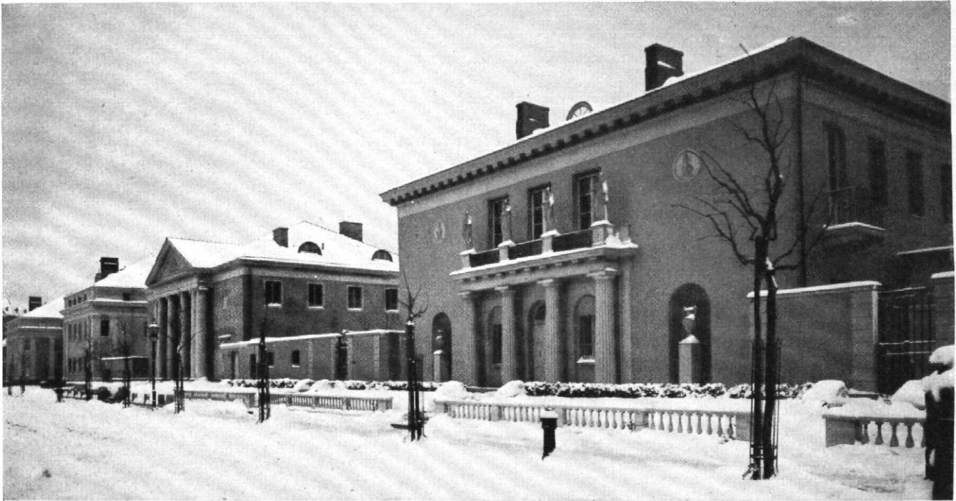
Abb. 15 (oben) / Blick in die Ballenstedter Straße, Berlin-Wilmersdorf / Architekt: Alexander Klein
