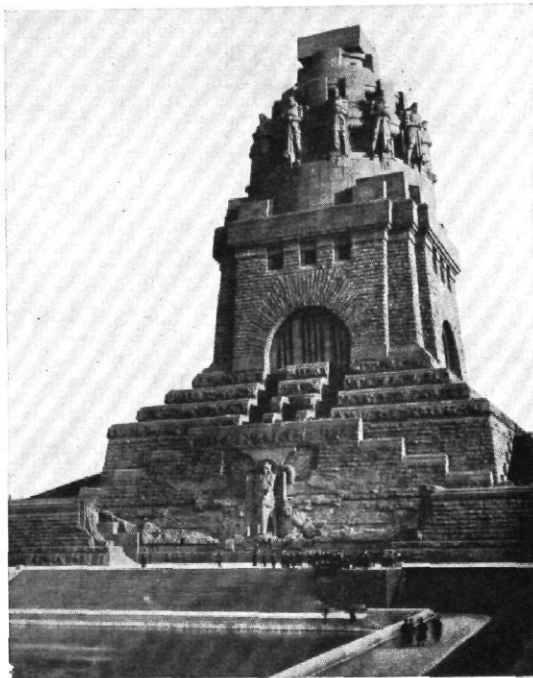
Abb. 2 / Völkerschlachten-Denkmal in Leipzig Architekt: Bruno Schmitz
