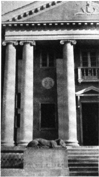
Abb. 21 / Haus D., Berlin - Wilmersdorf Architekt: Alexander Klein Einzelheiten des Haupteingangs
