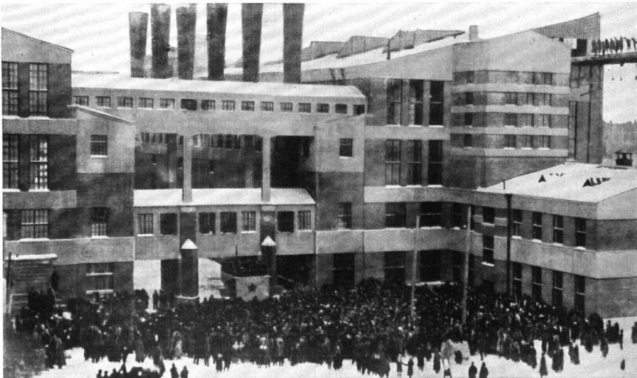
Abb. 2 / Torfkraftwerk Schaturka bei Moskau / Das Werk entwickelt 65000 PS
