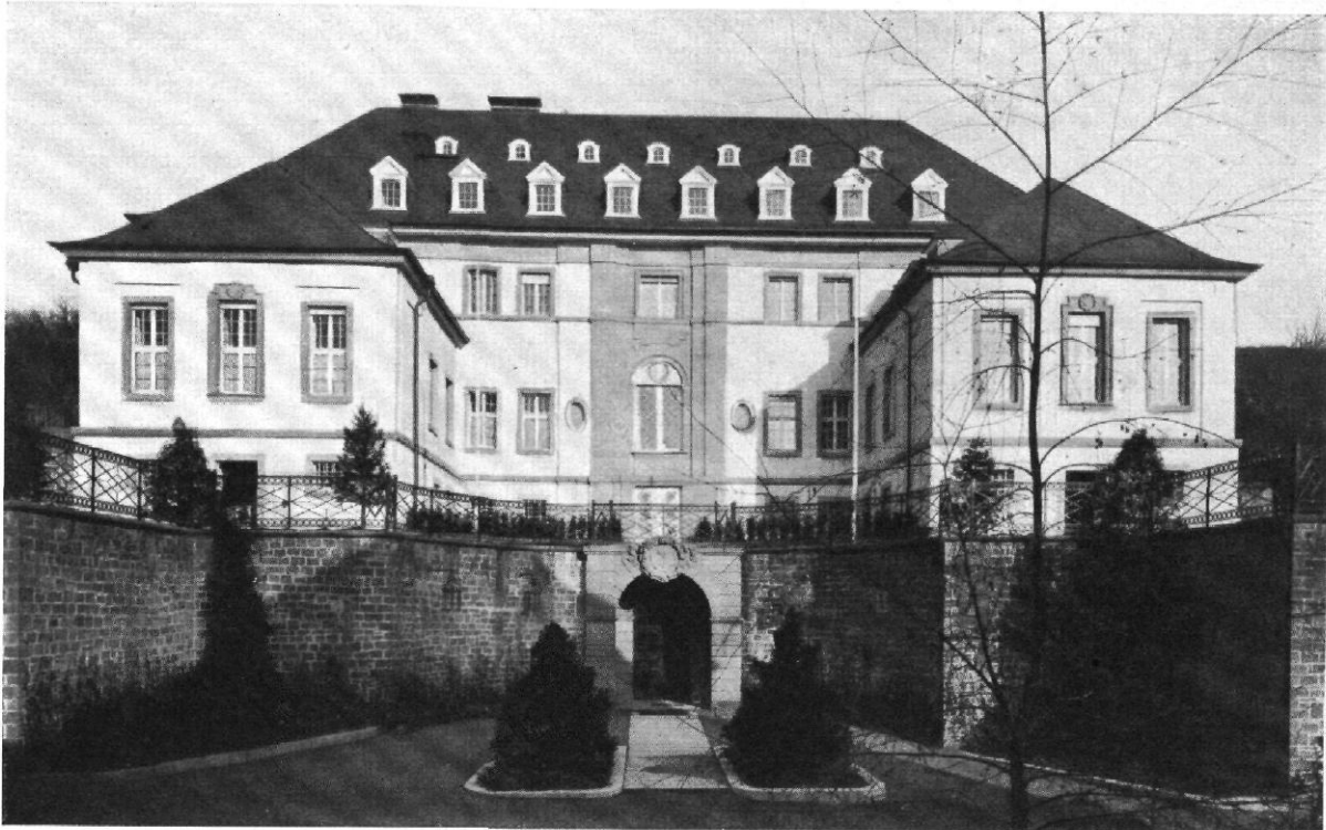
Abb. 6 / Haus Krehl in Heidelberg / Architekt: Friedrich Ostendorf / Straßenansicht
