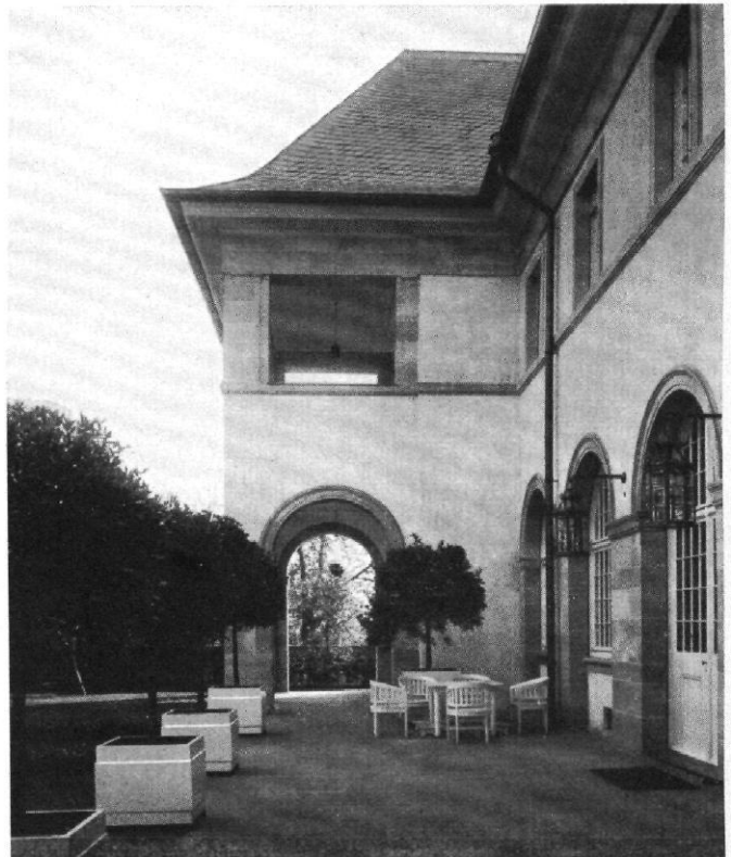
Abb. 7 / Haus Krehl / Terrasse
