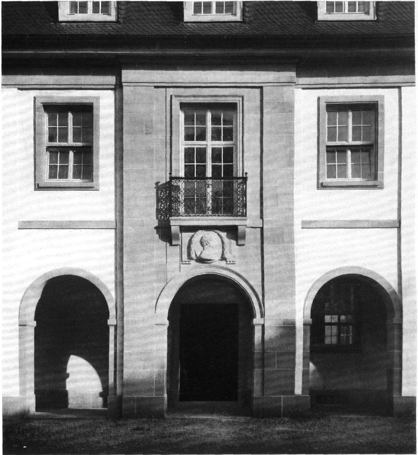
Abb. 1 / Staatsschuldenverwaltung in Karlsruhe / Architekt: Friedrich Ostendorf, 1913
