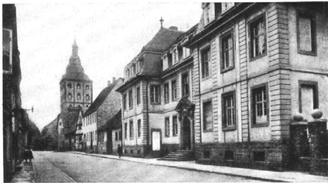
Abb. 8 / Kreisbaus in Lippstadt / Architekt: Friedrich Ostendorf Der letzte ausgeführte Bau Ostendorfs. Das anschließende alte eingeschossige Haus ist zweigeschossig zu denken
