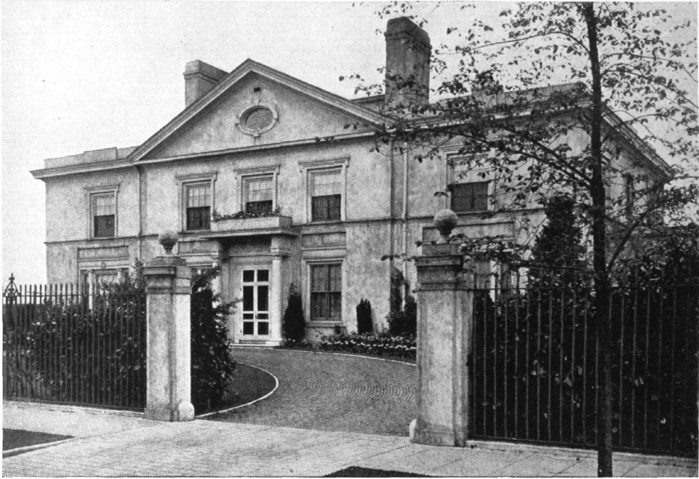
Abb. 3 / Ansicht von der Straße (Die dunkle Schattierung der unteren Hälften der Fenster sowie der Tür stellt die Fliegengitter dar, welche in den meisten amerikanischen Häusern im Sommer eingesetzt werden.)
