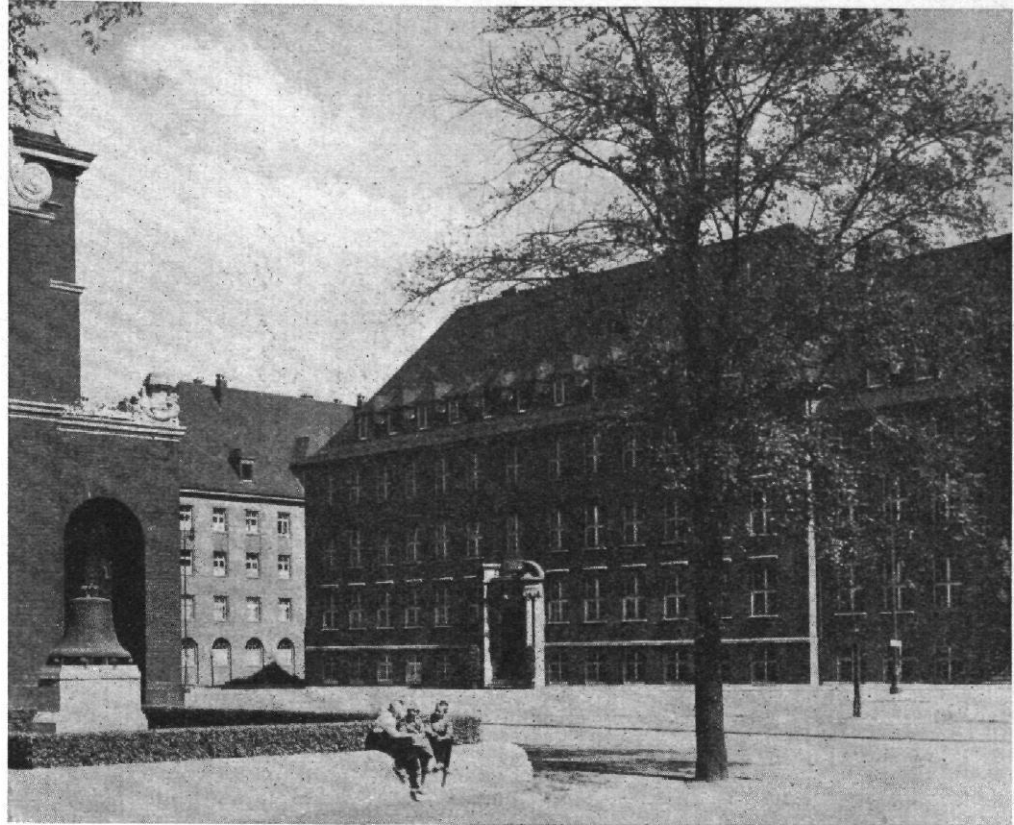
Abb. 6-7 / Das Oberlyzeum in Bottrop Architekten: Hans Petersen und Albert Lange
