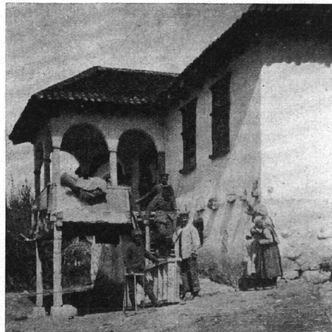
Abb. 11 (rechts) / Dreiräumiges Bauernhaus in Brezine bei Nisch / Um einen Mittelraum, der gleichzeitig Herdraum ist, gruppieren sich zwei Wohnräume und die offene Veranda. Auch hier Lehmfachwerk auf massivem Sockelmauerwerk.
