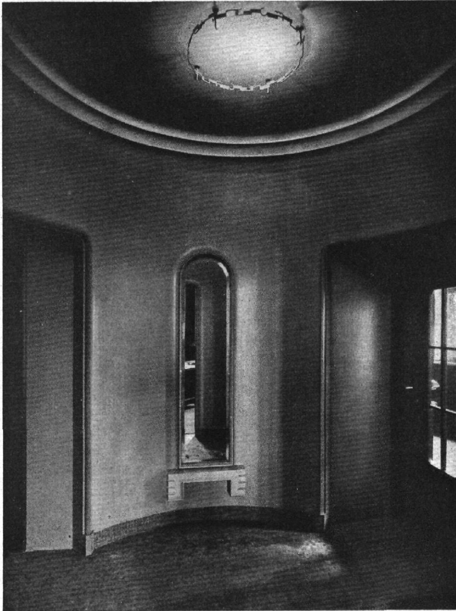
Abb. 9 / Bank S., Hamburg / Vorraum
