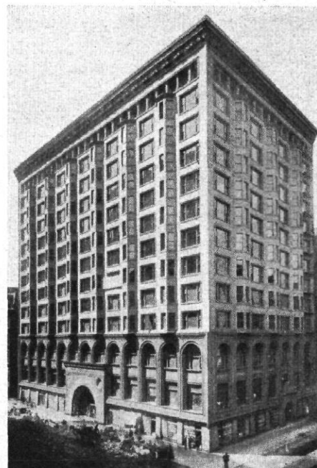
Abb. 16 / Börse. Chicago Architekt: Louis Sullivan
