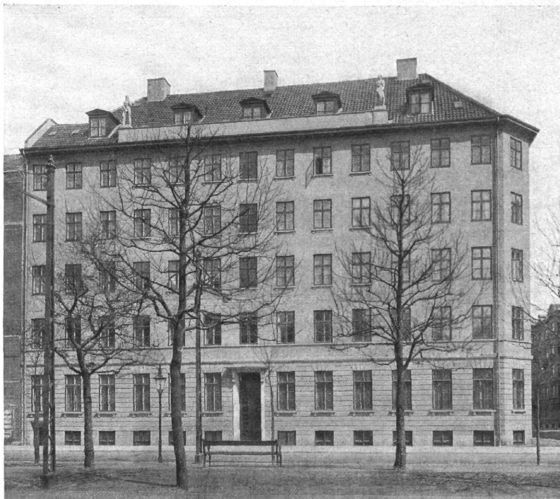
Abb. 1 / Wohnhaus. Kopenhagen, Strandboulevard / Architekt: C. Mohnberg
