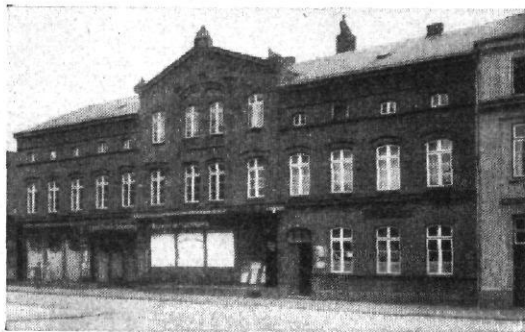
Zweiter Bauabschnitt vor dem Umbau
