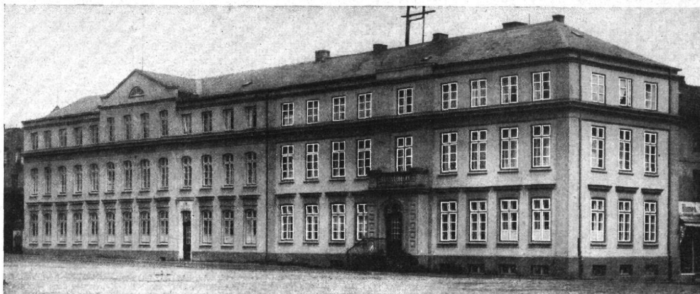
Erster und zweiter Bauabschnitt nach dem Umbau
