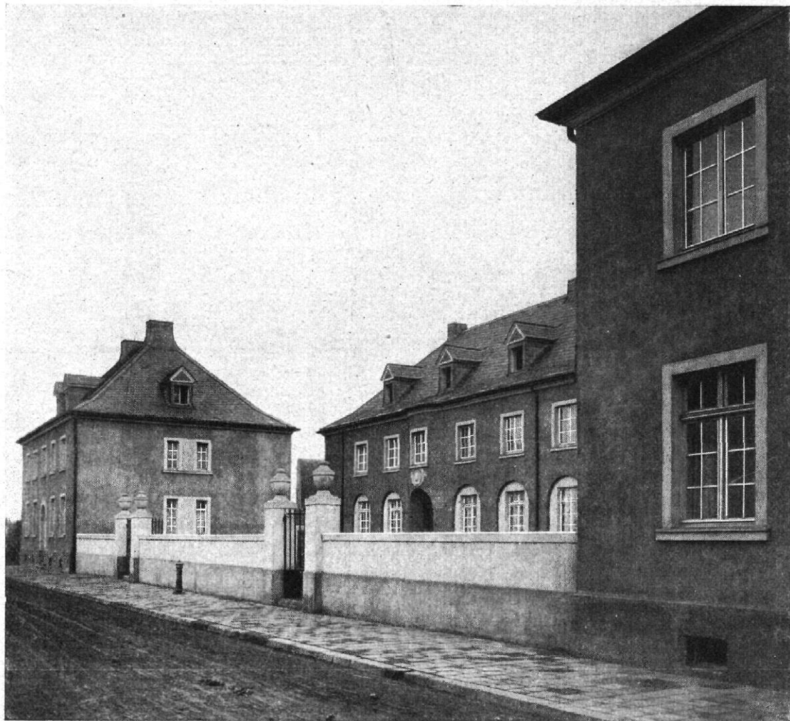
Abb. 15 / Wohnbauten Eschweiler I (vgl. Abb. 14) Blaugrauer Putz mit helleren Einfassungen u. Blenden Bildhauerarbeiten von Neu- mann, Aachen Architekt: Otto Karow B. D. A.
