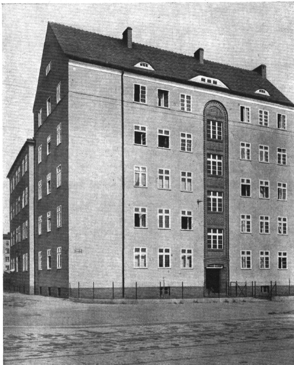
Abb. 1 / Mietshaus Piastenstraße Breslau. Erbaut 1923 / Architekt: Theo Effenberger, geb. 1892 Die flächige, aufwandslose Behandlung der Schauseiten wirkt in der Umgebung der Mietshäuser der Vorkriegszeit sehr sympathisch. Auffallend ist das Fehlen der Austrittsmöglichkeit aus den Wohnungen.
