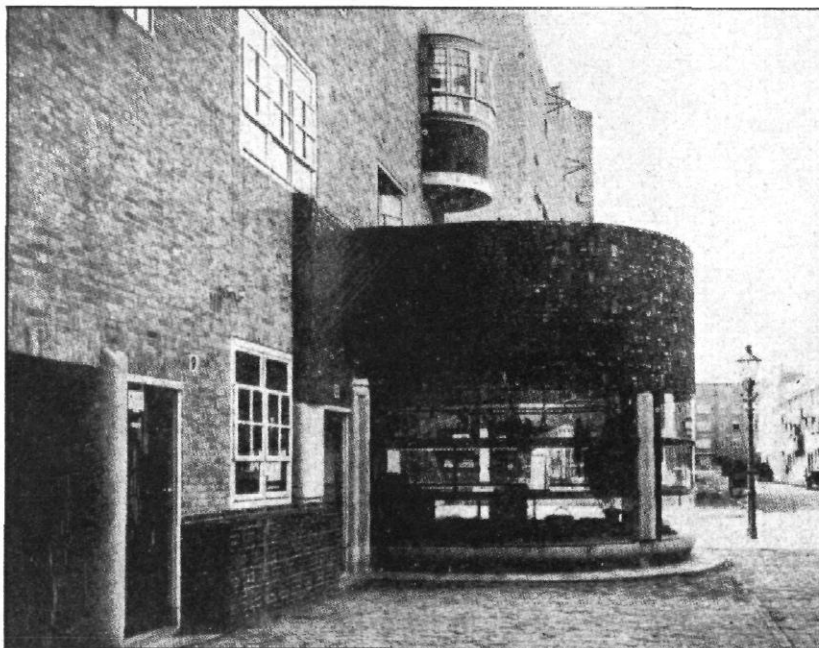
Abb. 13 / Laden, Amsterdam, erbaut 1920-1921 / Architekt: M. de Klerk (Die Druckstöcke von Abb. 11, 13 15-17 wurden von der „Deutschen Bauzeitung“ dankend entliehen.)
