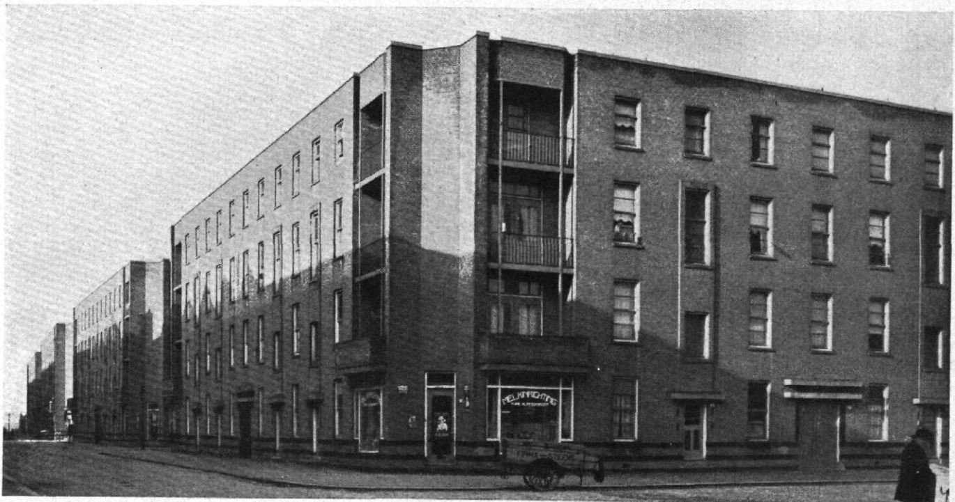
ABB. 2 UND 3 / „VOLKSWOHNUNGSBAU“ „TUSSCHENDIJKEN“ ROTTERDAM OBEN: BLOCK II / UNTEN: BLÖCKE I-IV / (ALLE ERBAUT: 1920) ARCHITEKT: J. J. P. OUD
