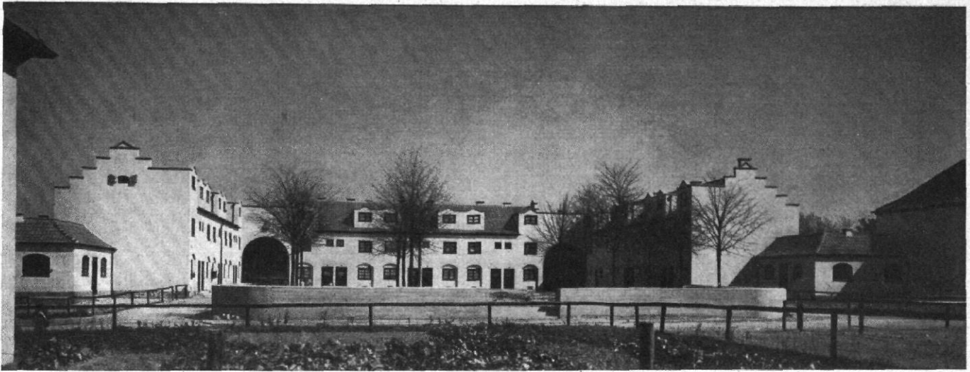
Abb. 24 / Aus der Siedlung Mauenheim, Gruppe erbaut 1920
