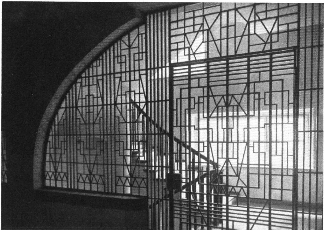
GITTERABSCHLUSS IM TREPPENHAUS
