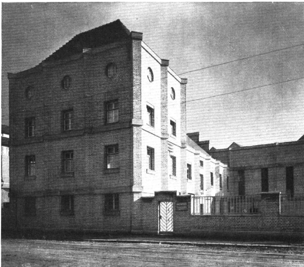
ABB. 11 UND 12 / RHEINSTAHL, STUTTART ARCHITEKT: E. FAHRENKAMP
