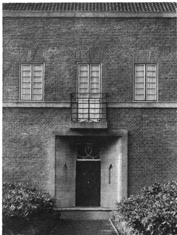
ABB. 19 / EINGANG ZU DEN WOHNÜNGEN DER KRAFTWAGENFAHRER
