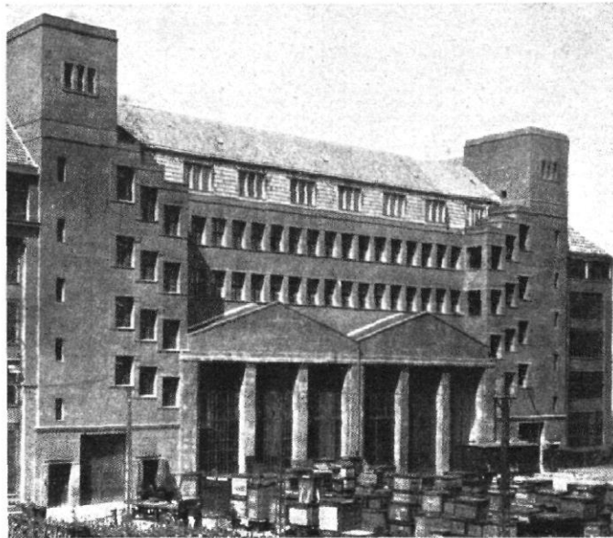
Abb. 32 / Hochspannungsfabrik der A.E.G. am Humboldthain, Berlin (1910)
